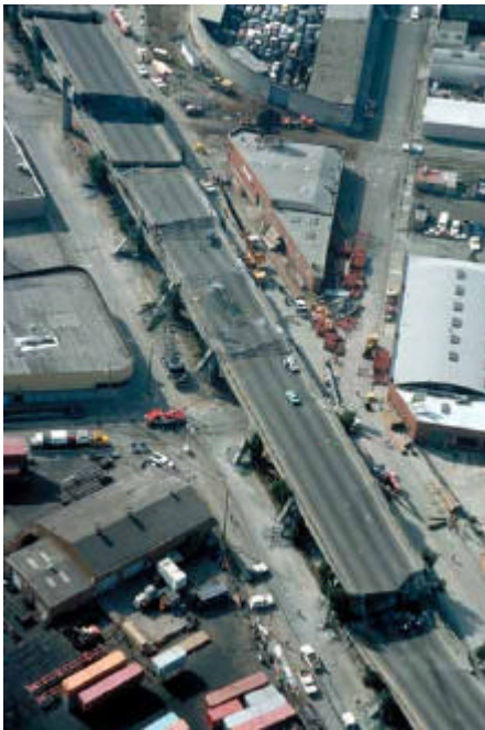
Figura 1.2. Colapso del Viaducto de la calle Cypress, atribuido a una mala concepción sismorresistente. (EQE International 1979)
