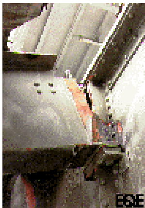
Figura 1.3. Fallo de los conectores de rodamiento del vano (EQE International 1979).
