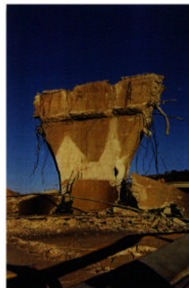
Figura 1.4. Daño sufrido en el puente #53-1960F. Colapso del pórtico 1 y acercamiento del eje 3. (Priestley et al. 1994).
