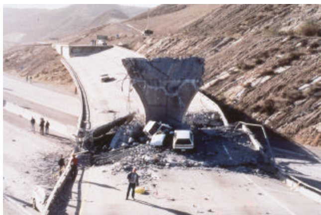
Figura 1.4. Daño sufrido en el puente #53-1960F. Colapso del pórtico 1 y acercamiento del eje 3. (Priestley et al. 1994).
