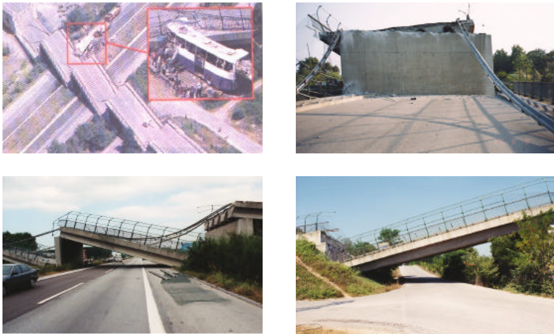
Figura 1.11. Diferentes vistas del colapso del paso superior de Arifiye. El fallo del puente fue principalmente ocasionada por la presencia de una falla geológica en los apoyos del puente. (Mander 1999 a y 1999 b)
