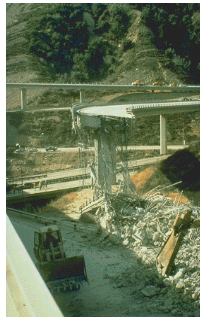
Figura 1.8. Paso a desnivel Gavin Canyon. Fase del proceso de demolición (izquierda) y fallo en los cables de restricción (derecha) (Priestley et al. 1994).
