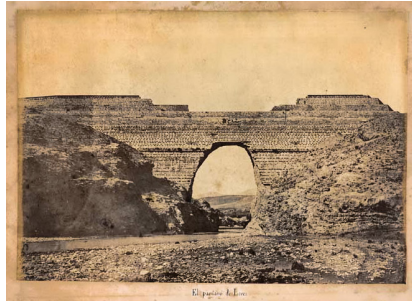
Figure 3.3: Puentes dam after destruction, Lorca. Image from Confederación Hidrográfica del Segura.
