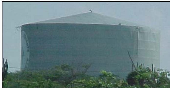
Figura 3: Tanque cilíndrico con techo cónico, Aruba.
