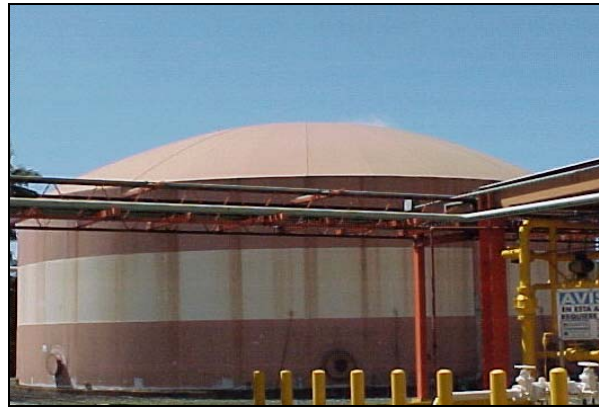
Figura 5: Tanque cilíndrico con techo en forma de domo rebajado. Planta Bacardí en Cataño, Puerto Rico.
