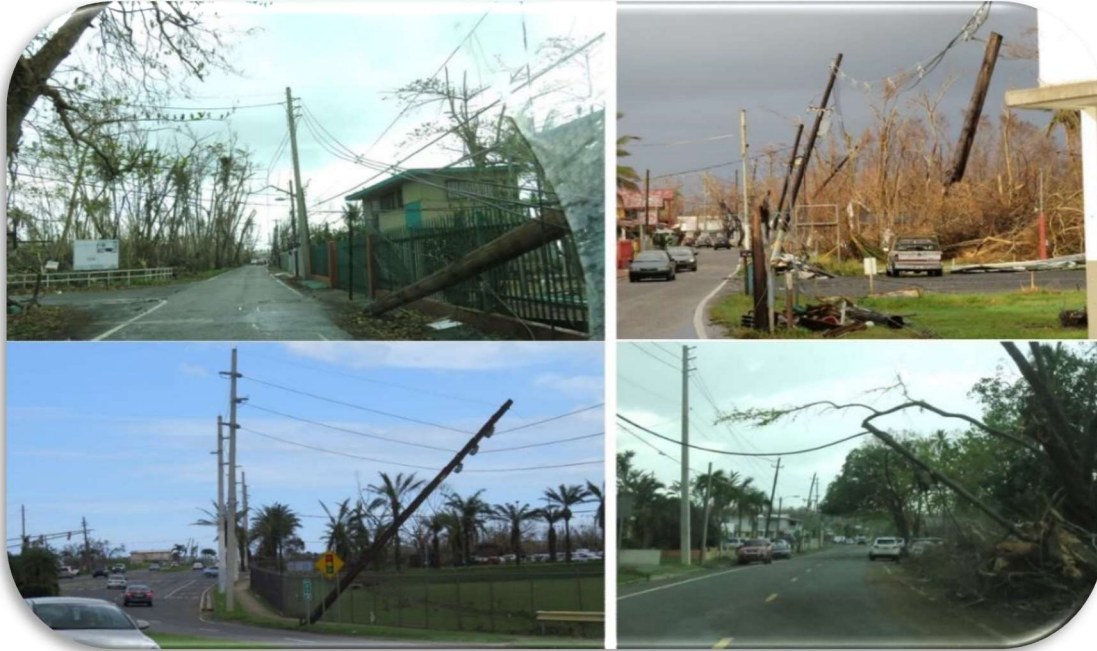
Figura 9: Fallas en postes de madera cercanos o en las mismas líneas que postes de hormigón que sobrevivieron el impacto del huracán.
