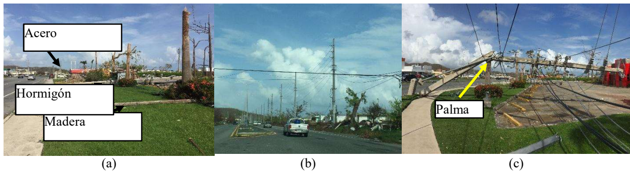
Figura 8: Ejemplos de fallas en región Este – (a) zona con mezclas de tipos de postes, madera, hormigón y acero, (b) postes de acero intactos, y (c) falla en suelo, con subsiguiente rotura al caer sobre palma.
