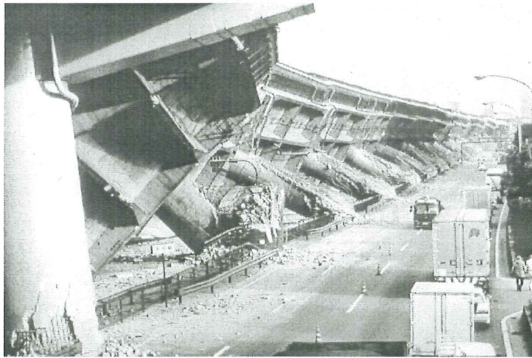
Figura 1.22. Colapso de una sección de 635 m de puente de pilas simples (Higashi-Nada Ward, Kobe), (Architectural Institute of Japan Society of Civil Engineers).
