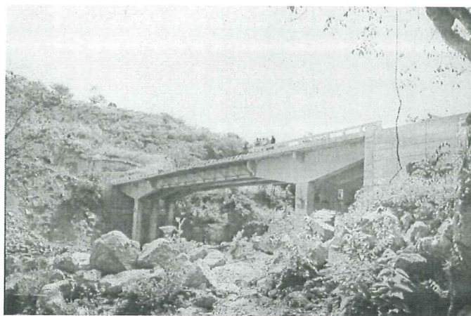
Figura 2.7. Puente en su etapa final de construcción.
