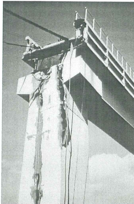
Figura 1.26. Una pila del puente Rokko, (Architectural Institute of Japan Society of Civil Engineers).
