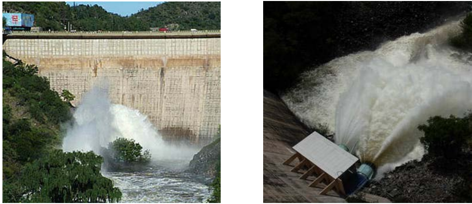
Figura 3: Vista de la descarga y de las válvulas de descarga de la toma de riego.
