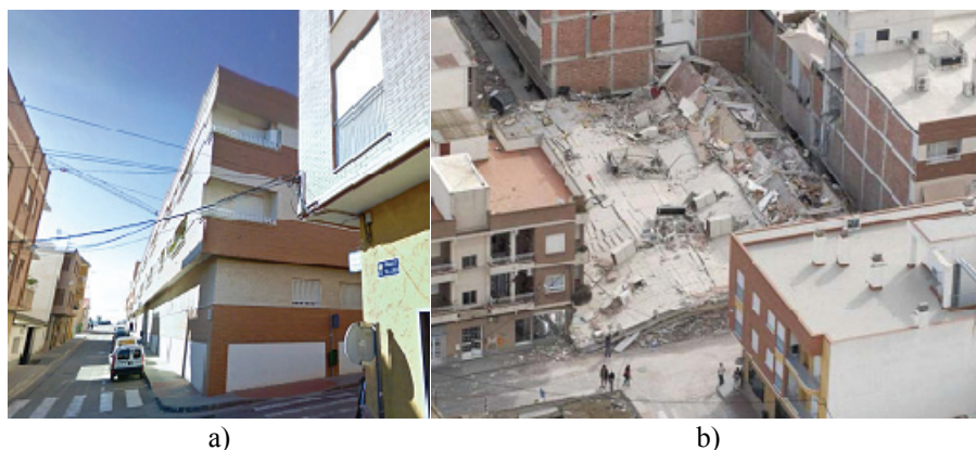
Fig. 5. Único edificio de hormigón armado que colapsó durante el terremoto: (a) edificio antes del terremoto disponible en el Google Street View y (b) vista tras el terremoto de Lorca (La Verdad, 2011c)
