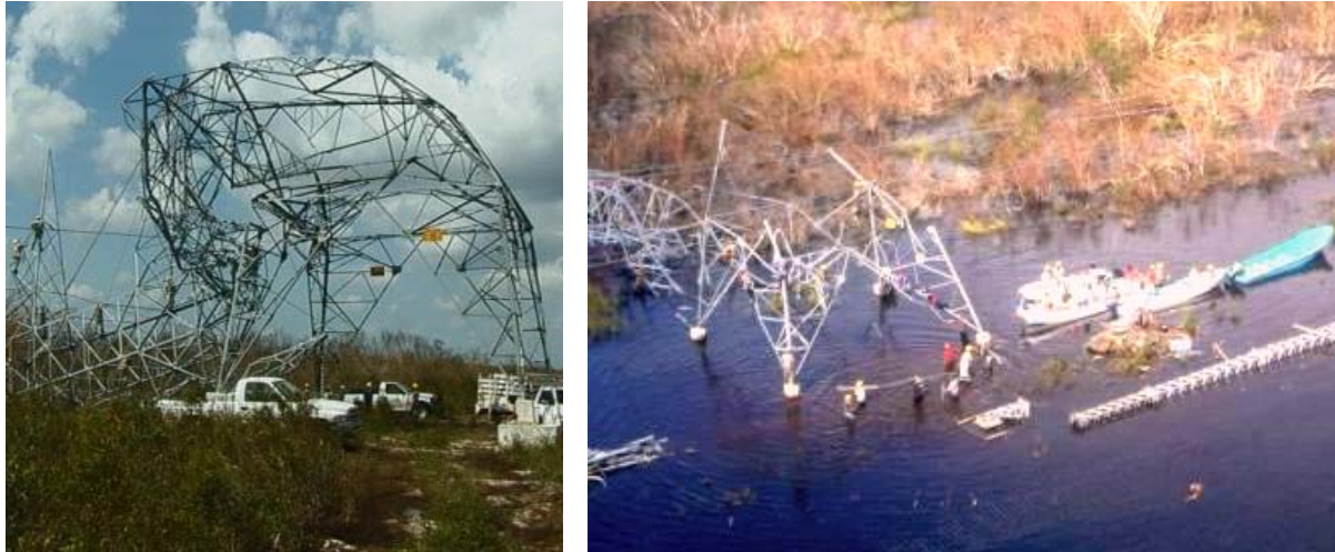
Figura 1: Daño en torres de alta tensión ocasionados por el huracán Wilma en la península de Yucatán, México.
