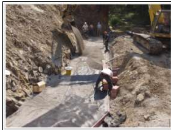
Figura 12: Proceso de construcción estribo tipo GRS-IBS.
