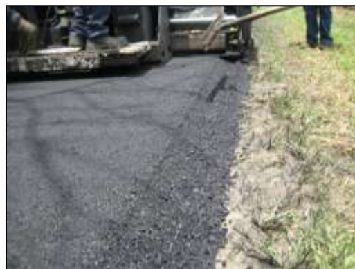
Figura 7: Construcción del Borde de Seguridad en PR-182, Yabucoa.
