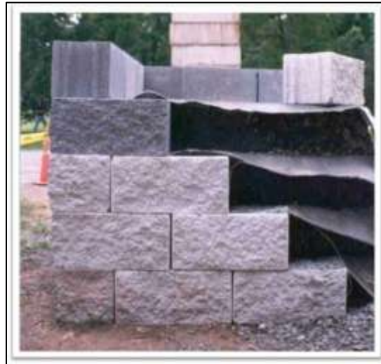
Figura 11: Sección transversal típica de muros GRS.
