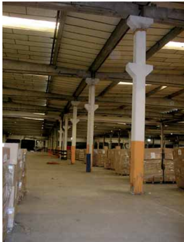
Fotografía 1.7 Estructura porticada de elementos prefabricados.
