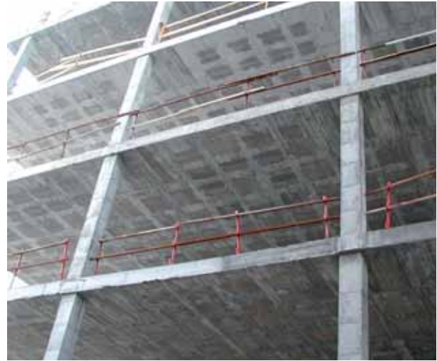
Fotografía 1.9 Vista de un edificio con pilares y forjados reticulares.
