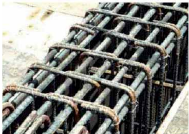
Fotografía 3.5 Armado típico de una viga.
