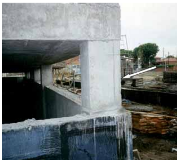
Fotografía 2.3 Pilares cortos en un edificio.
