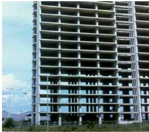
Fotografía 1.3 Vista de un edificio con pantallas a cortante orientadas en una sola dirección.
