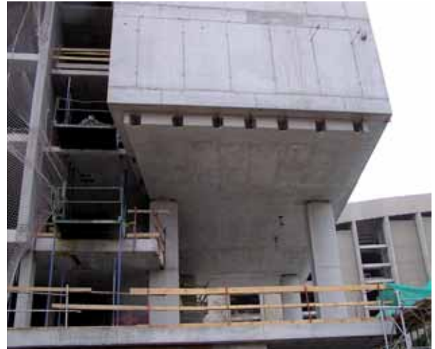
Fotografía 2.11 Estructura singular, forjado postensado sobre juntas de neopreno.
