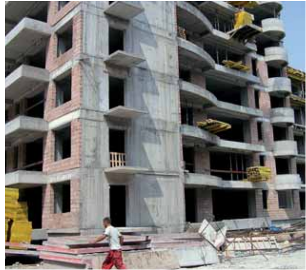
Fotografía 1.5 Vista de un edificio con pantallas a cortante formando núcleo; nótese que la ubicación de éste genera excentricidad en planta.
