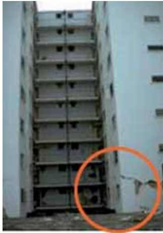
Fotografía 1.16 Daños en un muro de cortante en el ala de edificio con planta en forma de H, terremoto de Caracas, Venezuela, 1967.
