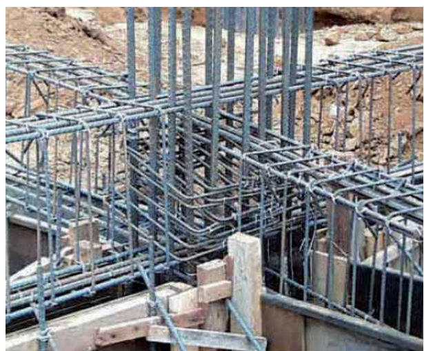
Fotografía 3.6 Concentración de armaduras en la zona de un nudo pilar-viga.
