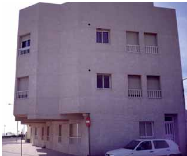
Fotografía 2.1 Irregularidad en planta: crecimiento de las plantas con la altura.
