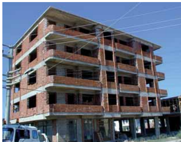
Fotografía 2.8 Planta baja libre en edificio.
