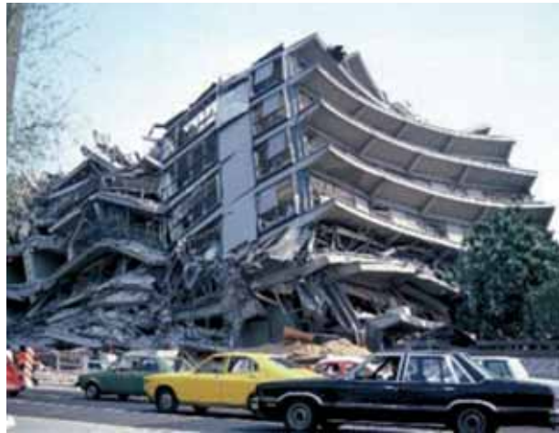
Fotografía 1.14 Colapso de un edificio de hormigón armado en la ciudad de México, durante el terremoto de 1985.
