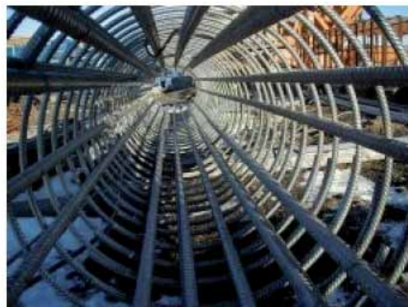
Fotografía 3.3 Refuerzo de un pilar de sección transversal circular con cerco de forma helicoidal.
