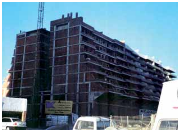
Fotografía 2.2 Variación de la masa de las plantas y discontinuidad en líneas resistentes verticales.
