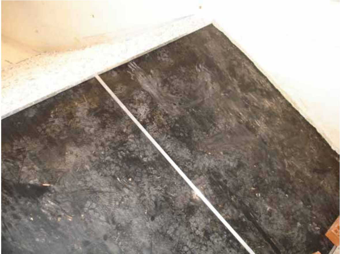
Foto 12. Pantalla impermeable de aguas arriba
