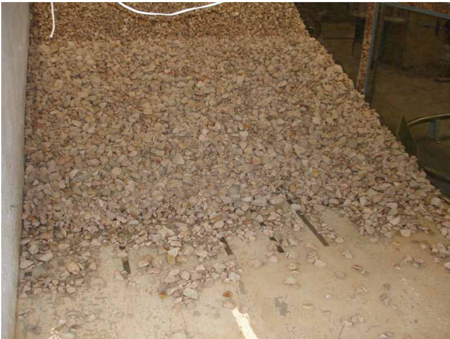
Foto 37. Caso H_b^* = 0,6 ; N_b = 3,0 . q_s = 37,65 l/s/m. Estado final de la protección
