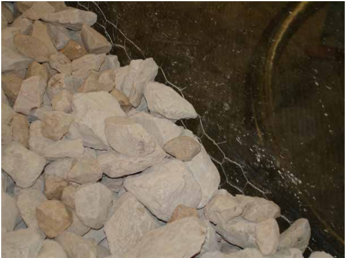
Foto 11. Detalle de la malla metálica instalada junto al cristal del canal.
