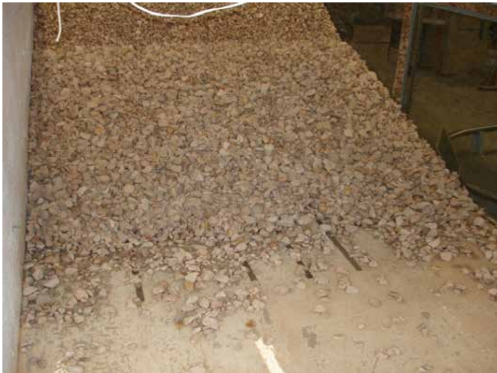
Foto 14. Ejemplo de daño de nivel 1. Caso H_b^*=0,6 ; Nb=3,0
