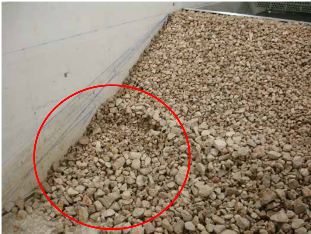
Foto 16 Ejemplo de daño de nivel 3. Caso H_b^*=0,4 ; Nb=1,5
