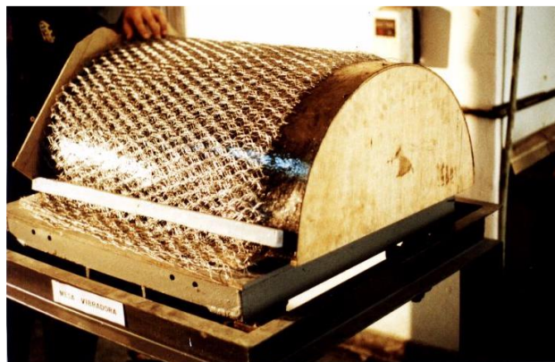
Fotografía 9. Refuerzo sobre formaleta en madera para tanque cilíndrico [Bedoya 96]
