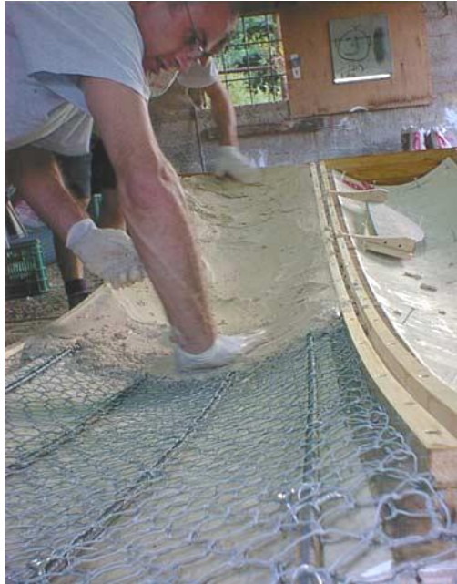
Fotografía 10. Colocación manual del mortero.
