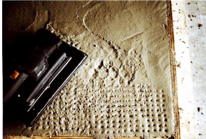
Fotografía 11. Vibración mecánica del mortero. [Bedoya 96].
