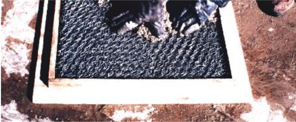
Fotografía 3. Refuerzo tipo malla hexagonal [Bedoya 96].
