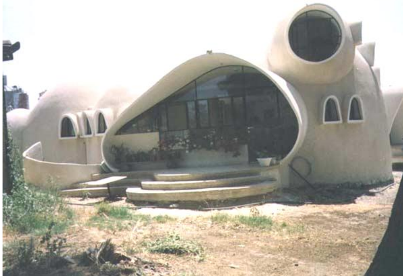
Foto 7. Vivienda poco convencional construida en ferrocemento.
