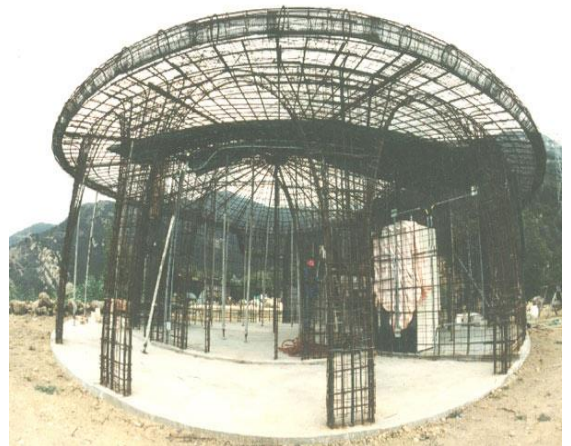
Fotografía 4. Acero de armazón para una estructura de ferrocemento.
