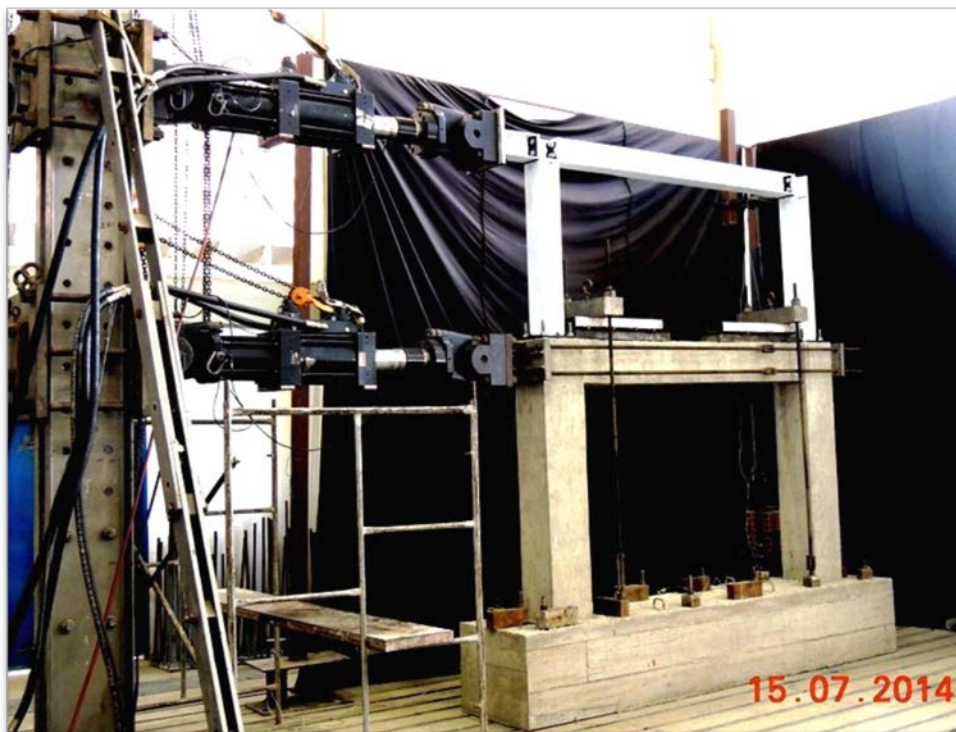
Figura 4.3. Vista de los actuadores aplicados al baricentro de las vigas de acero (nivel superior y hormigón armado (nivel inferior).
