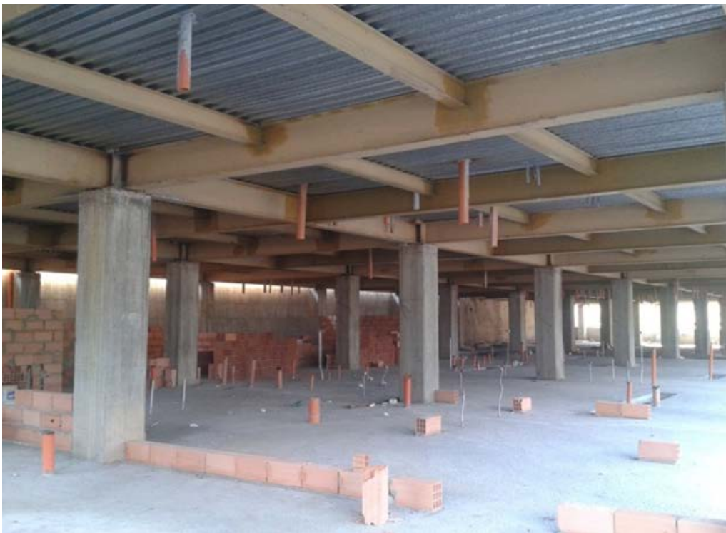
Figura 2.11. Vista interna de columnas de hormigón armado, vigas y losas de acero.
