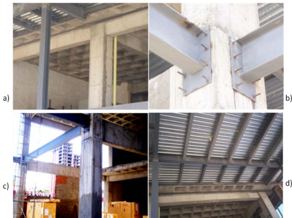
Figura 2.8. a) Unión de losas de acero y hormigón; b) Unión viga-columna; c) vista de vigas y columnas de acero y hormigón; d) Vista general de losas, vigas y correas.
