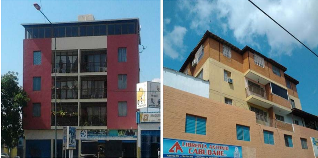
Figura 2.12. Vista general de edificaciones con pisos añadidos de acero estructural.
