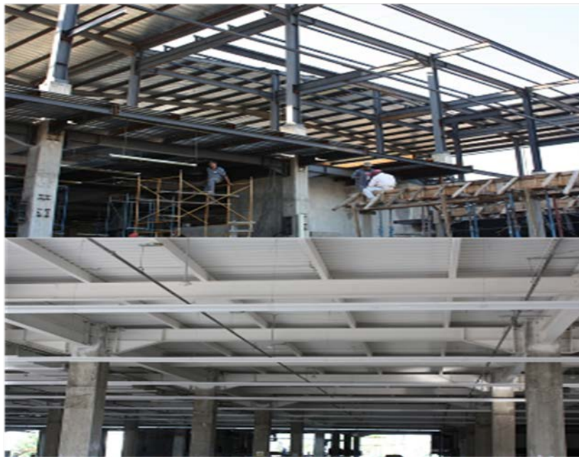
Figura 2.7. Vista general de estructura mixta con columnas de hormigón armado y de acero
