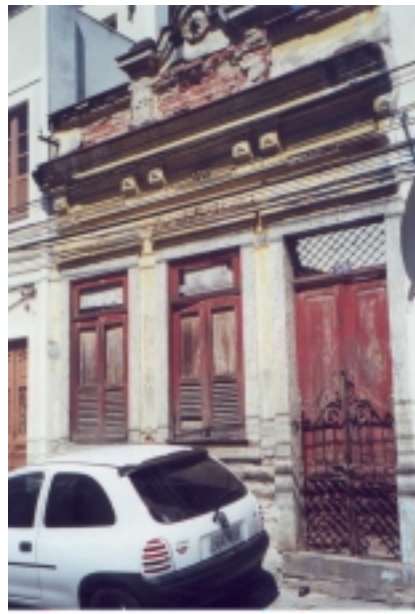
Foto 10: Morro da Conceição, Rio de Janeiro. Outra fachada remanescente, 2001.
