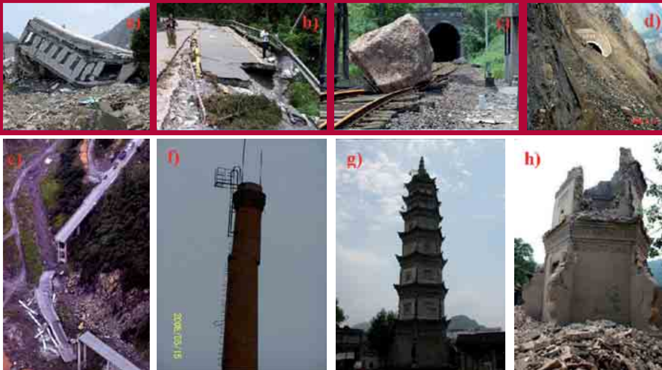
Figura 13.5. Ejemplos de daños causados por el terremoto de Wenchuan: a) edificio de 9 pisos colapsado; b) calzada destruida por colapso del talud; c) vía férrea interrumpida por la caída de una enorme roca; d) boca de túnel taponada por un deslizamiento; e) colapso de puente de carretera; f) chimenea de ladrillo rota e inclinada; pagoda típica antes (g) y después (h) del terremoto.
