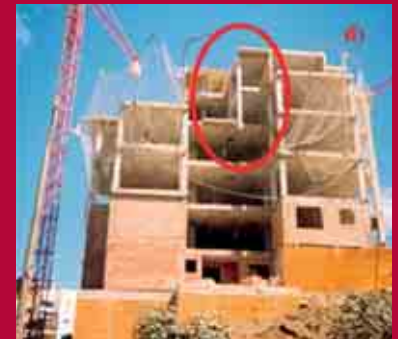
Figura 13.6. Algunos de los aspectos constructivos desaconsejados que hay que evitar: a) Irregularidad en planta; crecimiento de la superficie de las plantas con la altura; b) pilares cortos en todos los pisos de un edificio; c) juntas pilar-forjado con comportamiento de corte directo; d) discontinuidad de pilar en las plantas inferiores del edificio; e) falta de arriostramiento del pilar a nivel del forjado.
