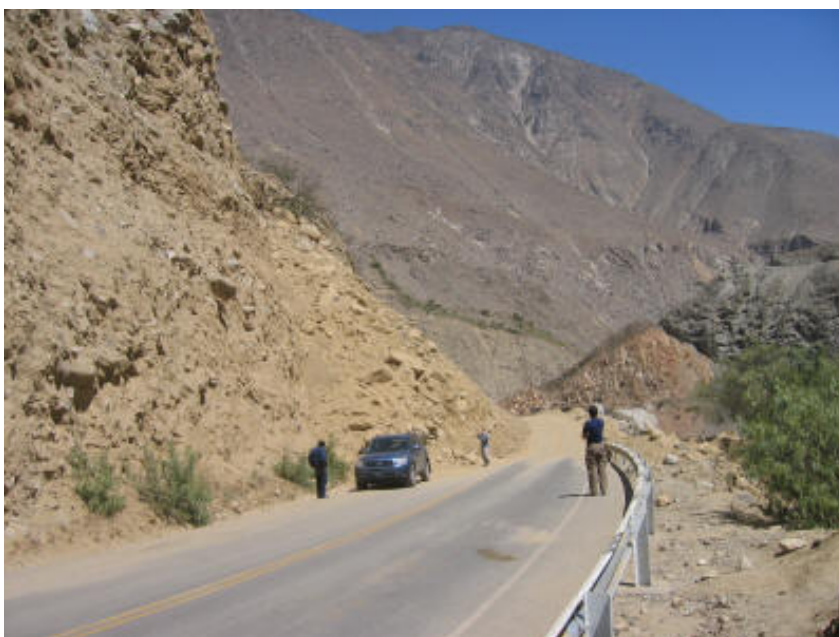
Figura 27: Deslizamiento de suelo y roca en la carretera 024A.
