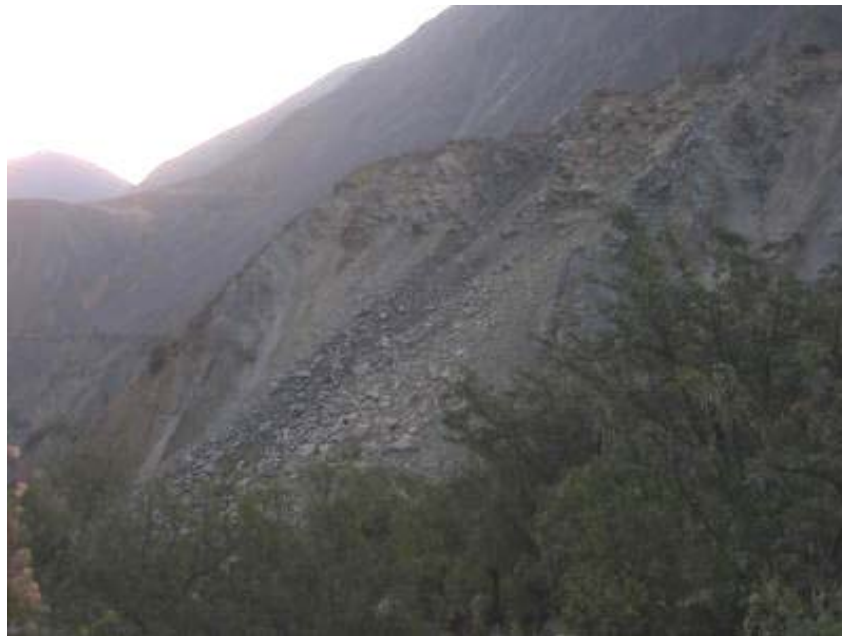
Figura 26: Deslizamiento de rocas en talud natural.
