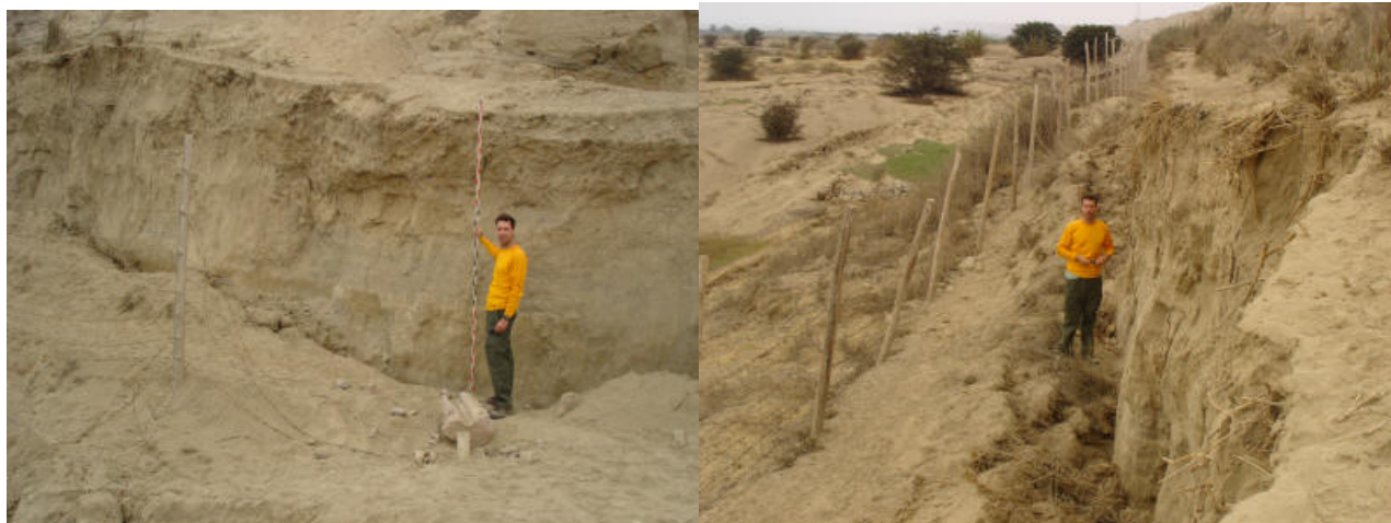
Figura 18: Desplazamiento vertical producto del desplazamiento lateral del terreno en Canchamaná.
