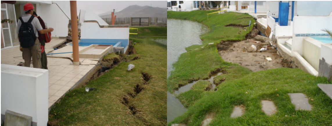
Figura 21: Desplazamientos laterales y fallas asociadas a licuación en el complejo Las Lagunas.
