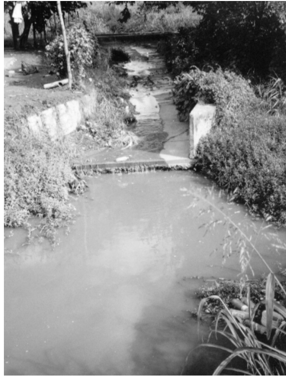
Figura 17: Situación típica de descarga de canales de escurrimiento superficial sobre el canal de riego.
