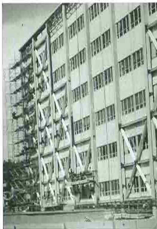
FOTOGRAFIA 11. REFUERZO CON DIAGONALES
