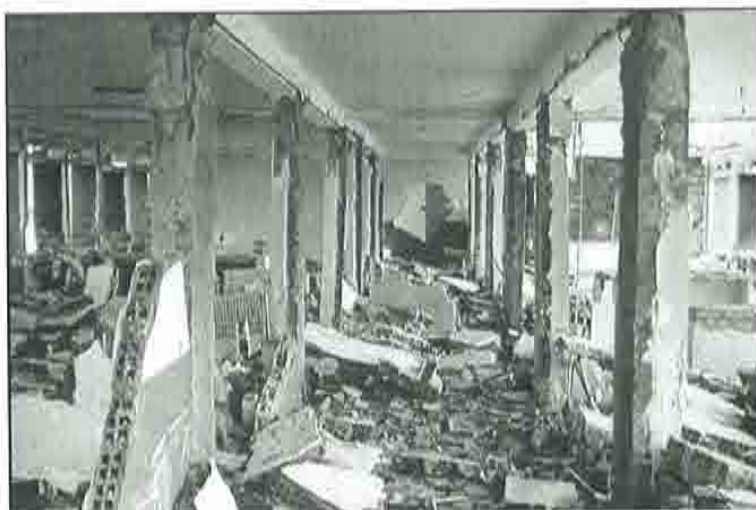
FOTOGRAFIA 19. MUROS DESTRUIDOS POR FLEXIBILIDAD DE LA ESTRUCTURA
