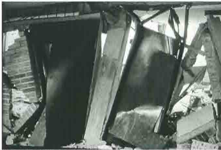
FOTOGRAFIA 4. FALLA DE COLUMNAS POR FALTA DE SISMORRESISTENCIA
