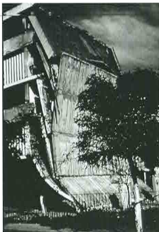
FOTOGRAFIA 9. FALLA POR ALTA CONCENTRACION DE ENERGIA (J. GRASES)
