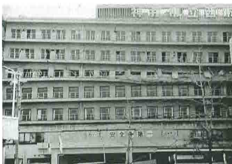
FOTOGRAFIA 3. COLAPSO DEL QUINTO PISO, HOSPITAL MUNICIPAL DE KOBE 1995
