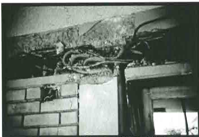
FOTOGRAFIA 15. EFECTO DE COLUMNA CORTA
