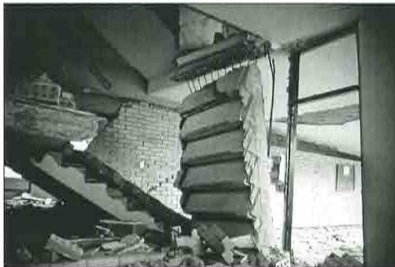
FOTOGRAFIA 5. COLAPSO DE ESCALERA POR FALTA DE SISMORRESISTENCIA
