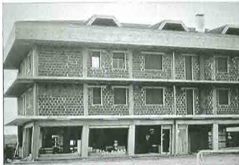
FOTOGRAFIA 7. FALLA EN PRIMER PISO POR PISO DEBIL
