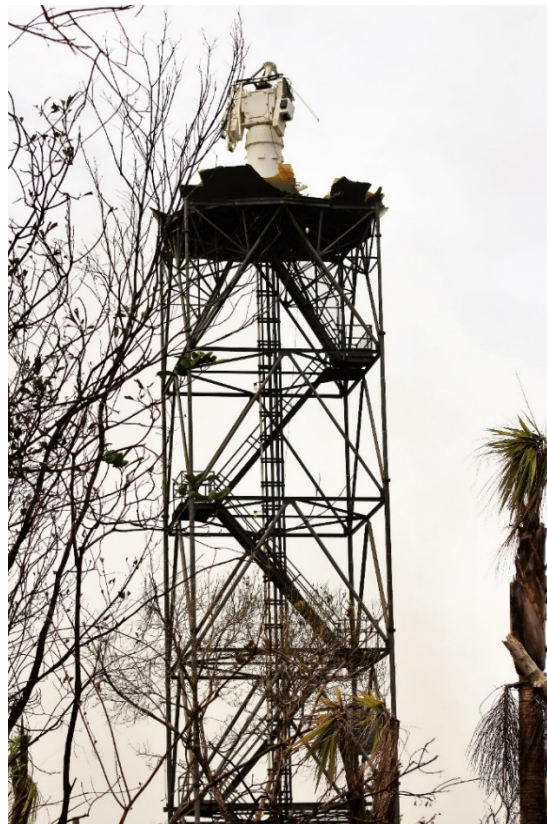
Figura 1: Radar del Servicio Meteorológico Nacional en Puerto Rico después del paso del huracán María.
