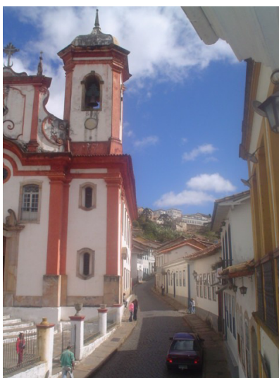
Foto 6: A grande proximidade entre a Igreja Matriz de N. S. da Conceição e as edificações da praça Antônio Dias e da rua Bernardo de Vasconcelos.
