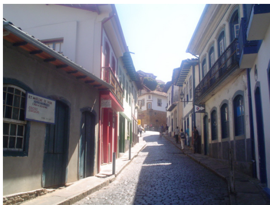
Foto 2: Rua Bernardo Vasconcelos.
