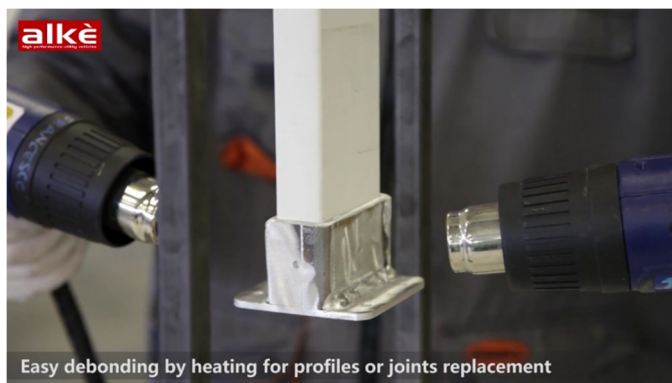
Figura 10. Operación de despegue mediante aplicación de calor
