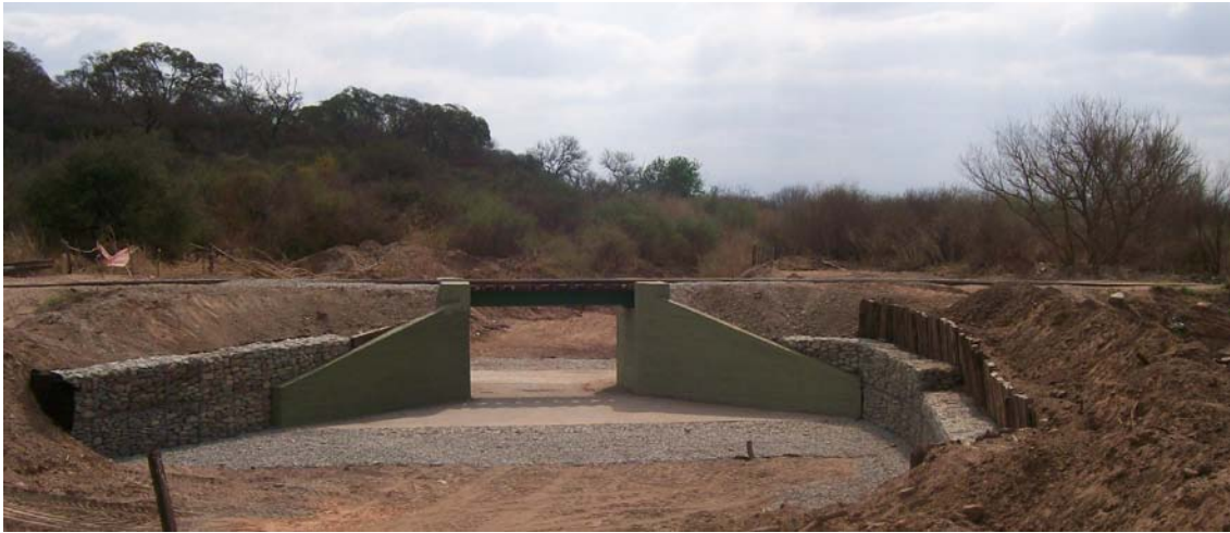
Figura 4: Fotografía de la alcantarilla en estudio tomada al concluir su construcción. Vista desde aguas abajo.
