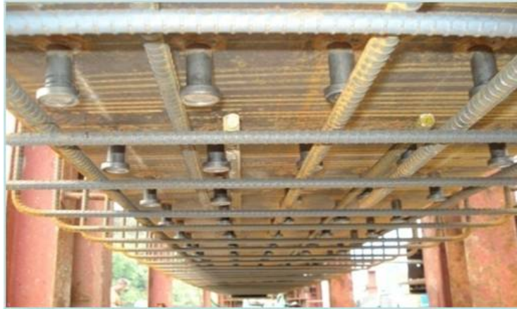
Figura 3: Pernos de cortante colocados en la aleta inferior de la viga de acero.
