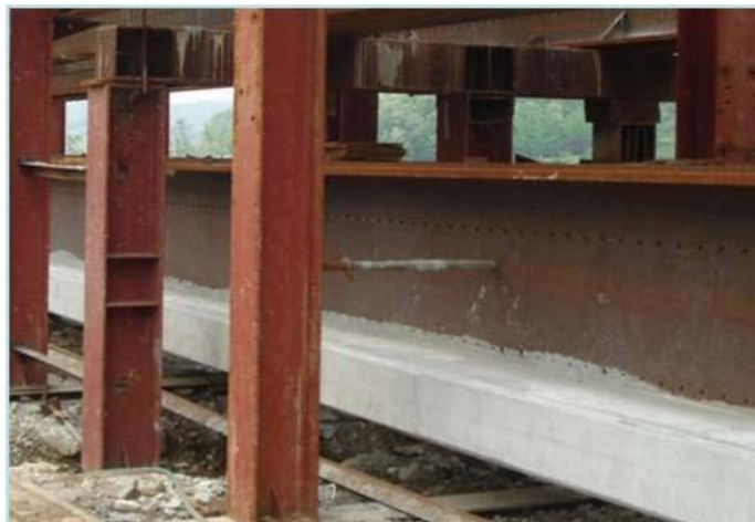
Figura 2: Viga pre-flexionada construida en sitio.
