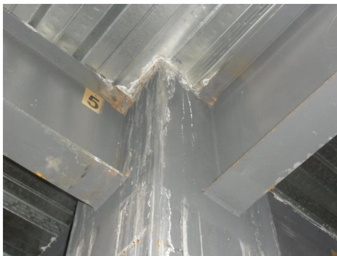
Figura 1.18 Unión viga-columna Hospital Axxis
