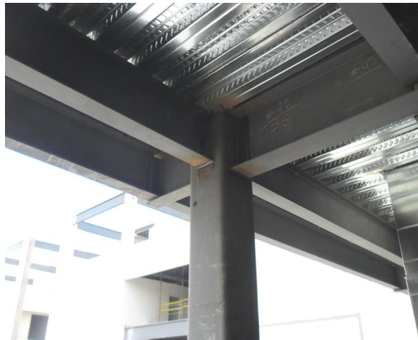
Figura 1.23 Columna Tipo bloque A del Hospital Docente de Calderón
