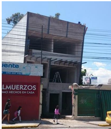
Figura 1.10 Fachada Frontal Almacenes Chimborazo
