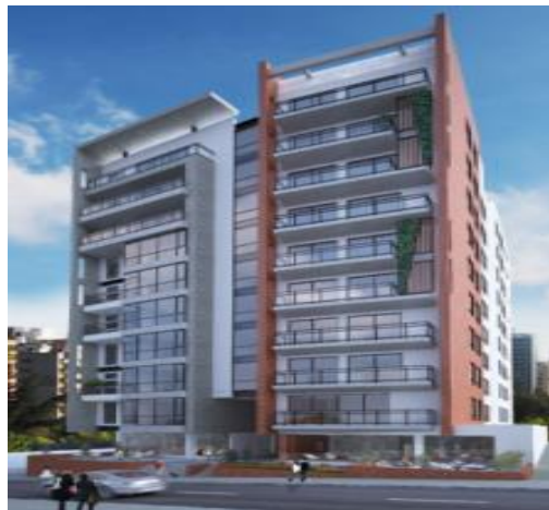
Figura 1.3 Fachada Frontal Edificio Bezier
