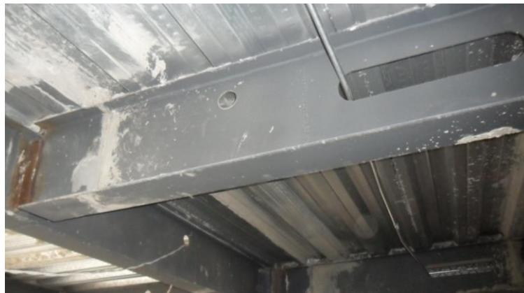
Figura 1.67 Viga Principal Tipo I del edificio Oleas
