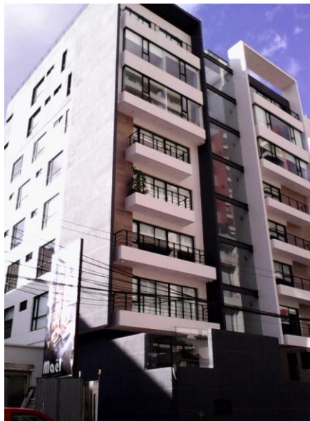
Figura 1.71 Fachada Frontal Edificio Mael
