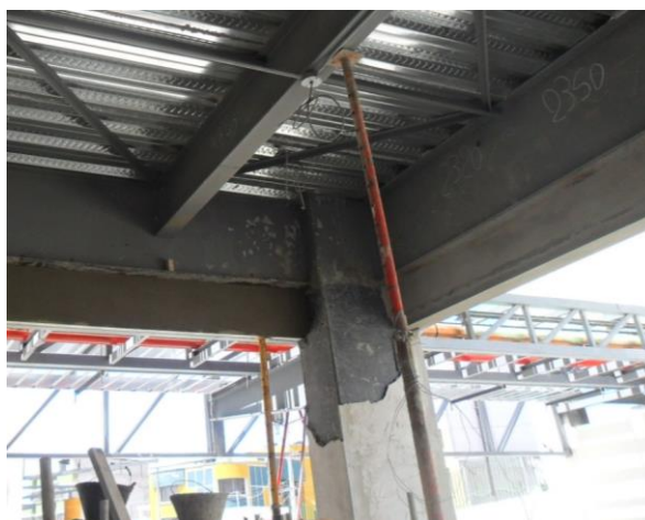
Figura 1.31 Columna Tipo bloque C del Hospital Docente de Calderón
