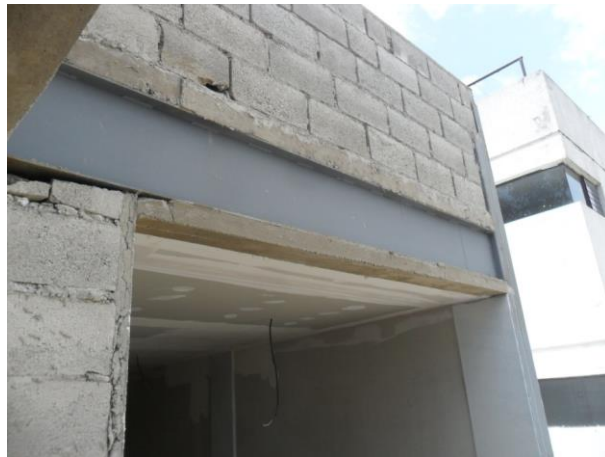
Figura 1.11 Viga Principal Tipo I de Almacenes Chimborazo
