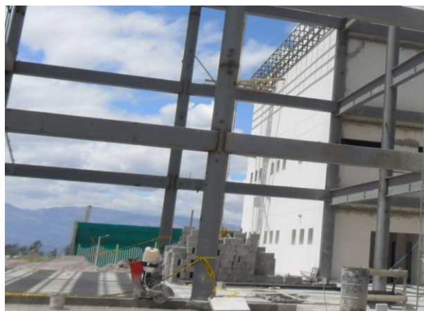
Figura 1.27 Columna Tipo bloque B del Hospital Docente de Calderón
