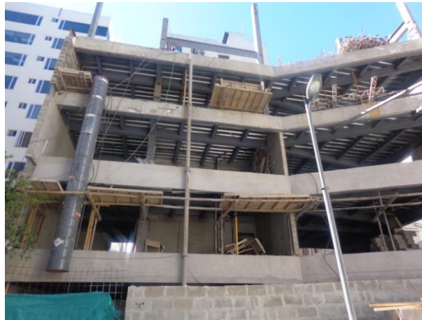
Figura 1.55 Fachada Frontal Edificio Bernini
