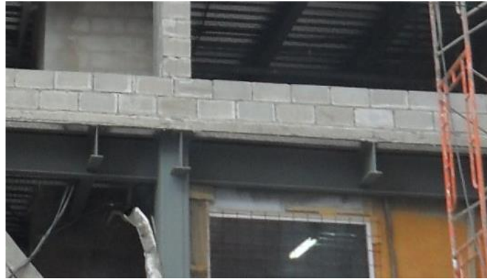
Figura 1.62 Viga Principal Tipo I del edificio Eifel
