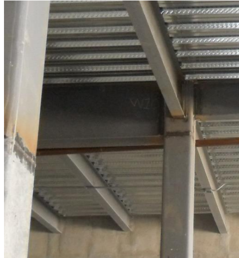
Figura 1.22 Viga Principal Tipo del bloque A del Hospital Docente de Calderón
