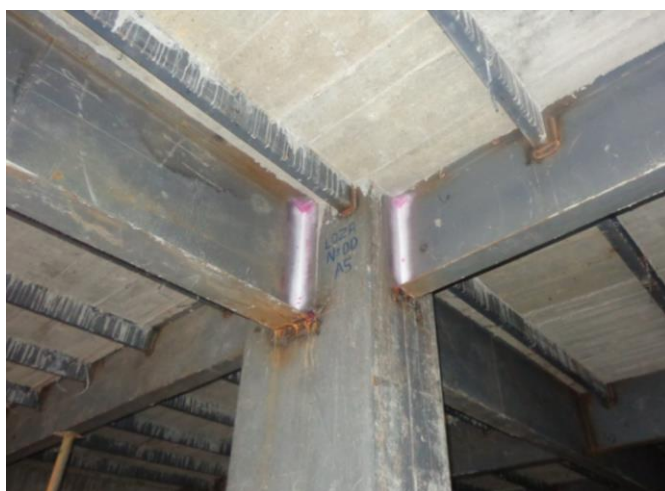
Figura 1.47 Unión viga-columna Jade
