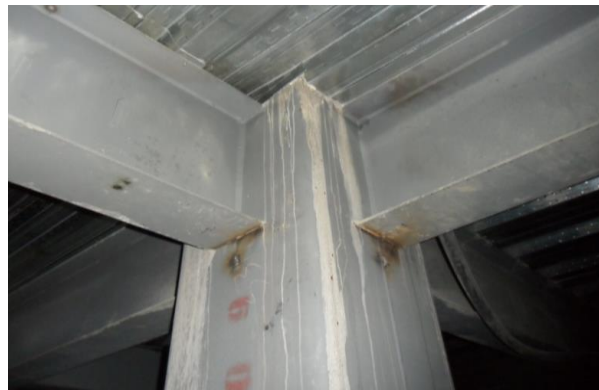
Figura 1.6 Unión viga-columna del edificio Bezier
