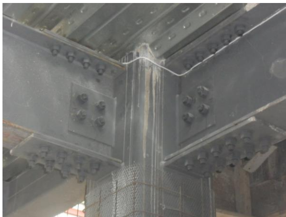
Figura 1.75 Unión viga-columna edificio Mael
