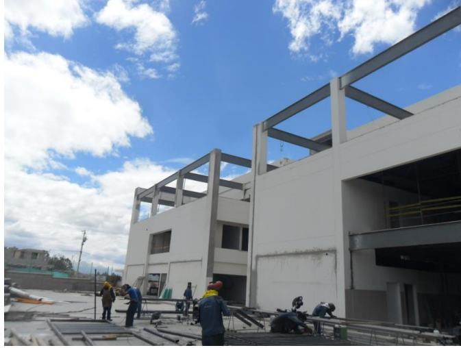
Figura 1.21 Bloque A Hospital Docente de Calderón
