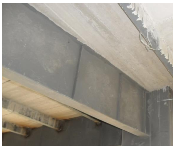
Figura 1.51 Viga Principal Tipo I del edificio Sauces Plaza
