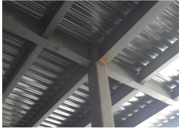
Figura 1.24 Unión viga-columna bloque A Hospital Docente de Calderón
