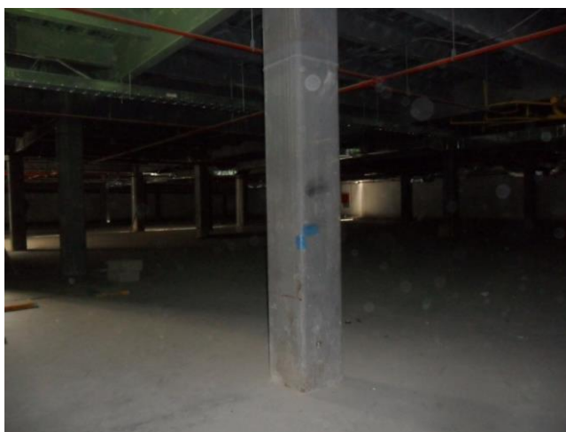
Figura 1.35 Columna Tipo bloque D del Hospital Docente de Calderón
