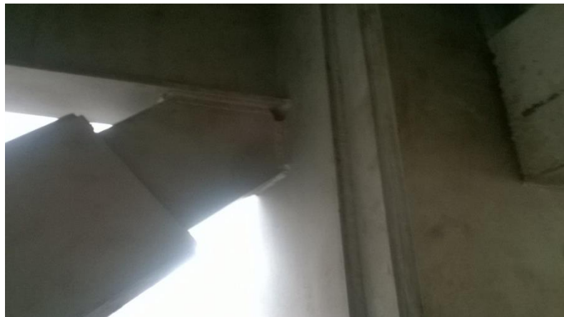
Figura 1.41 Unión viga-columna Torres del Castillo
