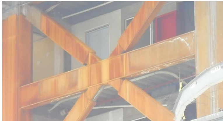
Figura 1.39 Viga Principal Tipo I de Torres del Castillo
