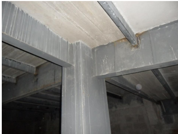
Figura 1.53 Unión viga-columna del edificio Sauces Plaza
