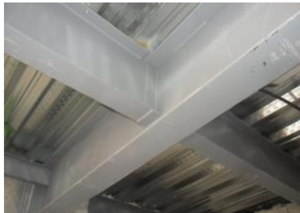
Figura 1.4 Viga Principal tipo I del Edificio Bezier
