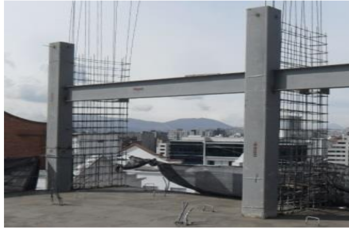
Figura 1.5 Columna Tipo del Edificio Bezier
