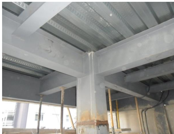
Figura 1.59 Unión viga-columna Bernini
