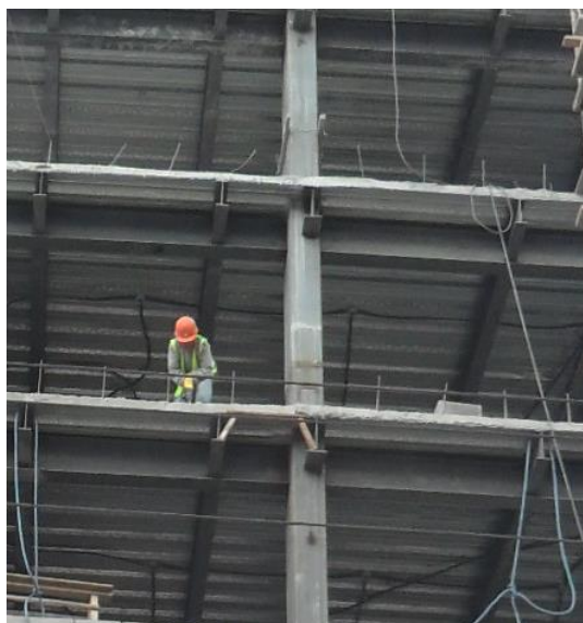
Figura 1.64 Unión viga-columna Eiffel
