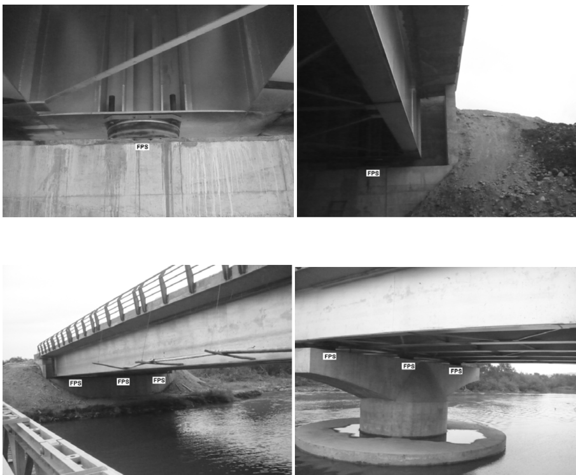
Figura 3: Estribo y apoyo con FPS, puente norte 1.
