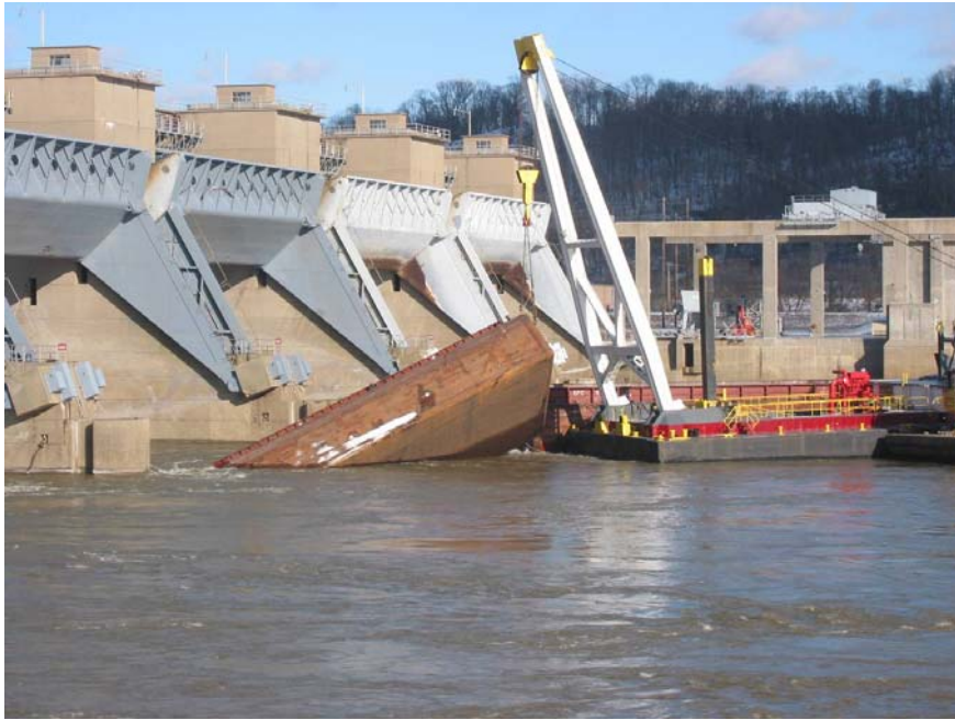
Figura 4: Impacto de barcaza en la presa y reclusa Belleville.
