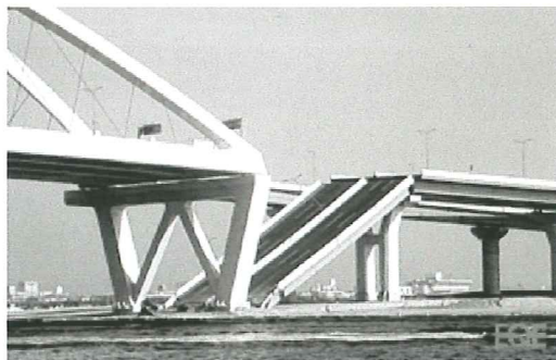
(a) Acceso al puente Nishinomiya
