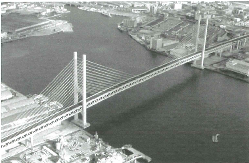
Figura 3.28 Puente atirantado Higashi Kobe con 485 metros de vano central y 885 m de longitud total (Toshihiro Miki, 1996)
