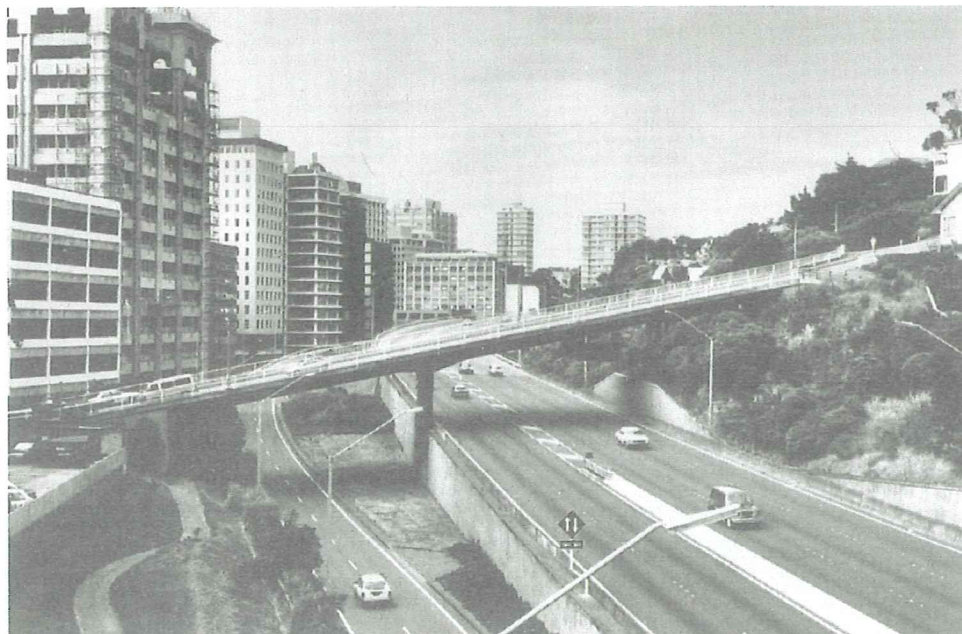
Figura 3.19 El puente Aurora Terrace, en Nueva Zelanda, cuenta con disipadores por extrusión de plomo colocados en el estribo inferior (Skinner, et al, 1993)
