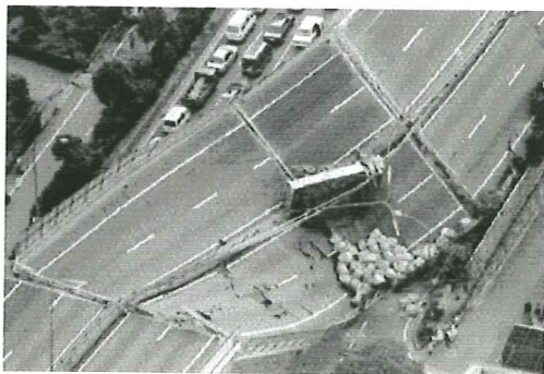
Figura 1.5 Daños en la vía rápida Hanshin (EQE, 1995)
