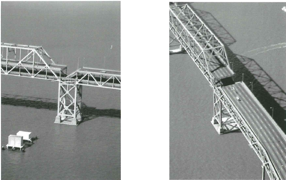
Figura 1.1 Derrumbe del vano superior de una sección del puente de la Bahía Oakland – San Francisco (Nakata et al, 1999)
