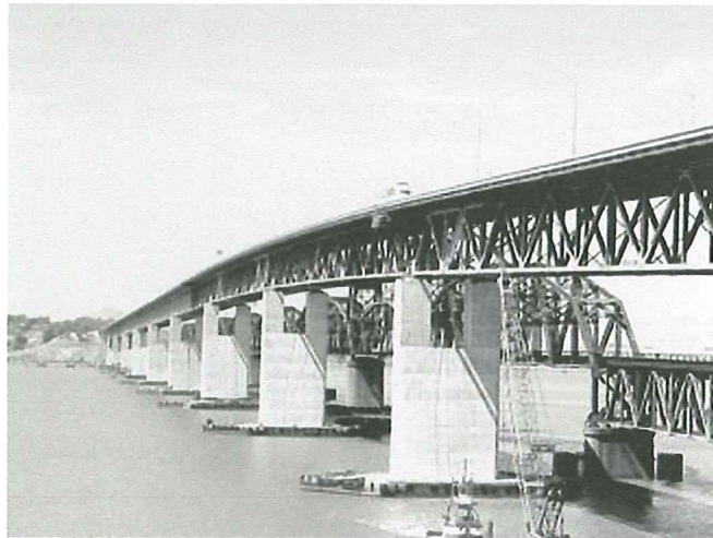
Figura 3.17 El puente Benicia – Martinez fue rehabilitado mediante péndulos con fricción (Earthquake Protection Systems Inc., 2000)
