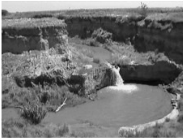
Figura 1: Vista de la Cárcava del Arroyo Las Lajas, tramo medio (2001). El salto inferior está retenido por un manto de tosca consolidada.
