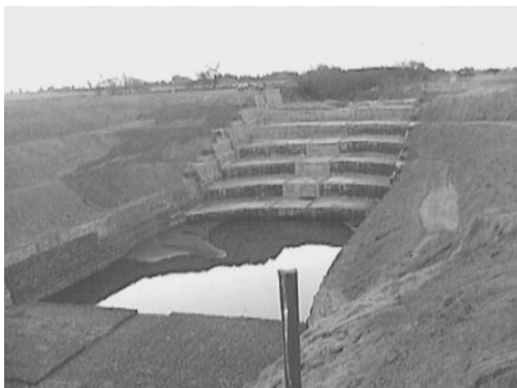
Figura 17: Obra concluida, junio de 2003. Cada salto vertical es de 2.3 m. En la margen derecha del cuenco de disipación se observa la sedimentación por aporte lateral.
