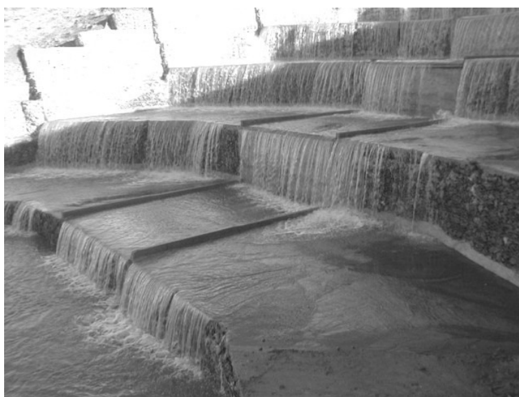
Figura 18: Obra en funcionamiento para caudales bajos.
