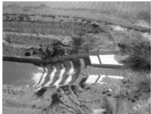
Figura 4: Vista del sistema de estabilización de la cárcava El Gato (2003). Notar la concentración de flujo en el centro para caudales intermedios.
