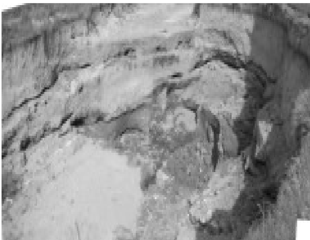
Figura 5. Vista de la cabecera Cárcava Corralito, de aproximadamente 12 m de altura (2005).
