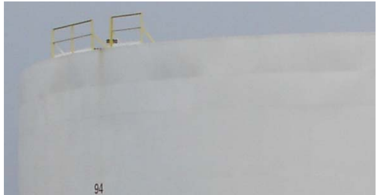
Figura 14: Citgo Pipeline Pecan Groves, West Lake, Louisiana. Nivel de daño DS2. (Fotografía del autor, octubre 10).
