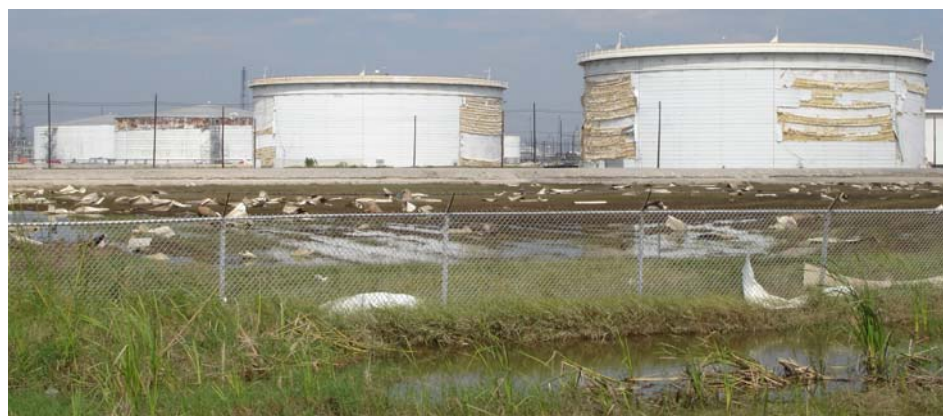
Figura 9: Planta Valero, Port Arthur, Texas. Cuatro tanques sufrieron daño que afectó la mayor parte de la zona cilíndrica expuesta al viento. Nivel de daño DS3. (Fotografía del autor, octubre 11).
