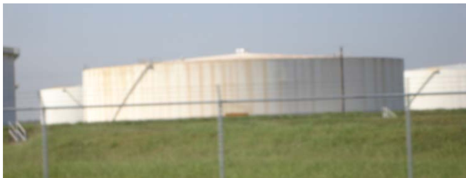
Figura 8: Planta BASF-FINA en Port Arthur, Texas. Daño en la aislación en la base del tanque. Nivel de daño DS2. (Fotografía del autor, octubre 12).
