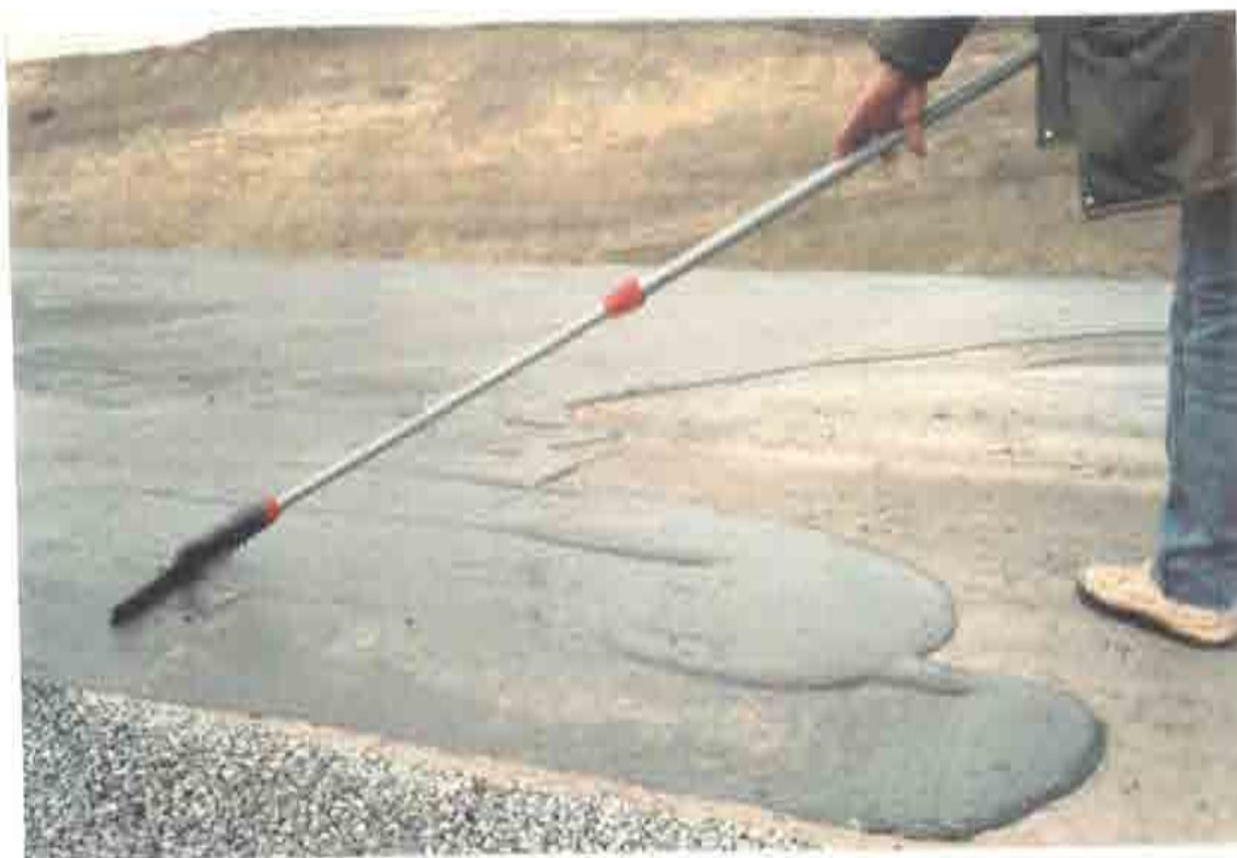
Figura 4.5.- Extendido de la capa de lechada.
