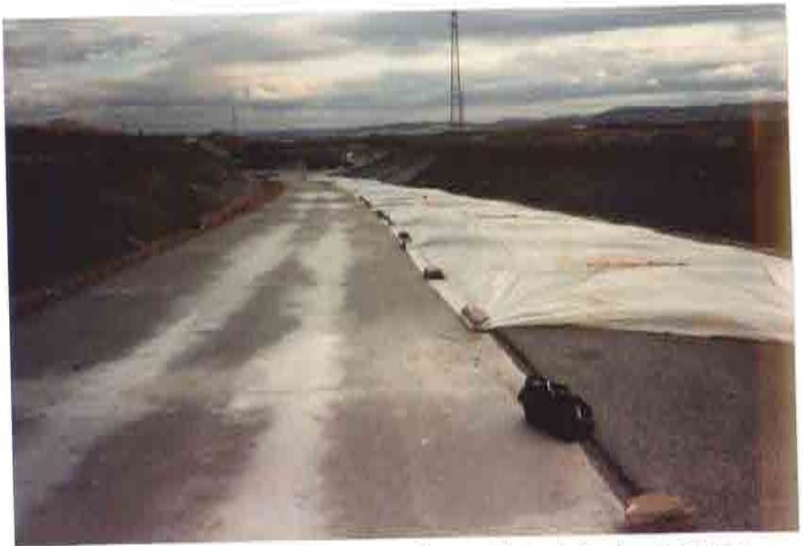
Figura 4.8.- Curado de la capa de rodadura mediante cubierta de lámina de plástico.
