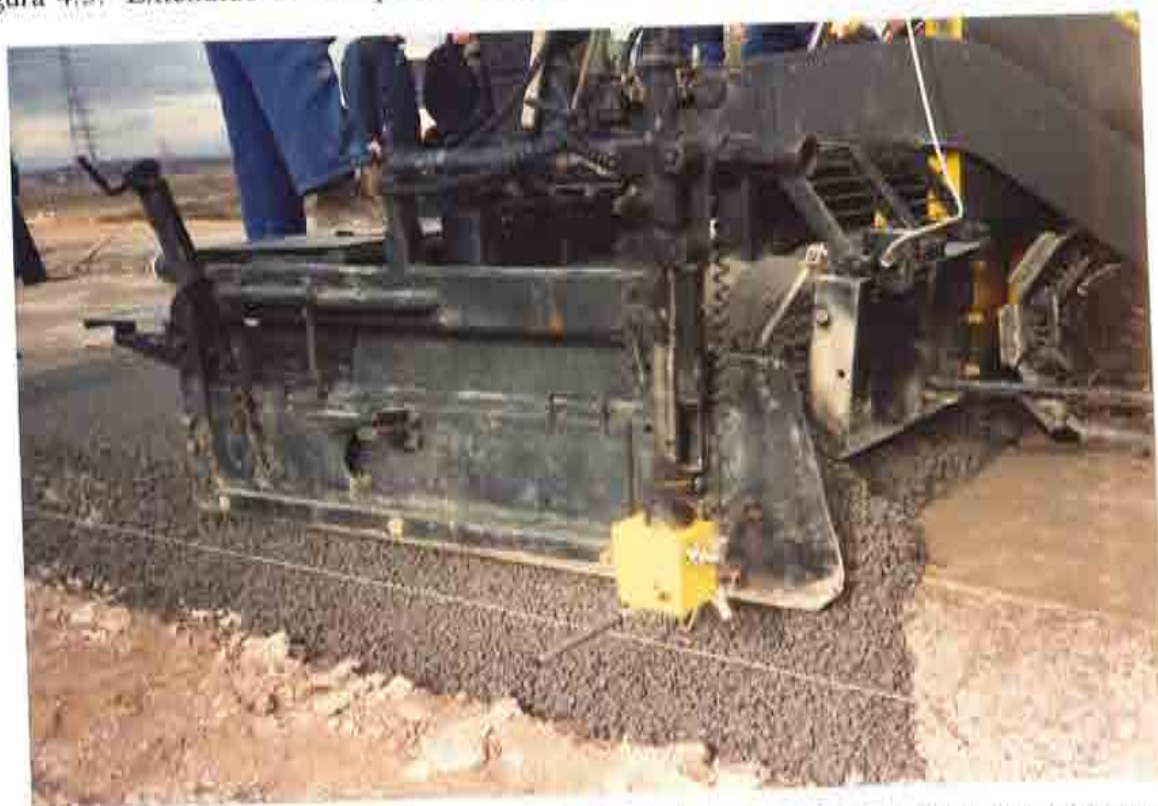
Figura 4.6.- Hormigón poroso sobre el sinfin de la extendedora y vista del palpador de nivelación.
