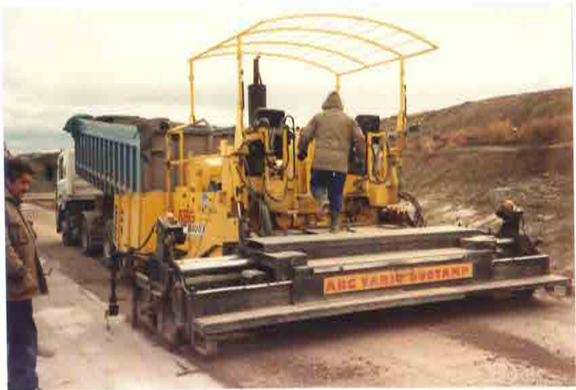
Figura 4.3.- Vista del extendido del hormigón compactado donde puede observarse parte de los equipos empleados.
