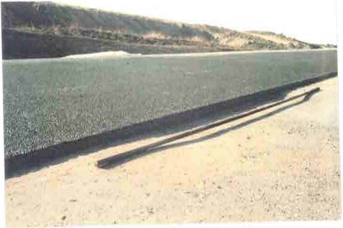
Figura 4.7.- Acabado de la capa de hormigón poroso. En esta foto puede apreciarse la textura, el espesor y la mejora de regularidad superficial.
