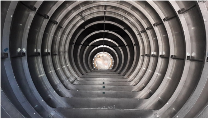
Figura 10. Larguerillos colocados en el interior de la estructura
