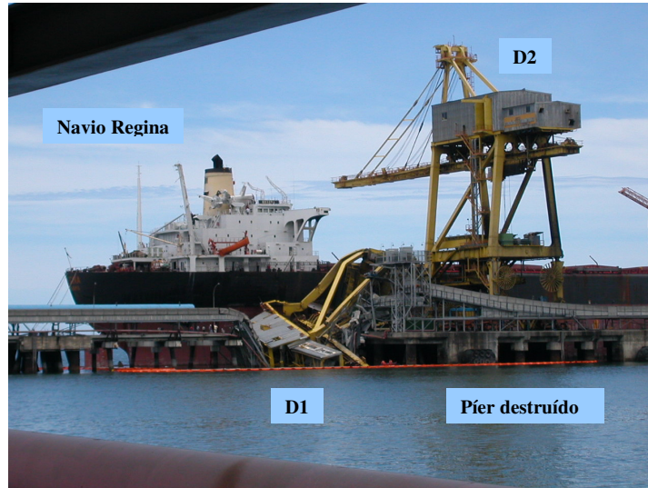
Figura 6: Descarregador D1 tombado no mar após destruir o deck de concreto do píer e provocar danos no navio Regina. O descarregador D2 permanece em pé, avariado pelo choque contra o D1.
