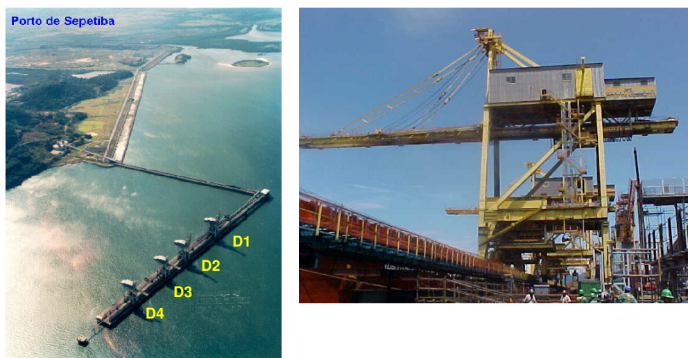
Figura 1: (a) Vista aérea dos descarregadores sobre o píer do Terminal de Carvão da CSN (b) vista lateral do descarregador D2, idêntico ao descarregador sinistrado.
