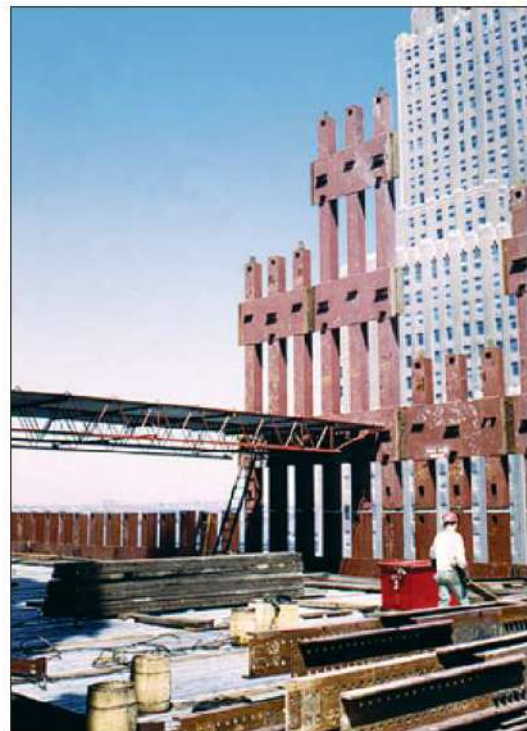
Figura 1.9: Costruzione del telaio tubolare esterno e della travatura di un solaio.
