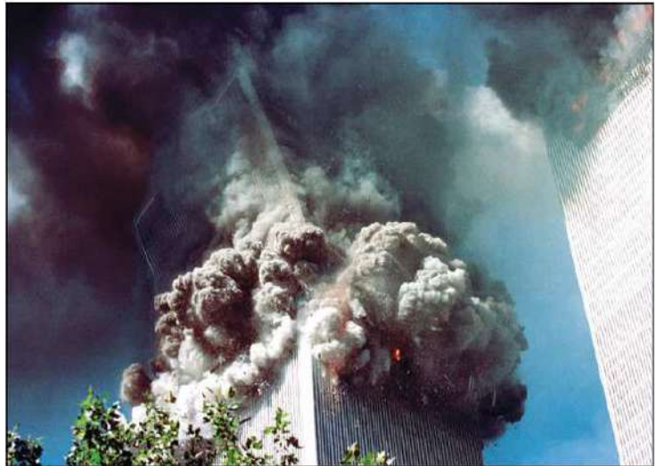
Figura 4.6: inclinazione della parte superiore della Torre Sud nei primi istanti di crollo.
