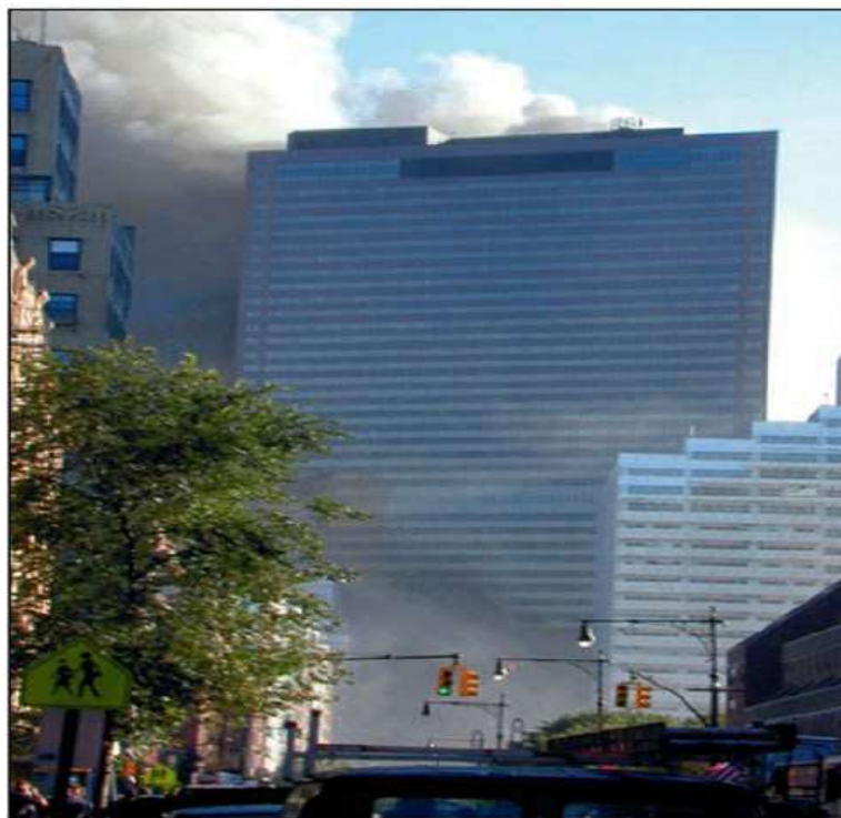
Figura 2.5: Veduta nord del WTC 7, con entrambi le installazioni di servizio (penthouse) poste sul tetto intatte.
