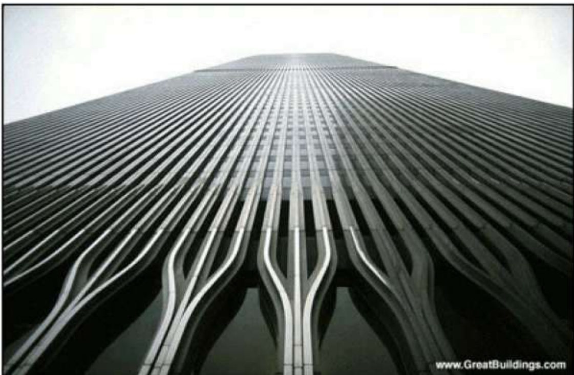
Figura 1.4: Particolare delle colonne di base delle torri.
