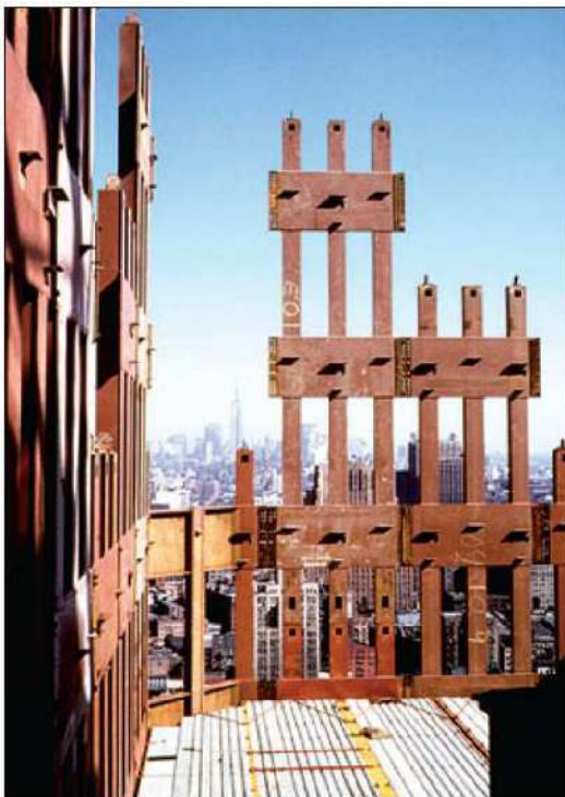
Figura 1.9: Costruzione del telaio tubolare esterno e della travatura di un solaio.
