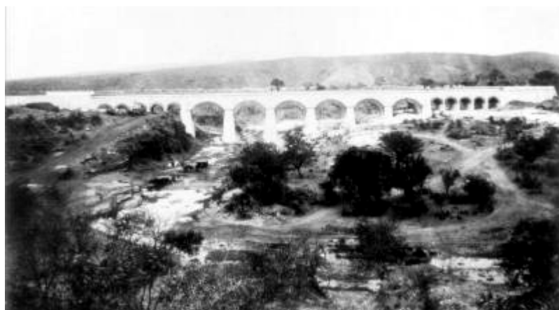
Figura 13: Acueducto del canal maestro en Saldán (Lusardi, 2002).
