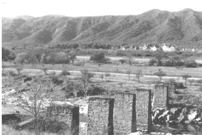
Figura 14: Pilares del puente sobre el río Cosquín en la provincia de Córdoba (Lusardi, 2002).
