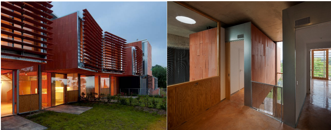
Ilustración 12 - Casas Pomaret, Vista exterior y interior donde se puede apreciar la simplicidad de los materiales de construcción
