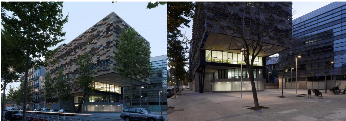
Ilustración 10 - Oficinas de Leitat, Vista desde la calle Pallars (izquierda), Vista desde la plaza interior (derecha)
