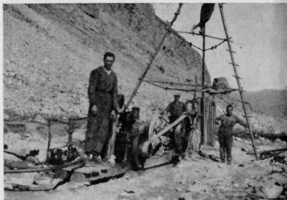
Fig. 1. - Sondaggi geognostici per una diga a 2 000 m s.l.m.
