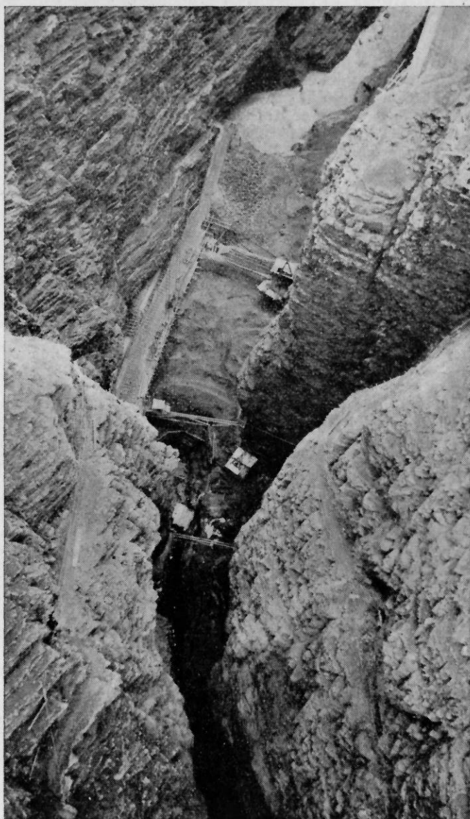
Fig. 19. — La forra del Sautet vista dall'alto; a monte il fiume Drac deviato; tura di presidio dello scavo di fondazione.
