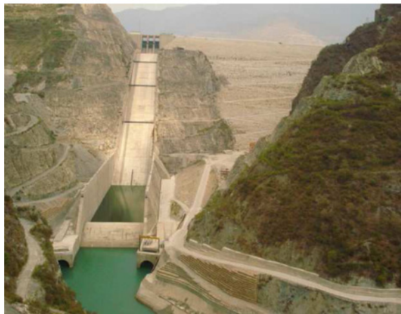
Figura 1.1 Presa se ubica en Tehri en el estado de Uttarakhand en la India y su altura sobre cimientos son 371m
