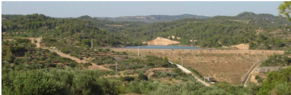
Figura 1.2 Presa de materiales sueltos con pantalla asfáltica de Palma d'Ebre, cuya altura sobre cimientos es 30,5m
