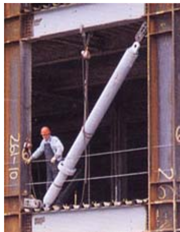
Figura 3: Edificio en construcción con amortiguadores.
