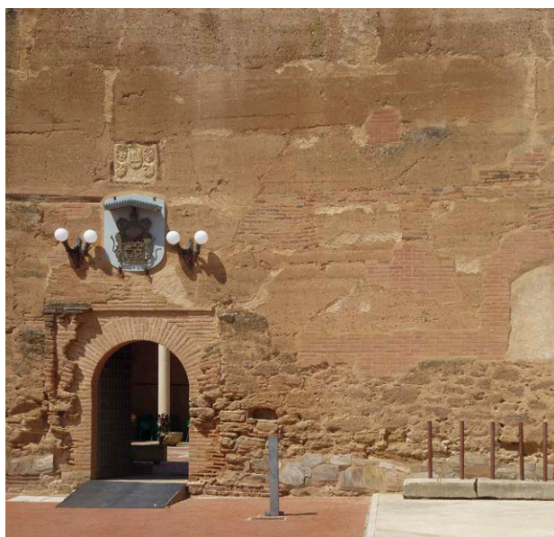
Fig. 6: Detalle del resarcido con fábrica de ladrillo perforado en las lagunas de la tapia y de la delicada reintegración del arco de entrada en el Palacio en el Toral de los Guzmanes (León)
