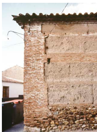
Fig. 14: Solución de esquina en ladrillo en una tapia de Valdeavero (Fondo ETSAM)
