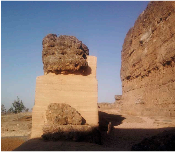
Fig. 5: Antemuro de la torre del castillo de Villanueva del Fresno, tras la intervención
