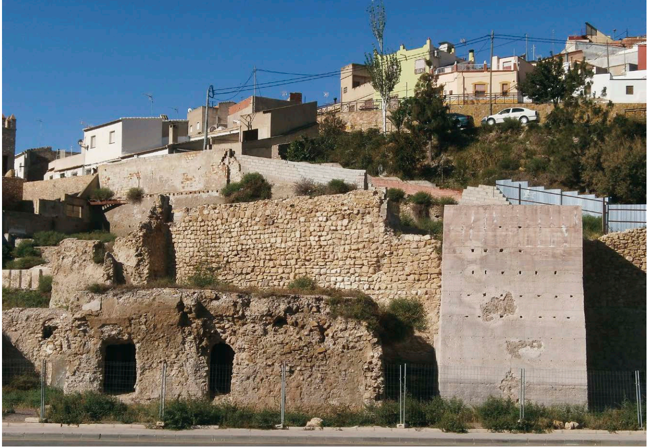
Fig. 7: Vista del tramo de muralla de la calle Rambla: cortina 9, torre 6
