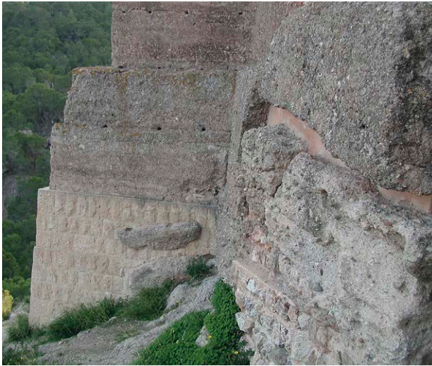
Fig. 9: Murcia. La Luz. Reposición, con sillarejo, de una base a la torre de tapia
