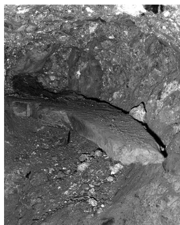
Fig. 4: Aguja de madera original situada en el interior del muro
