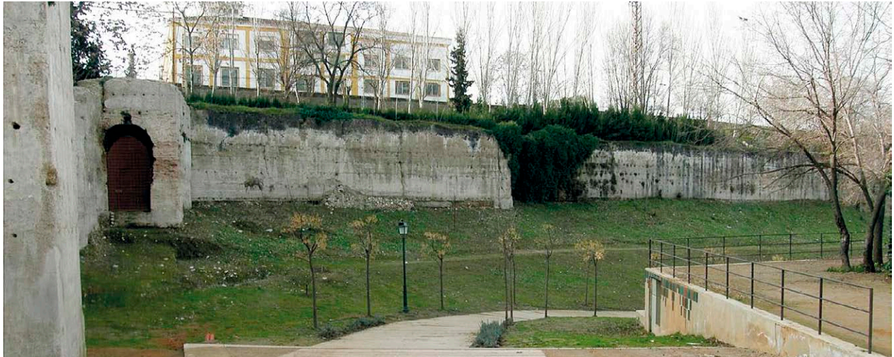
Fig. 1: Vista de un tramo de muralla posterior a la restauración
