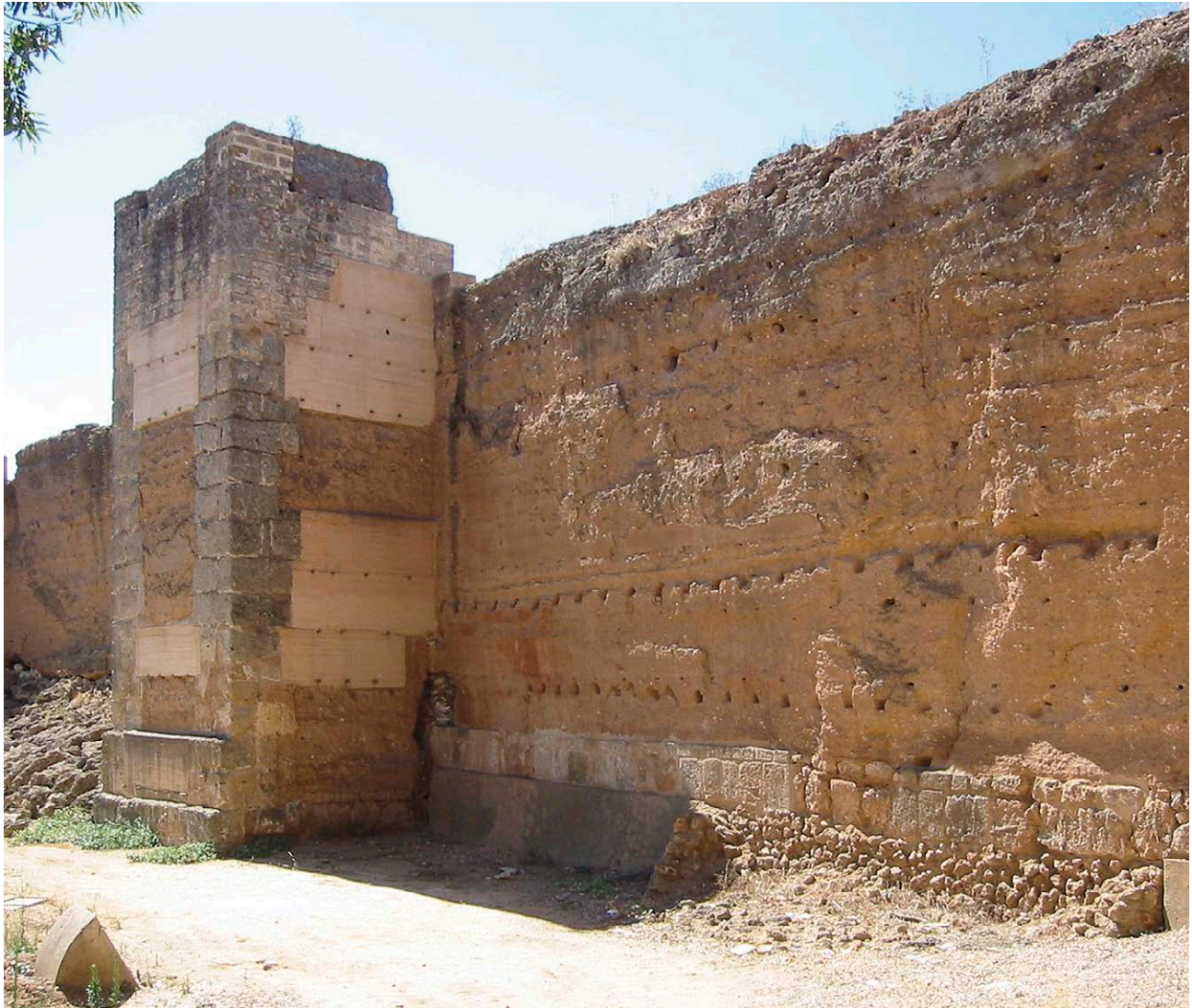
Fig. 8: Detalle de la torre 25 parcialmente restituida y de los lienzos conservados (2003)
