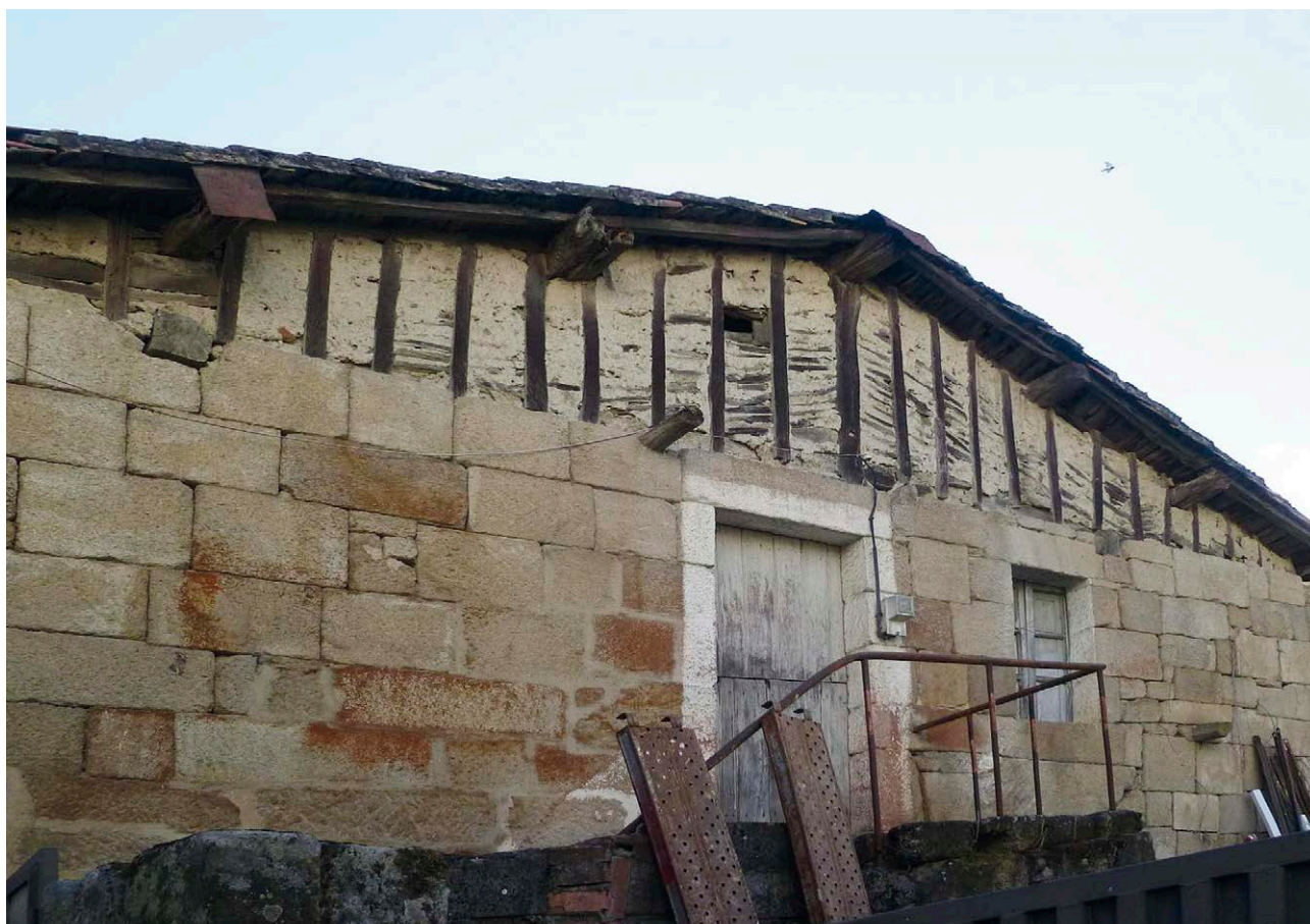
Fig. 9: Antigua vivienda en el lugar de Lavandeira, A Limia donde se realizan periódicas labores de mantenimiento
