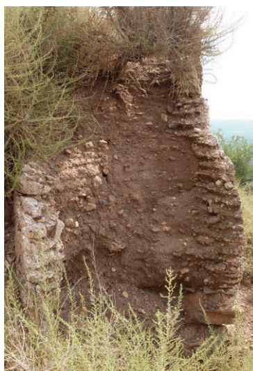
Fig. 12: Mecanismo de abombamiento y lavado del núcleo del muro por infiltración de agua en la coronación (dibujo: L. García)
