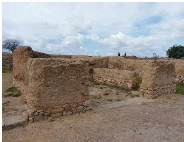
Fig. 6: Paredes de tapia en el yacimiento romano de Empúries, Girona (Ortiz)
