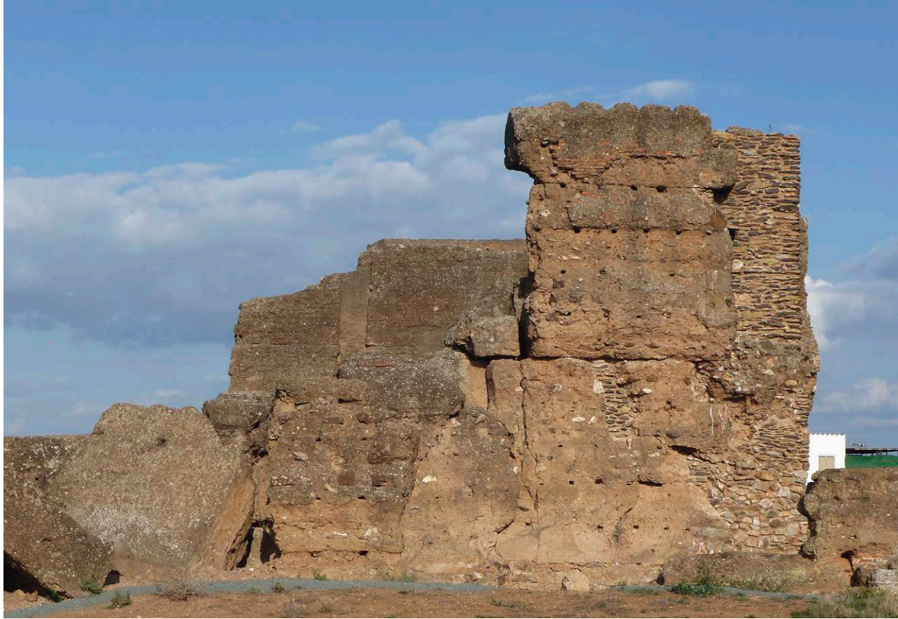
Fig. 1: Muros de tapia del castillo de Villanueva del Fresno
