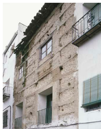
Fig. 11: Tapia de brencas sobre zócalo de mampostería en Morata de Tajuña (Fondo ETSAM)
