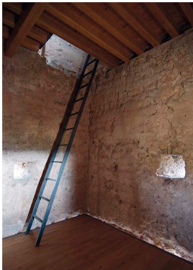
Fig. 8: Restitución de los forjados y escaleras internos
