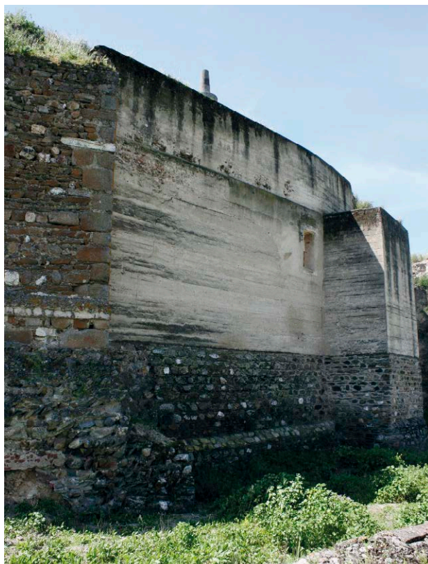
Fig. 5: Vista general del área intervenida en 1988-89
