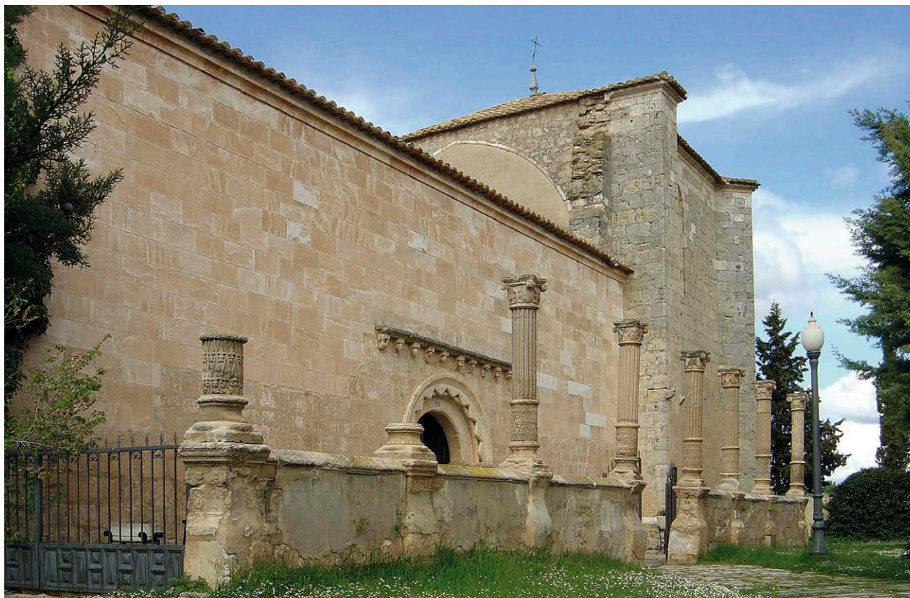
Fig. 1: Iglesia de San Nicolás de Bari. Estado de la fachada sur de la nave antes de la restauración. El chapado de piedra realizado en 1965 cubre la tapia de tierra original
