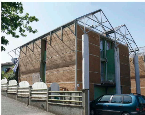
Fig. 6: Cuatro viviendas de tapia en el « Domaine de la Terre », Villefontaine, Isère, Francia. Proyecto de los arquitectos Gilles Perraudin y Françoise Jourda. Fotografía de Thierry Joffroy, CRAterre
