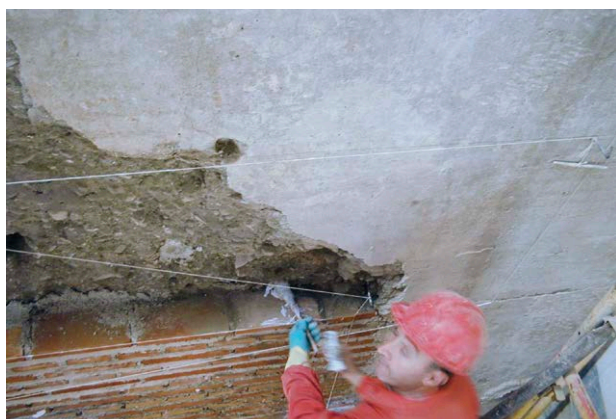
Fig. 9: Colocación de anclajes de madera para trabar las fábricas de ladrillo y tapia
