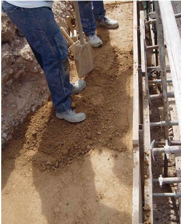
Fig. 1: Ejecución de tapia modificada con encofrado a una cara
