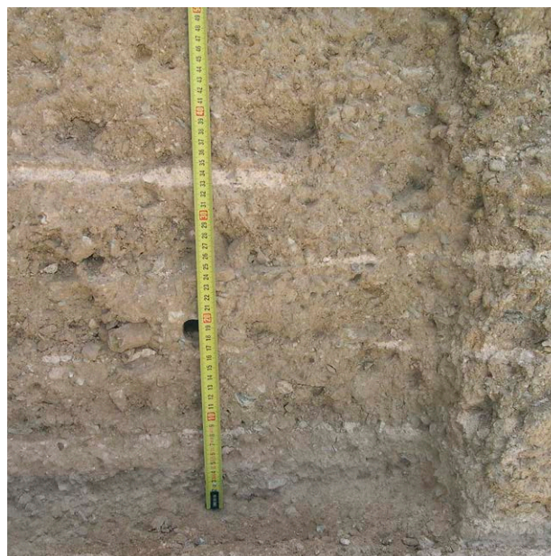
Fig. 2: Cata en tapia con tongadas de tierra apisonada y cal
