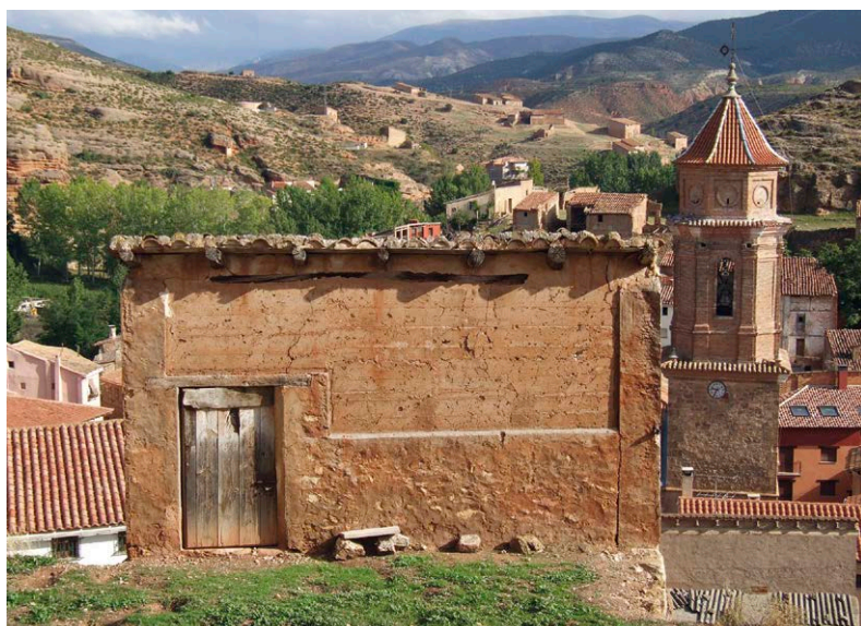
Fig. 6: Tapia de yeso en el Rincón de Ademuz (Vegas &amp; Mileto)
