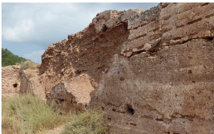
Fig. 17: Mecanismo de degradación de una tapia valenciana: erosión de la coronación y progresiva de la costra con pérdida de la misma (dibujo: L. García)
