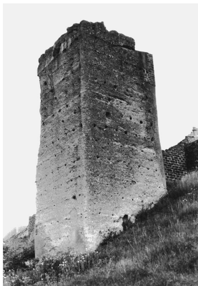
Fig. 7: Torre de tapia del lado noroeste de la medina (M. V. Gomes 1999)
