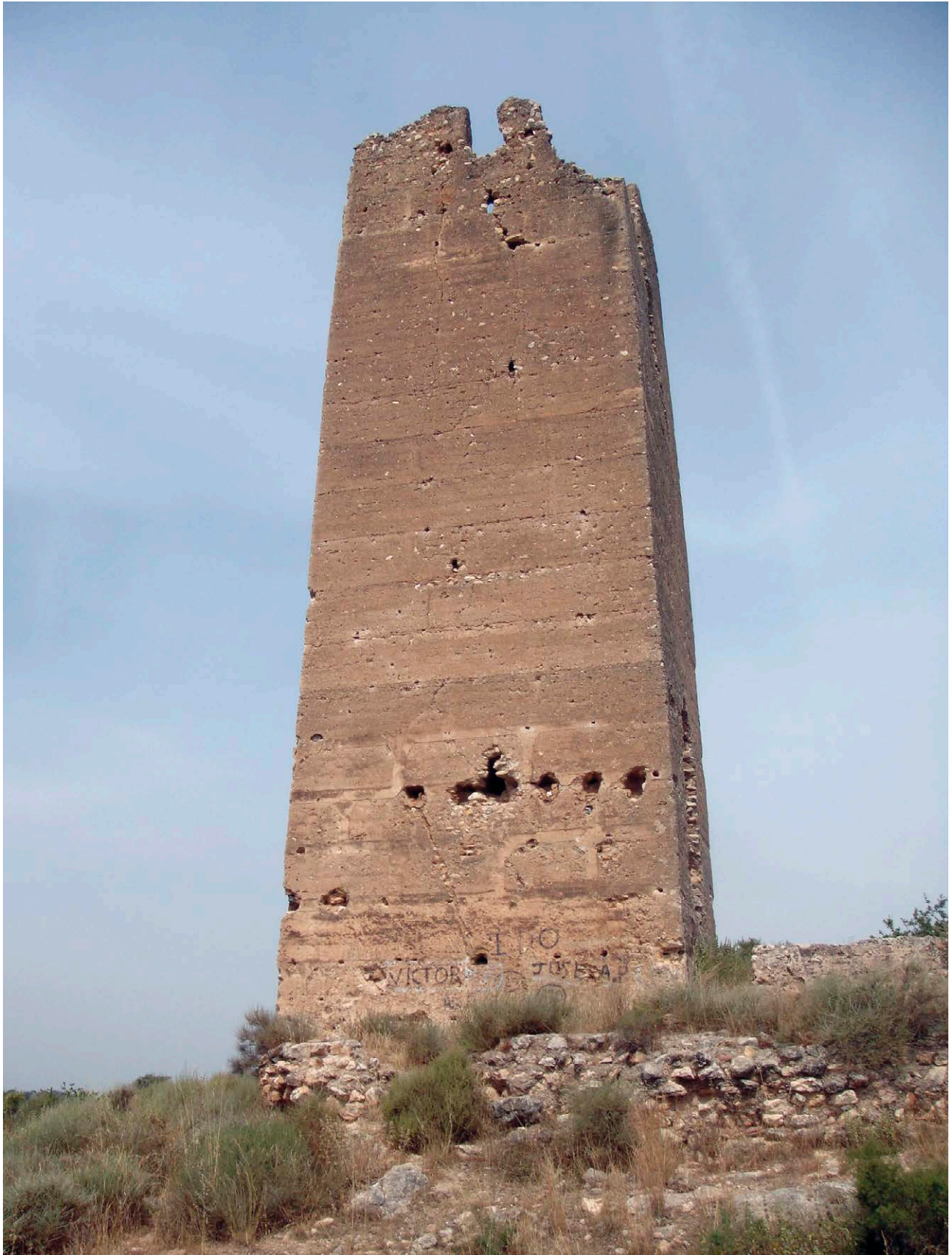
Fig. 3: Fachada oriental. Estado previo a la restauración
