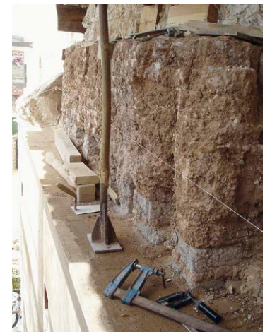
Fig. 2: Tapia original construida en el s. XV en su encuentro con la portada románica del siglo XIII, una vez retirado el chapado contemporáneo de piedra
