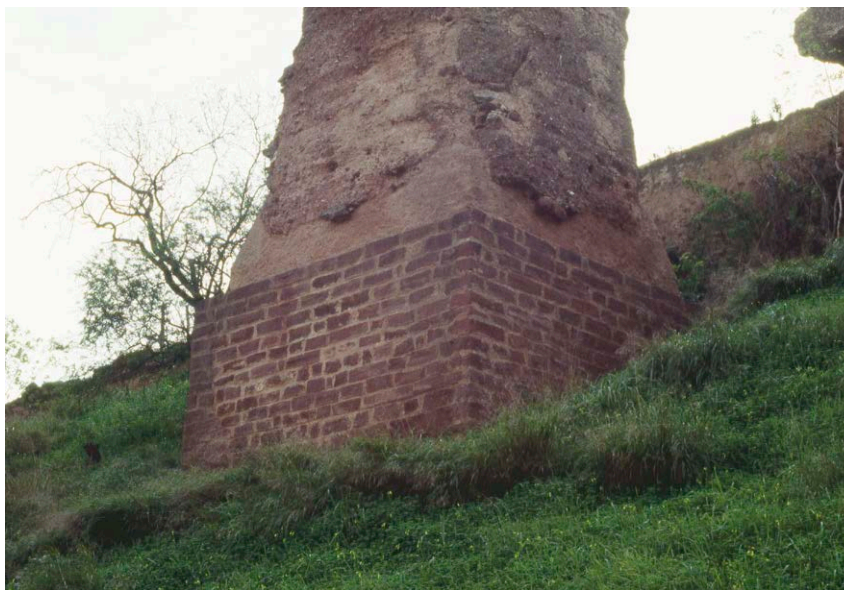
Fig. 7: Torre de tapia del lado noroeste de la medina (M. V. Gomes 1999)
