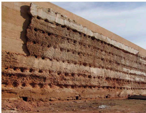
Figs. 6 y 7: Muro de tapia en las huertas del Generalife de la Alhambra de Granada. Fco. Javier López Martínez e Isabel Bestué Cardiel (2012)
