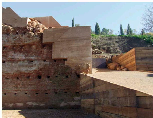
Figs. 6 y 7: Muro de tapia en las huertas del Generalife de la Alhambra de Granada. Fco. Javier López Martínez e Isabel Bestué Cardiel (2012)
