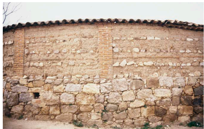
Fig. 07: Tapia con verdegadas de ladrillo en Villanueva de Perales (Fondo ETSAM)
