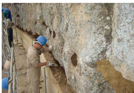
Fig. 3: Las 28 pruebas de tapia, realizadas a pie de obra
