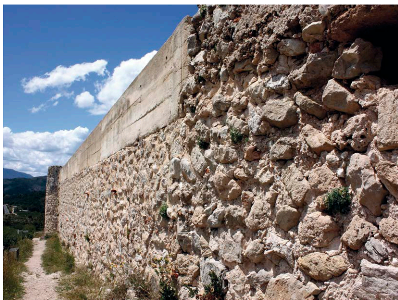
Fig. 8: Reintegración volumétrica parcial del lienzo de la muralla de la alcazaba del castillo de Bairén (Gandía) (M. Mestre)
