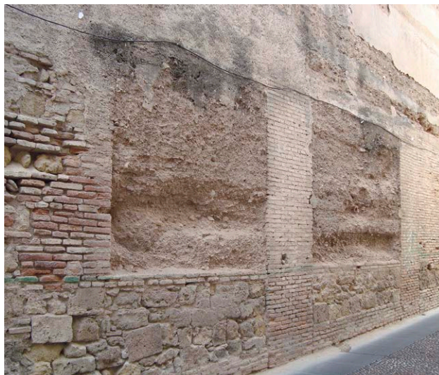
Fig. 19: Mecanismo de degradación de una tapia mixta con la erosión progresiva de la costra y la masa del cajón de tapia (dibujo: L. García)
