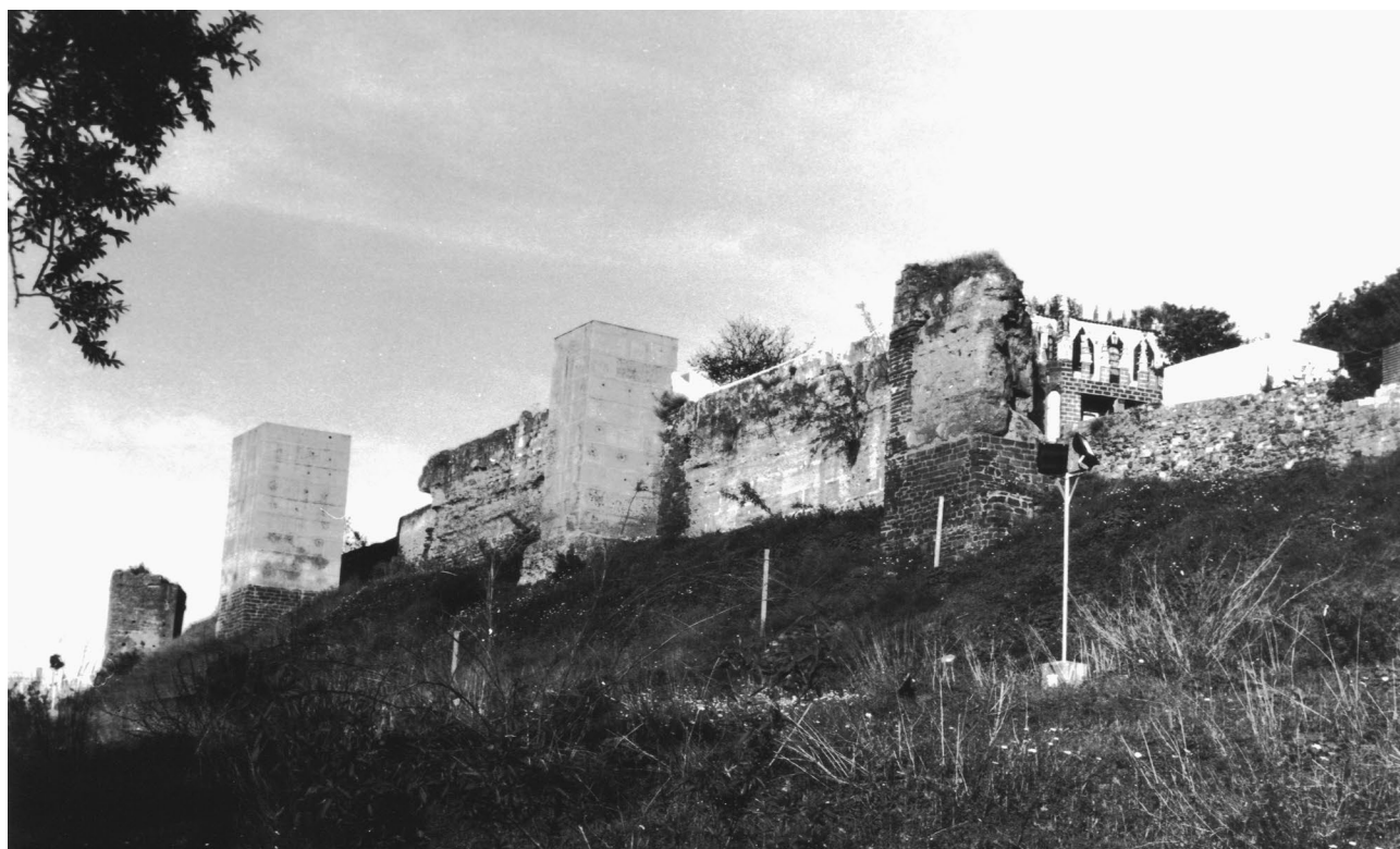
Fig. 9: Torres de piedra y de tapia del lado noroeste de la medina, después de las «restauraciones» (M. V. Gomes 1999)
