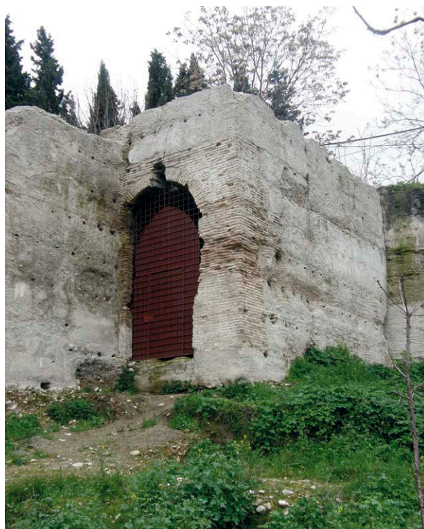
Fig. 8: Vista de un acceso en recodo
