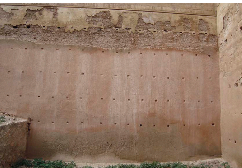
Fig. 3: Vista de una de las zonas intervenidas en las décadas anteriores a los ochenta. Enlucido con mortero de cemento y reproducción de los mechinales
