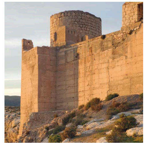
Fig. 2 a-b: Muralla del cerro de San Cristóbal. Los paramentos de tapia corresponden a las obras de consolidación de Francisco Prieto-Moreno realizadas a principios de los años sesenta del siglo XX
