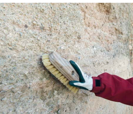
Fig. 6: Proceso de limpieza mecánica en seco mediante cepillado con cepillo de cerdas de nylon para eliminar el polvo y los depósitos superficiales no incrustados. Tramo de muralla ziri del Albaycín. Granada (Antonio Navarro Díez)
