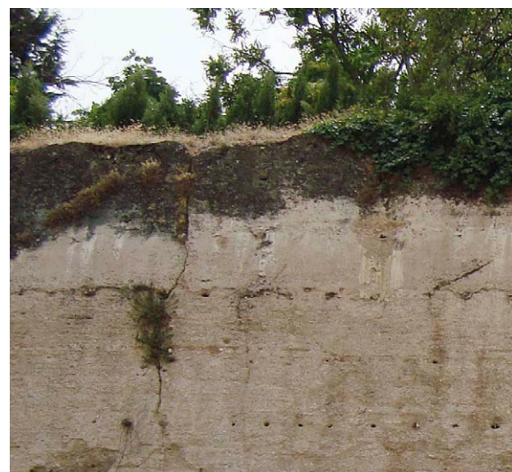
Fig. 9: Mecanismo de erosión de la coronación del muro por acción de los agentes atmosféricos (dibujo: L. García)
