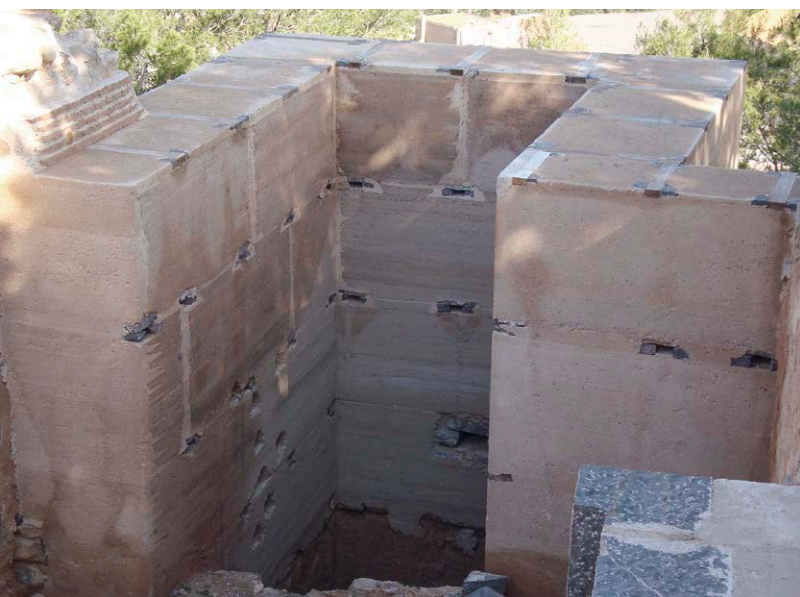
Fig. 3: Estado actual de la torre norte del castillo de Oropesa del Mar (L. García)
