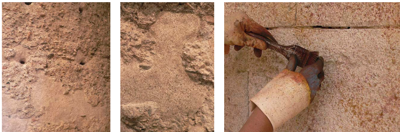
Fig. 16: Fragmento de tapia de la torre del Palacio de Bibataubín en Granada tras la restauración. Se observan las lagunas de mortero de restitución integradas cromáticamente
