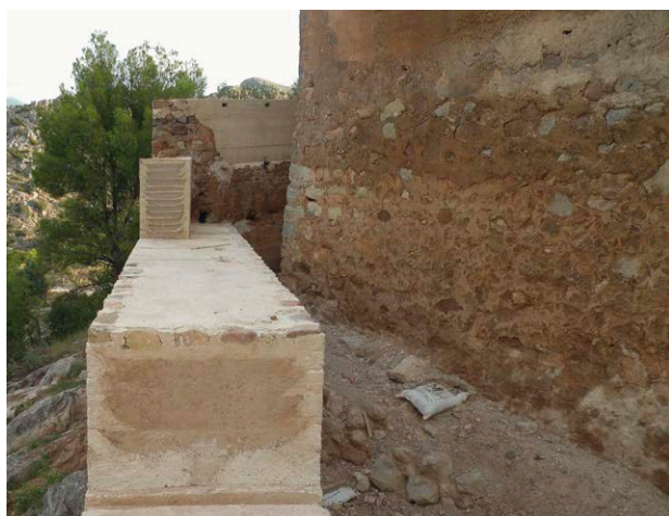
Fig. 6: Primer plano del paramento descubierto del muro de cierre del tercer recinto en donde se pueden apreciar las huellas dejadas por los tapiales
