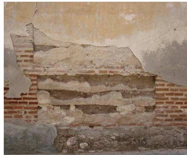
Fig. 19: Mecanismo de degradación de una tapia mixta con la erosión progresiva de la costra y la masa del cajón de tapia (dibujo: L. García)
