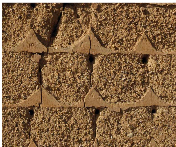
Fig. 9: Tapia valenciana en la muralla de Mascarell (Vegas & Mileto)
