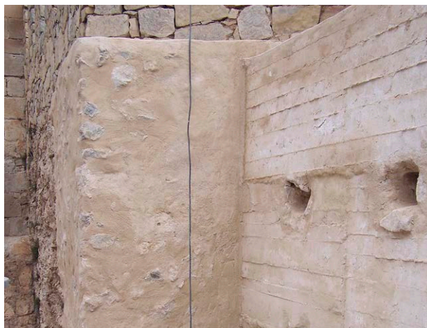
Fig. 8: Detalle de los paramentos restaurados
