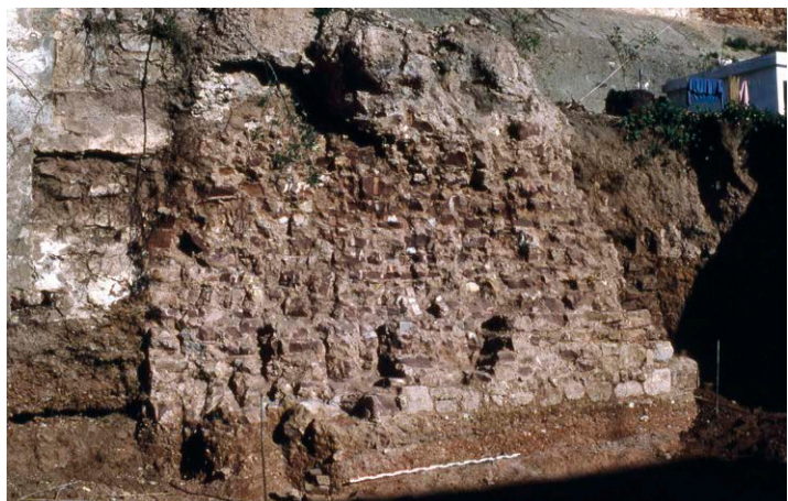
Fig. 2: Torre de la medina con base de piedra y erigida en tapia, vista de cuando fue demolida parcialmente (M. V. Gomes 1980)
