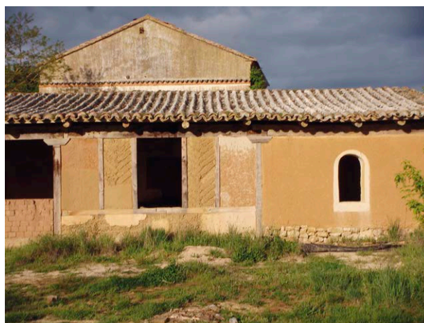
Fig. 2: Cobertizo construido en Amayuelas (Palencia) para la experimentación con técnicas de construcción en tierra
