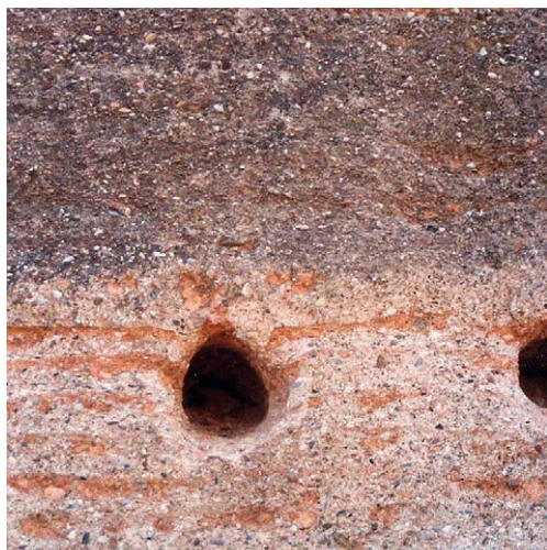
Fig. 9: Eliminación de líquenes a mitad de proceso. Tramo de muralla zirí del Albaycín. Granada
