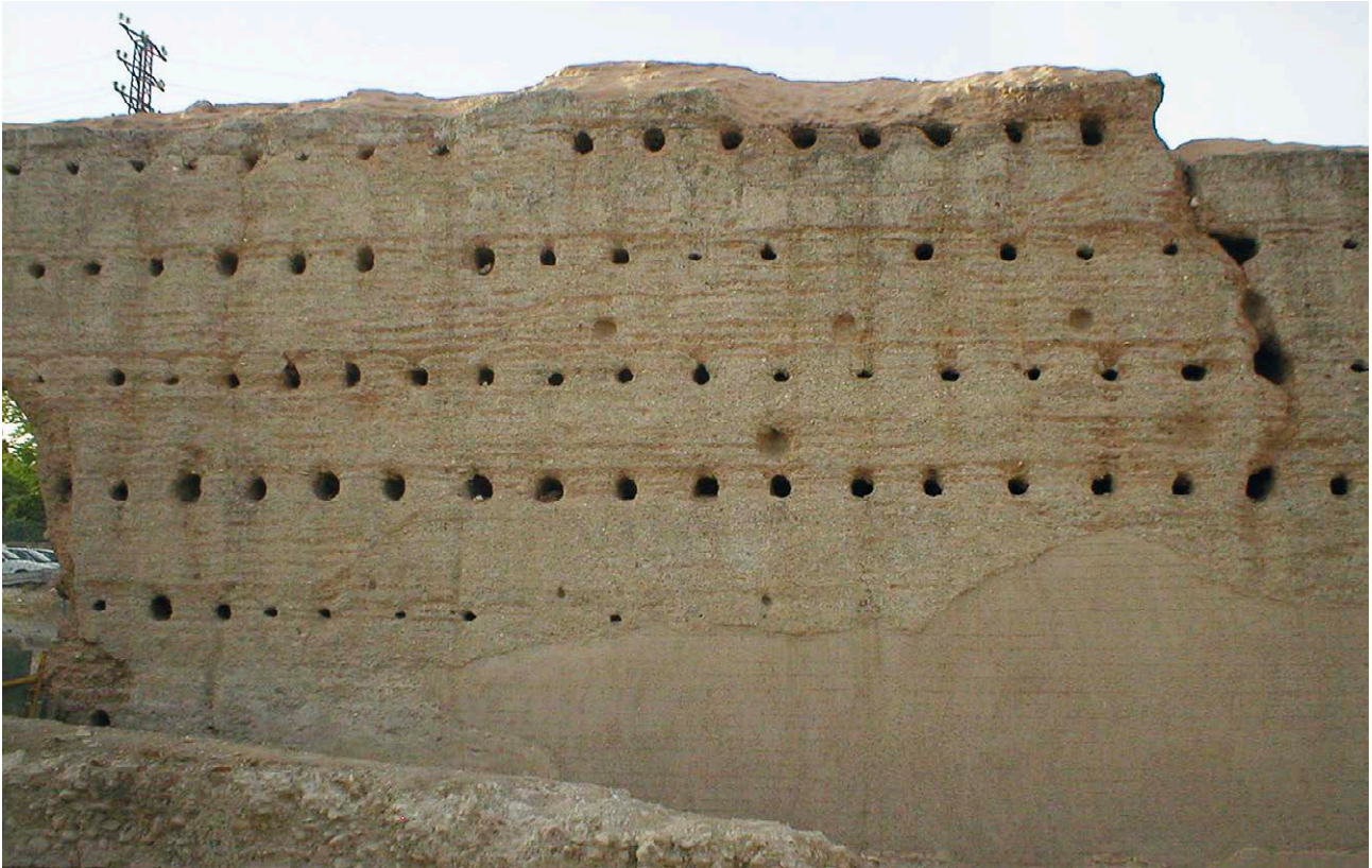
Fig. 7: Ejemplo de reintegración en la base de la muralla
