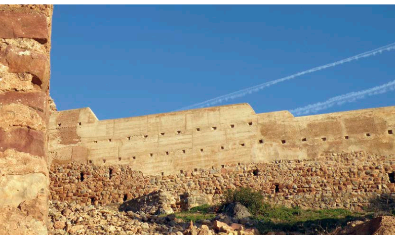
Fig. 9: El muro norte del segundo recinto o albacara, visto desde el tercer recinto o la vila
