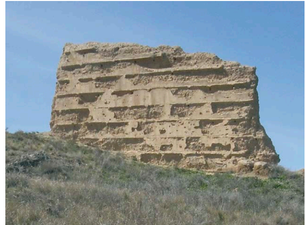
Fig. 4: Muro con una hilada de fábrica de ladrillo delimitando las sucesivas hiladas de la tapia
