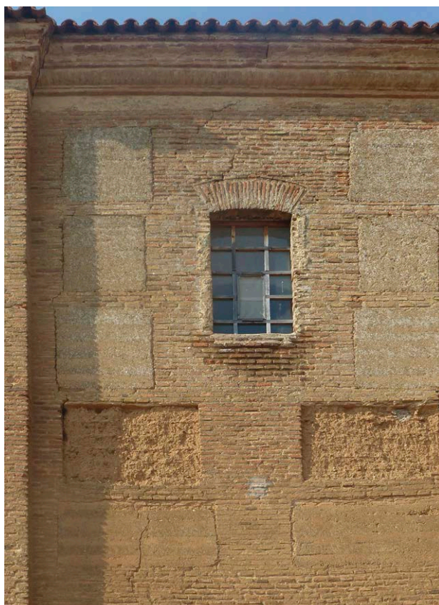
Fig. 12: Detalle de la fábrica mixta sin restaurar de la Iglesia de La Peregrina en Sahagún (León)
