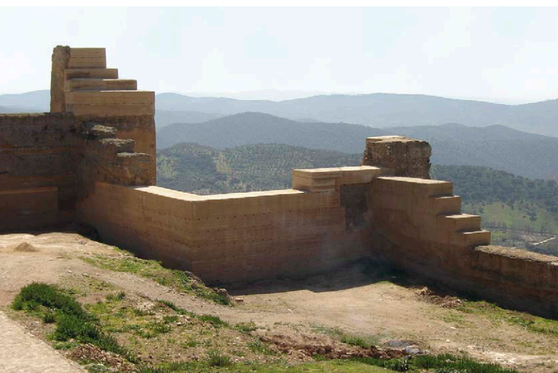
Fig. 3: Frente suroeste de la muralla de la fortaleza de Reina, ya consolidada
