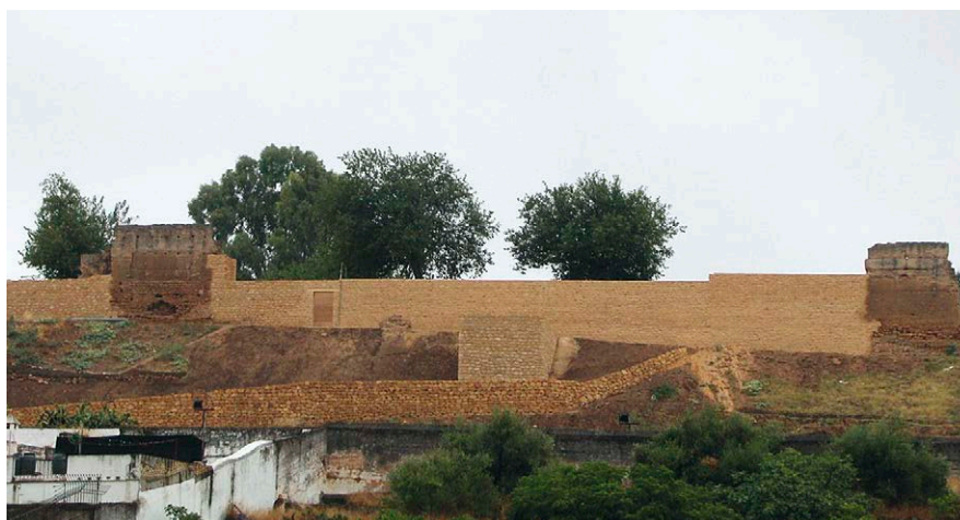
Fig. 3: Vista general de los lienzos restituidos en el tramo norte de la muralla de la villa (A. Martín Molina &amp; M. Díaz Recaseus)
