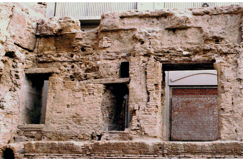
Fig. 1: Estado de la muralla antes de la intervención
