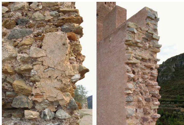
Fig. 5: Detalle del estado actual de las superficies de la torre (imagen de la autora)
