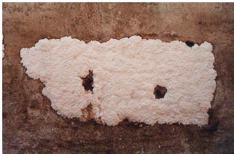
Fig. 9: Eliminación de líquenes a mitad de proceso. Tramo de muralla zirí del Albaycín. Granada
