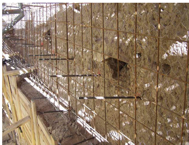
Fig. 6: Elementos de conexión
