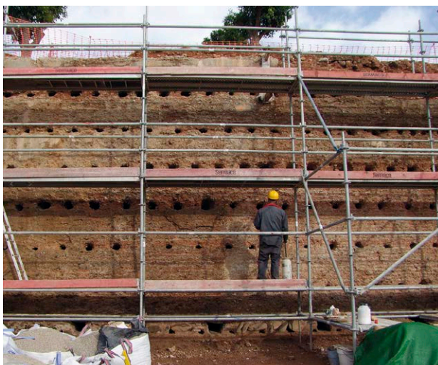
Fig. 5: El muro antes de la intervención
