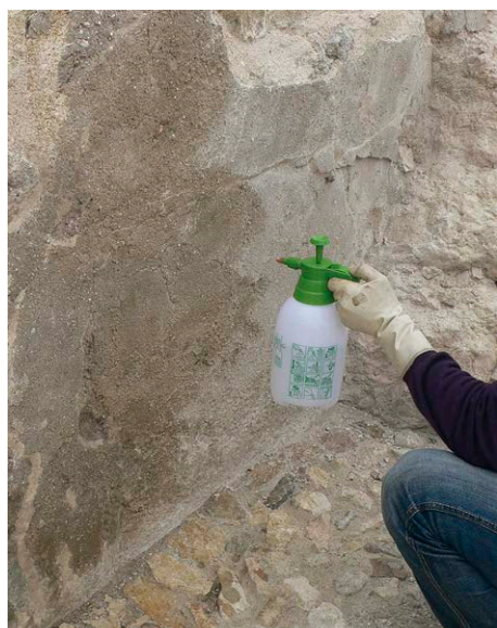
Fig. 14: Proceso de hidrofugación por aspersión de compuesto a base de siloxanos. Castillo de Castril (Granada)
