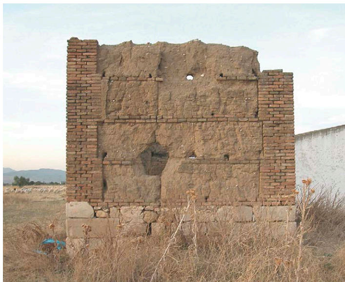
Fig. 17: Restos de construcción de tapia en Talamanca de Jarama (Chantal Esquivias)
