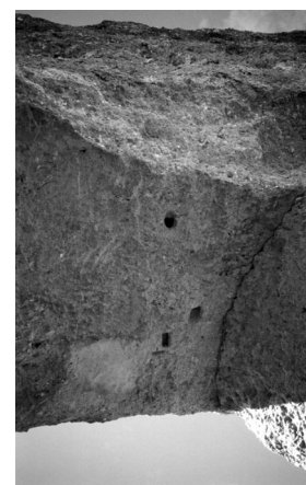
Fig. 6: Restos de orificios de los codales de madera
