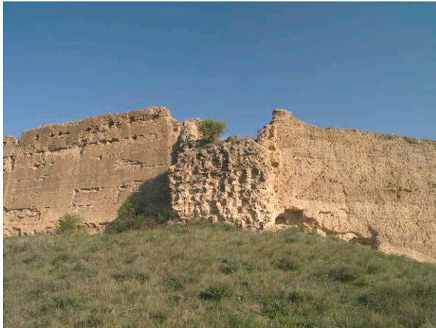
Fig. 3: Muro lado izquierdo mejor conservado que muro lado derecho
