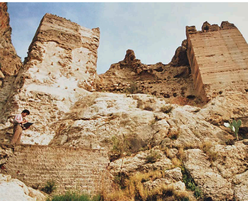
Fig. 3: Aspecto del muro intervenido (1995)
