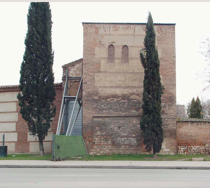
Fig. 1: Vista de la Puerta de Burgos desde el exterior del recinto amurallado, previa a la intervención (Depto. Arquitectura, Obispado Alcalá de Henares)
