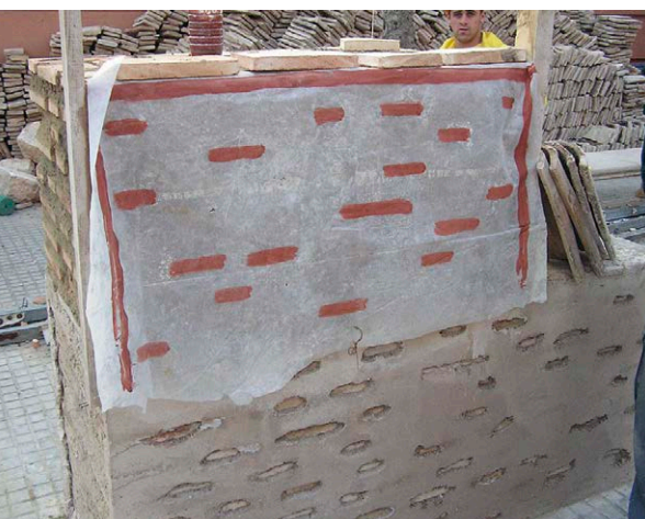
Fig. 3: Sección horizontal del interior de una tapia
