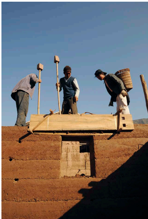
Fig. 2: Obra de construcción con tapia, Pueblo de Maanqiao, Condado de Huili, Sichuan, China, fotografía cortesía de Mu Jun
