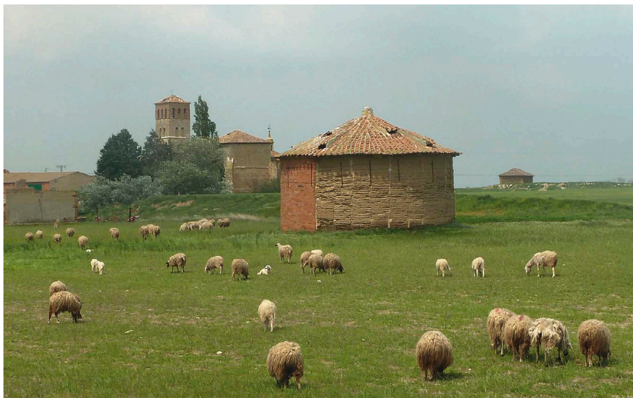
Fig. 4: Palomar de Tierra de Campos reparado con una fábrica de ladrillo en un sector
