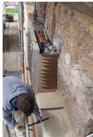
Fig. 2: Tapia original construida en el s. XV en su encuentro con la portada románica del siglo XIII, una vez retirado el chapado contemporáneo de piedra
