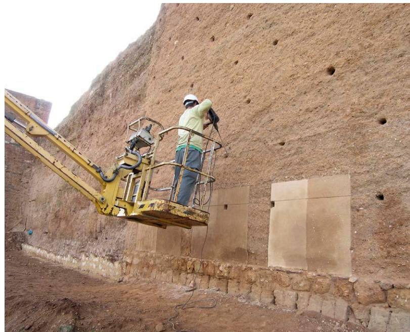
Fig. 4: Compactación de un cajón junto con varillas en «U» (Manuel López Vicente 2003)
