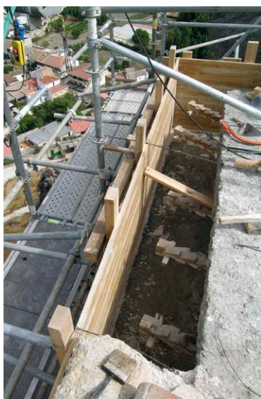
Fig. 4a-b-c: Proceso de instalación, apisonado y desmontaje de tapiales
