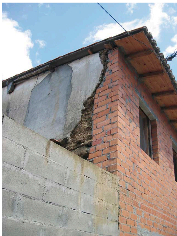
Fig. 3: Tratamiento habitual de una tapia en Monforte en una rehabilitación de vivienda
