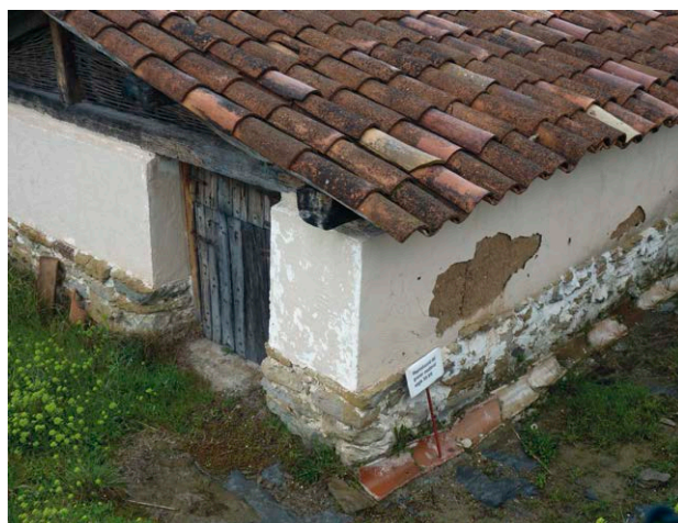
Fig. 4: Reconstrucción con tapia en el yacimiento arqueológico de Masies de Roda de Ter, Barcelona (Ortiz)
