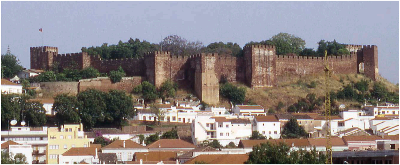
Fig. 3: Vista del lado oriental de la alcazaba con torres de arenisca y tapia (M. V. Gomes 1999)
