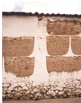
Fig. 07: Tapia con verdegadas de ladrillo en Villanueva de Perales (Fondo ETSAM)
