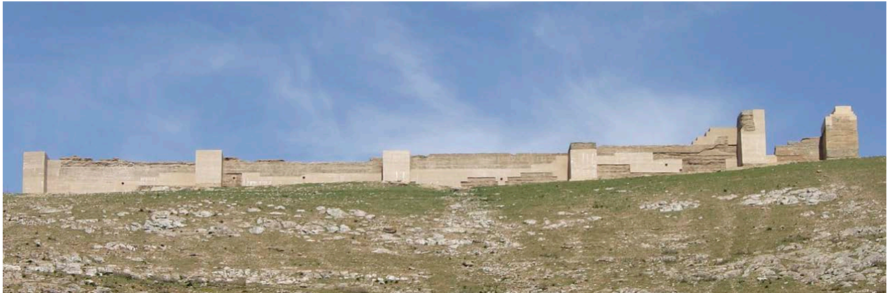
Fig. 11: Vista general de la cerca almohade del recinto fortificado de Reina
