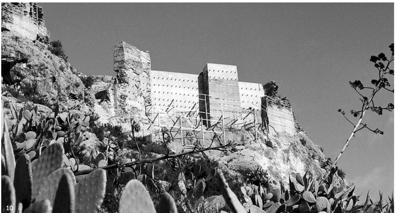
Fig. 10: Vista general de la fortaleza con los trabajos ultimados
