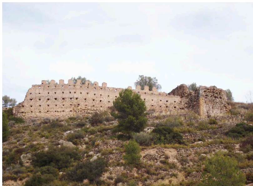
Fig. 2: Muralla exterior y restos de una de las torres, construidos con tapia de piedra o mampostería encajonada (imagen de la autora)
