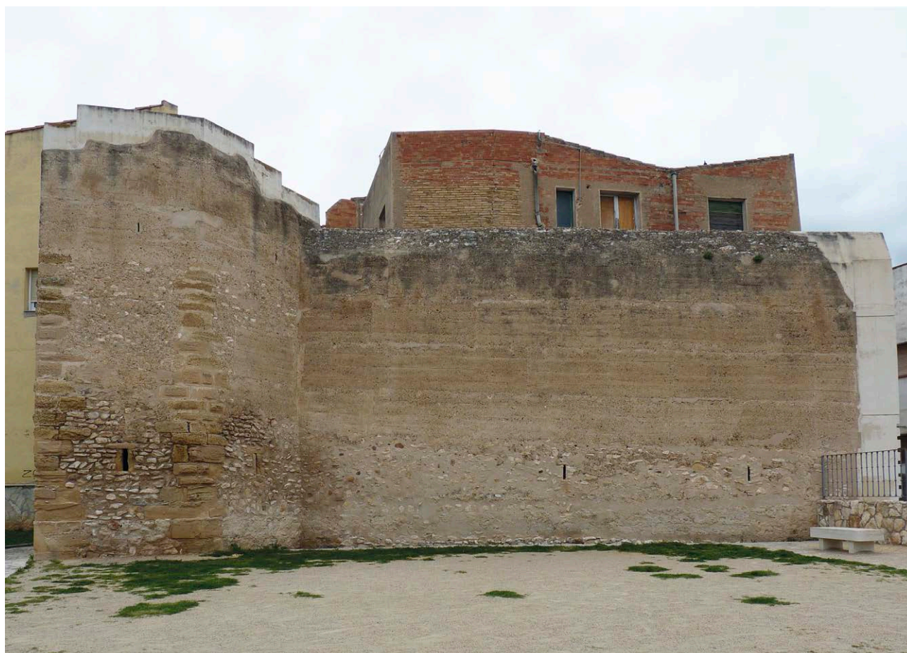
Fig. 10: Intervención en la Muralla de Costantí, Tarragona (Ortiz)
