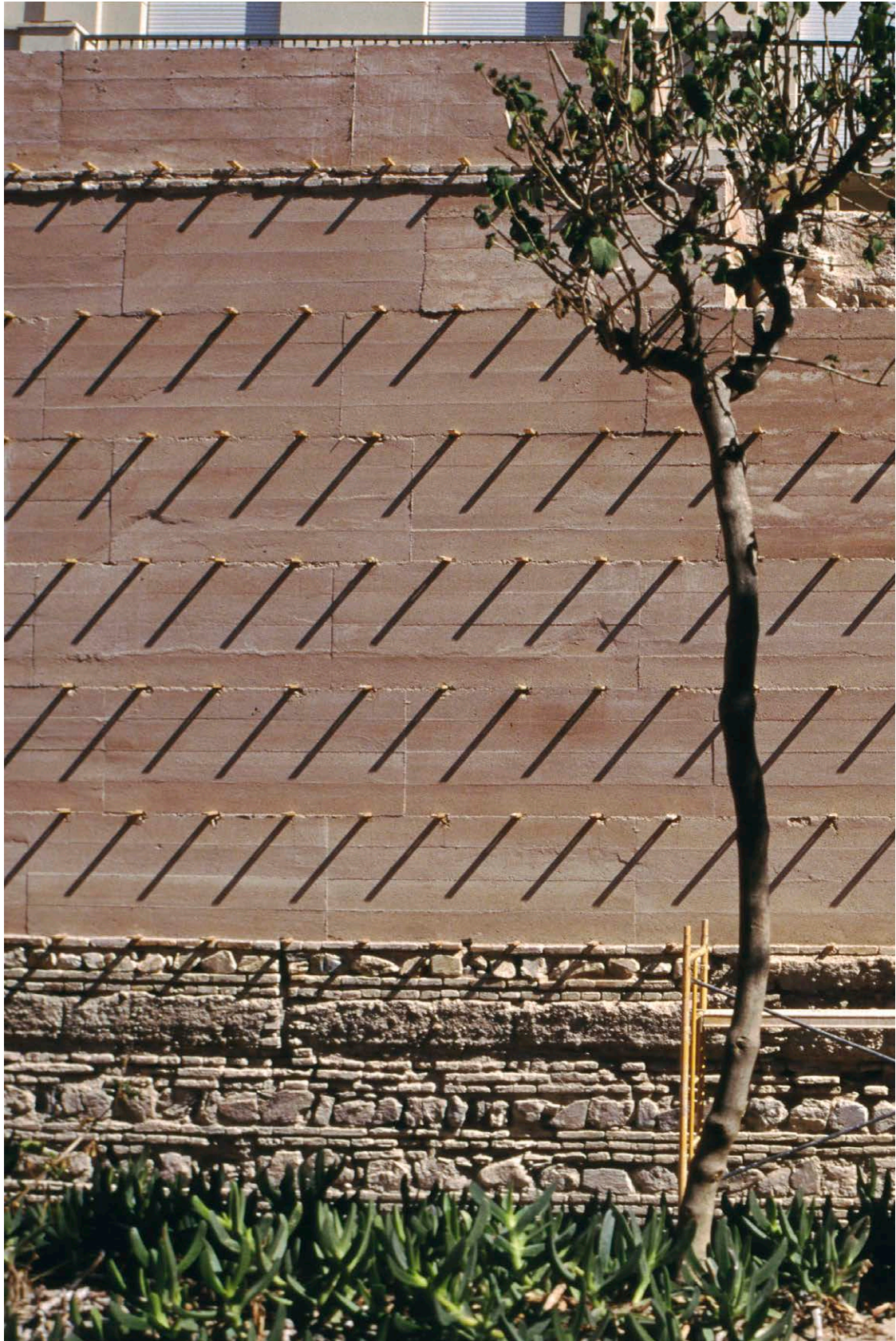
Fig. 3: Aspecto final de la muralla
