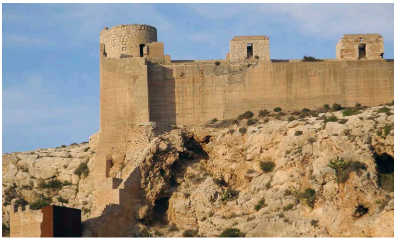
Fig. 2 a-b: Muralla del cerro de San Cristóbal. Los paramentos de tapia corresponden a las obras de consolidación de Francisco Prieto-Moreno realizadas a principios de los años sesenta del siglo XX
