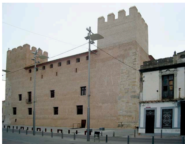
Fig. 10: Estado final de la torre reconstruida
