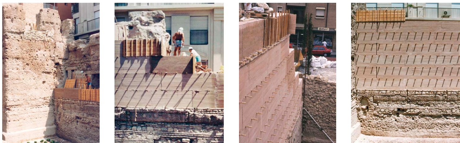
Figs. 4-7: Imágenes del proceso de construcción
