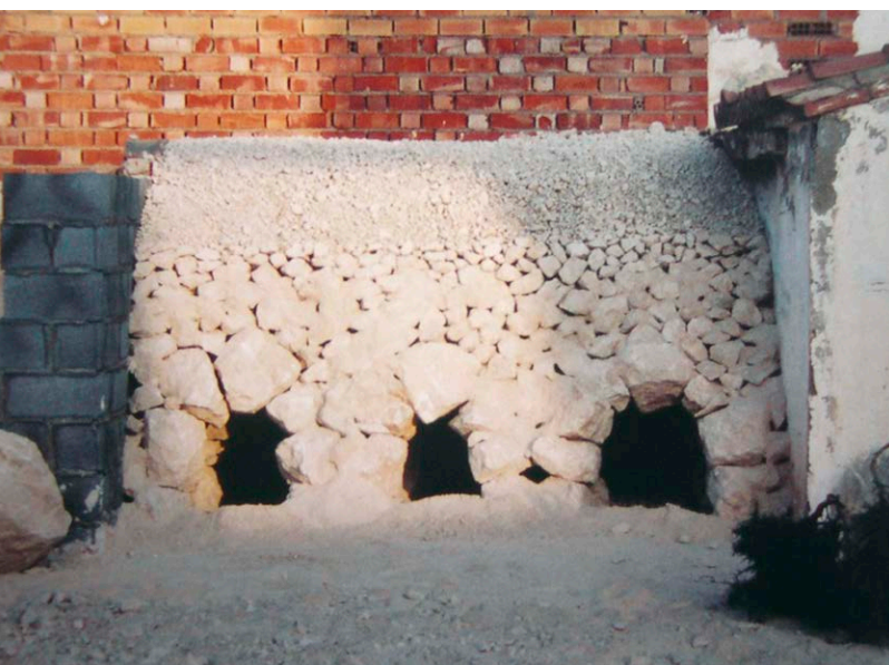
Fig. 10: Horno de yeso realizado en Teruel con motivo de la restauración de la arquitectura mudéjar de la ciudad
