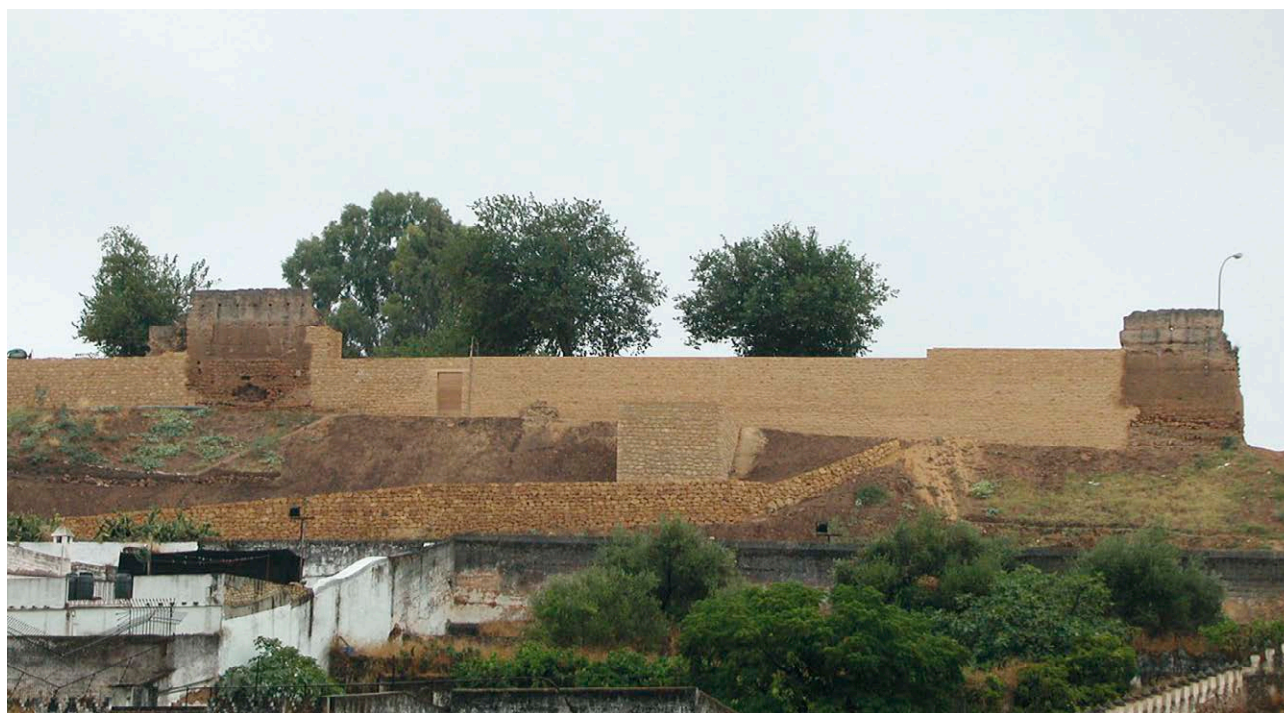
Fig. 6: Vista general del lienzo norte de la Muralla de la Villa, Alcalá de Guadaíra, Sevilla
