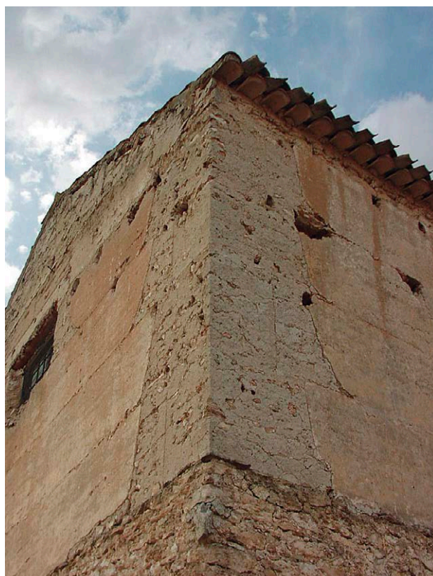
Fig. 12: Tapia con rafas de yeso en las esquinas (F. J. Castilla)
