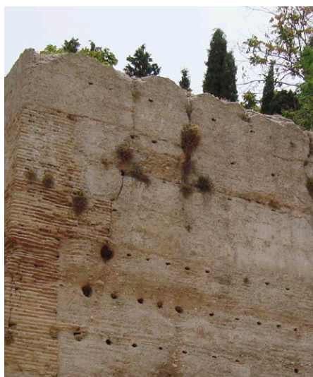
Fig. 9: Mecanismo de erosión de la coronación del muro por acción de los agentes atmosféricos (dibujo: L. García)
