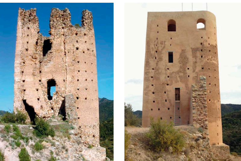
Fig. 3: Iz.: Vista de la torre antes de la intervención (web del Ministerio de Fomento). Der.: Vista después de la intervención (foto de la autora)
