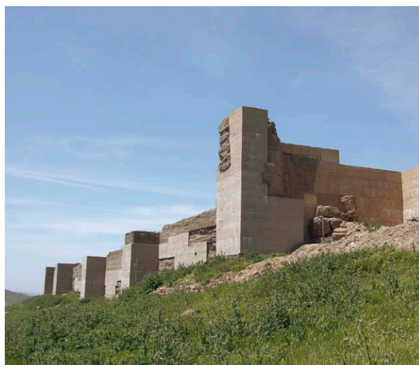
Fig. 4: Interior de la muralla de la fortaleza de Reina, ya consolidada
