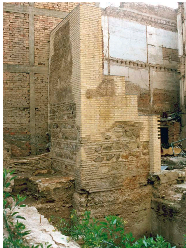
Fig. 2: Torre de la muralla en calle de la Merced, Murcia
