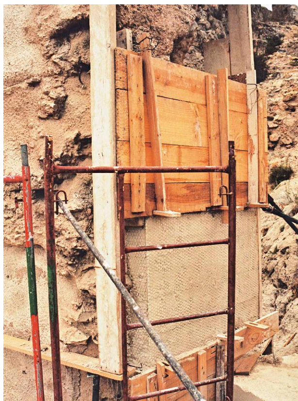
Fig. 6: Detalle de las obras con la texturización de los acabados
