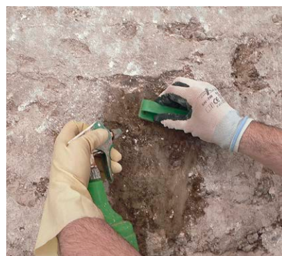
Fig. 6: Proceso de limpieza mecánica en seco mediante cepillado con cepillo de cerdas de nylon para eliminar el polvo y los depósitos superficiales no incrustados. Tramo de muralla ziri del Albaycín. Granada (Antonio Navarro Díez)
