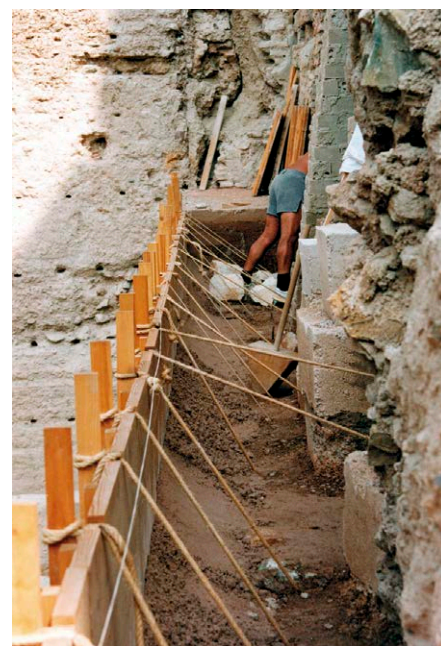
Fig. 2: Reconstrucción de la tapia, encofrada a una cara
