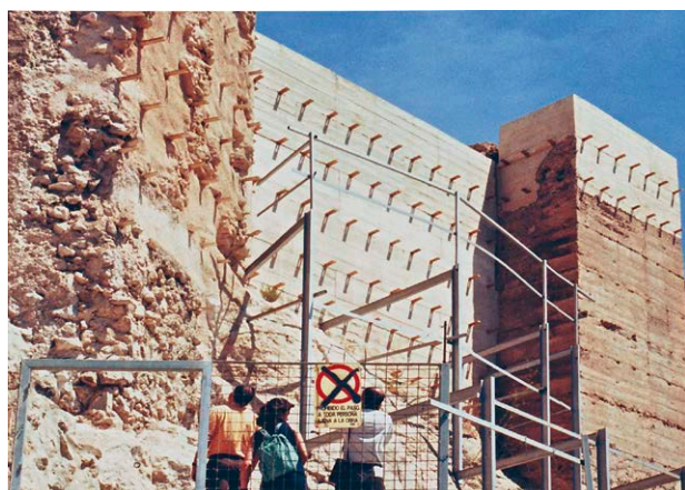
Fig. 6: Vista de las dos actuaciones en el castillo de Monteagudo
