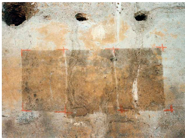
Fig. 11: Proceso de consolidación por aspersión de compuesto inorgánico (agua de cal). Tapia interior de la iglesia parroquial de El Borge (Málaga)
