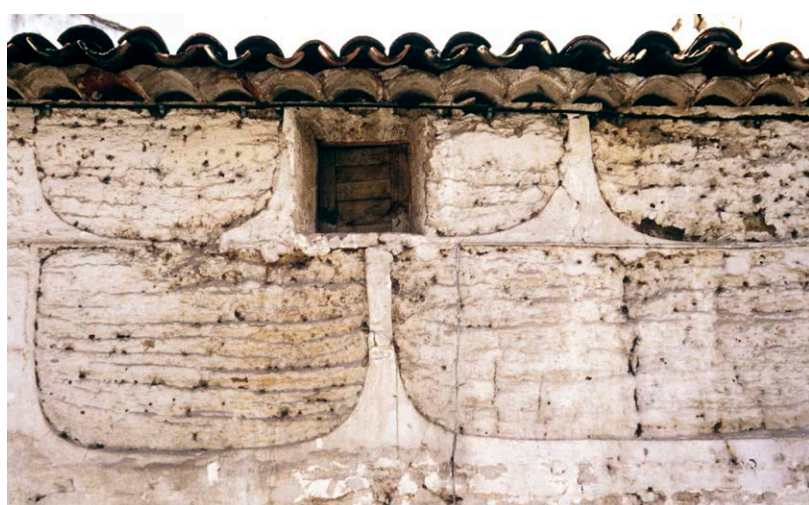
Fig. 02: Muros de adobe en una vivienda de Cenicientos (Fondo ETSAM)
