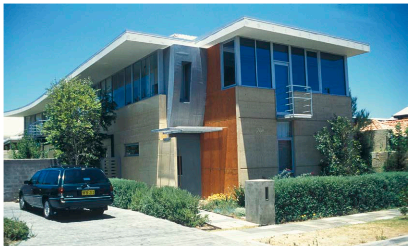
Fig. 10: Casa de tapia en Australia Occidental, región de Perth. Realizada por Stephen Dobson / Ramtec. Fotografía de Philippe Garnier, CRAterre
