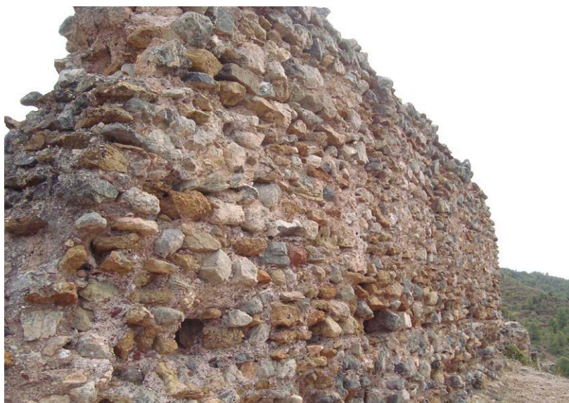
Fig. 4: Muro de mampostería encofrada en el castillo de Almonecir (García Soriano)
