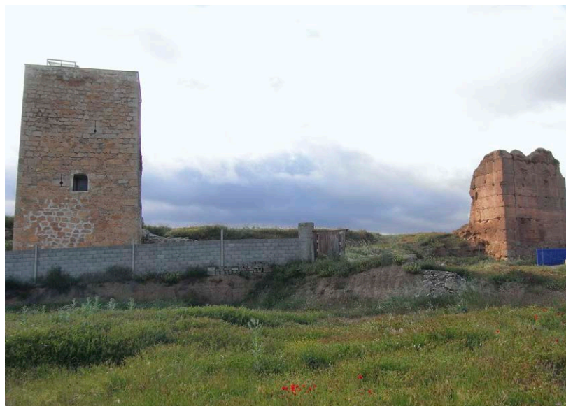
Fig. 3: Torreón defensivo de tapia en ruinas junto a torreón de piedra restaurado en Báguena
