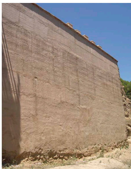
Fig. 5: Prueba de tapia de tierra calicostrada del espesor de la muralla
