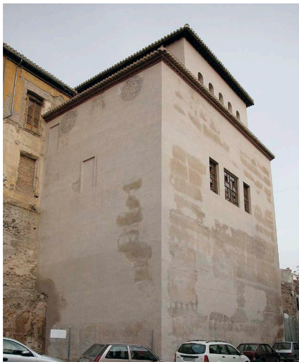
Fig. 11: El Cuarto Real de Santo Domingo después de la restauración de 2001-2004
