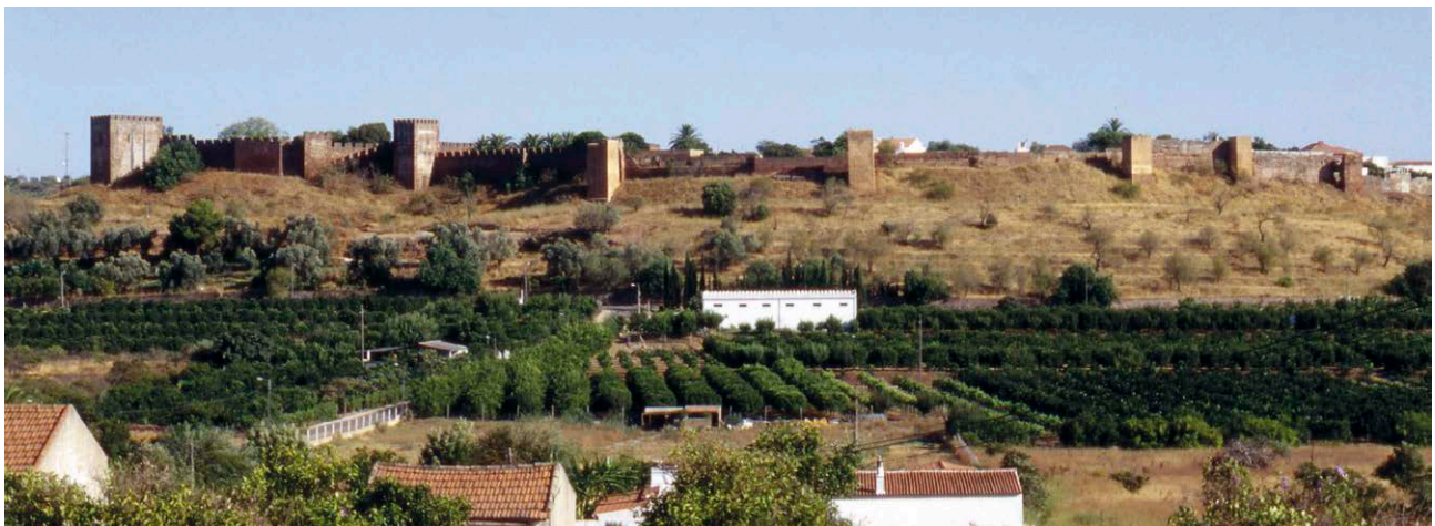
Fig. 4: Vista del lado noroeste de la muralla y las torres de la medina, construidas con tapia (M. V. Gomes 1999)
