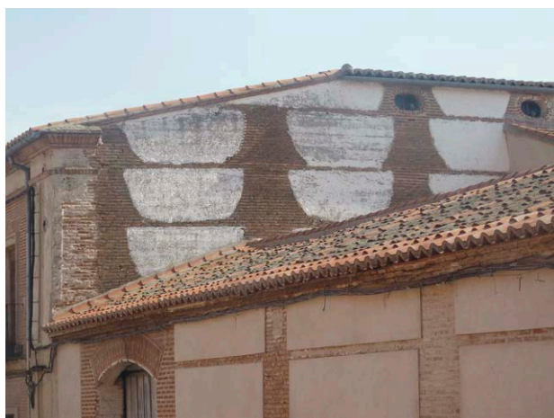
Fig. 1: Medianera de una casona en Madrigal de las Altas Torres (Ávila) que muestra un interesante ejemplo de rafas acampanadas de ladrillo
