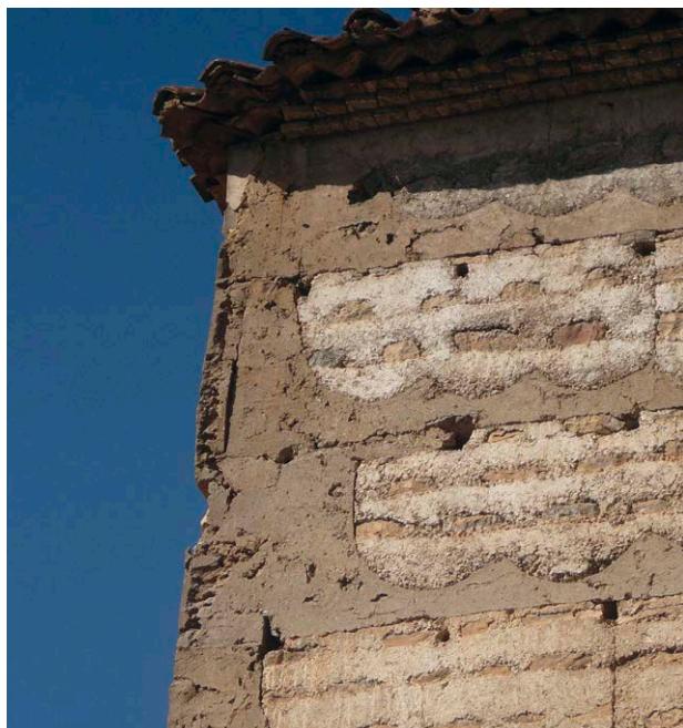
Fig. 13: Tapia con brecas y rafas de yeso careada con piedra en el Rincón de Ademuz (Vegas & Mileto)
