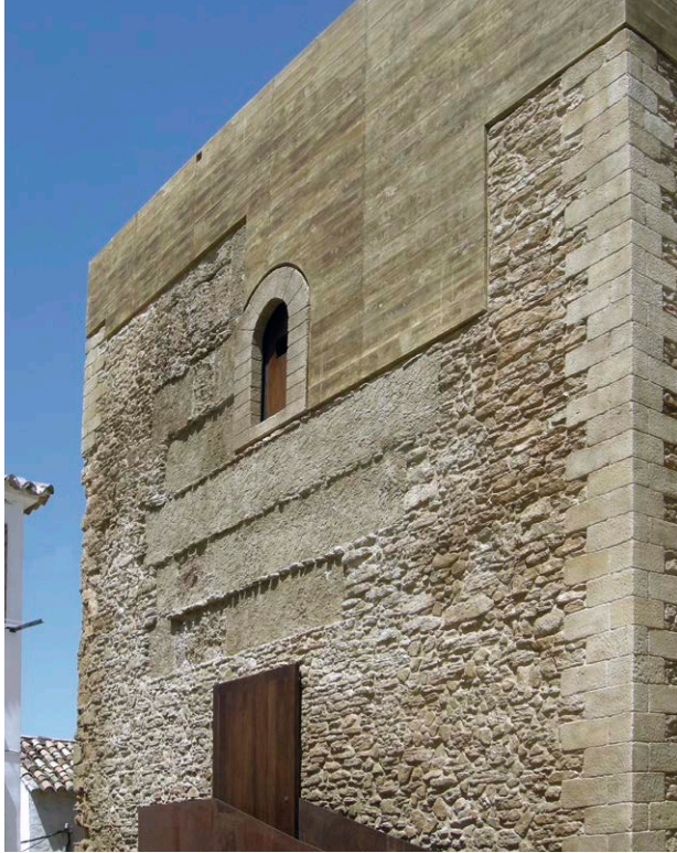
Fig. 2: Torre del Homenaje de Setenil de las Bodegas, Cádiz
