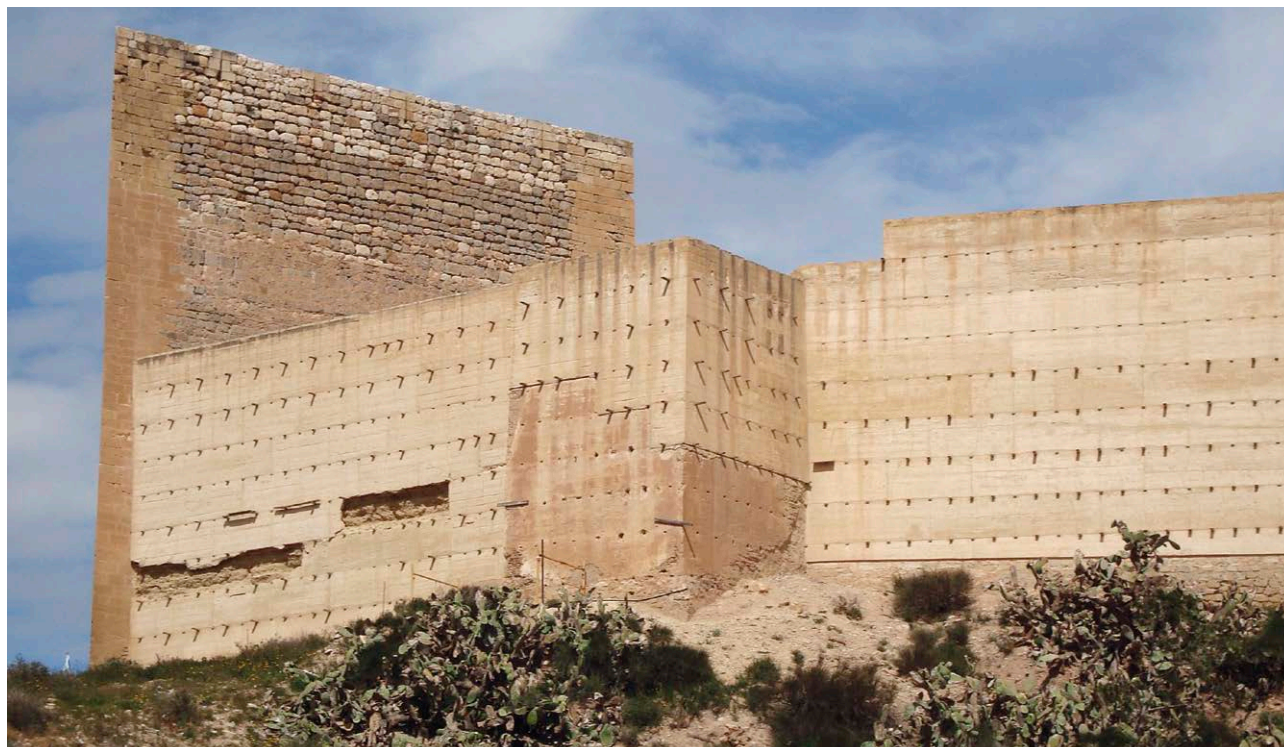
Fig. 8: Vista actual del lienzo sur en el que se han desprendido algunas tapiadas propias de la intervención de principios de los años 90
