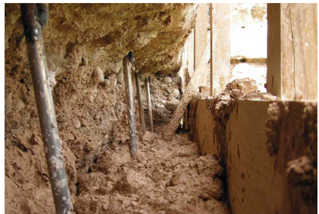
Figs. 2 y 3: Restauración del tramo de la Macarena (2008) con restitución de hilos inferiores y superiores
