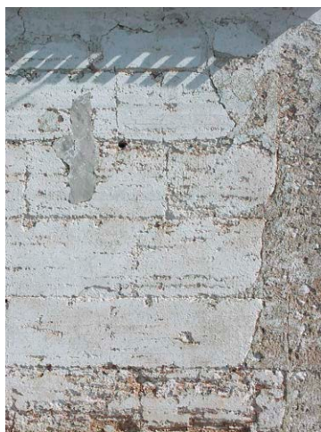
Figs. 1, 2, 3: Tapia de tierra en Villarrobledo (Albacete) / Tapia calicostrada con rafas de yeso en las esquinas en Golosalvo (Albacete) / Tapia de hormigón de cal en el castillo de Cotillas (Albacete)
