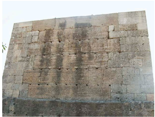
Fig. 3: Área restituida de tapia en la Torre de Don Fadrique
