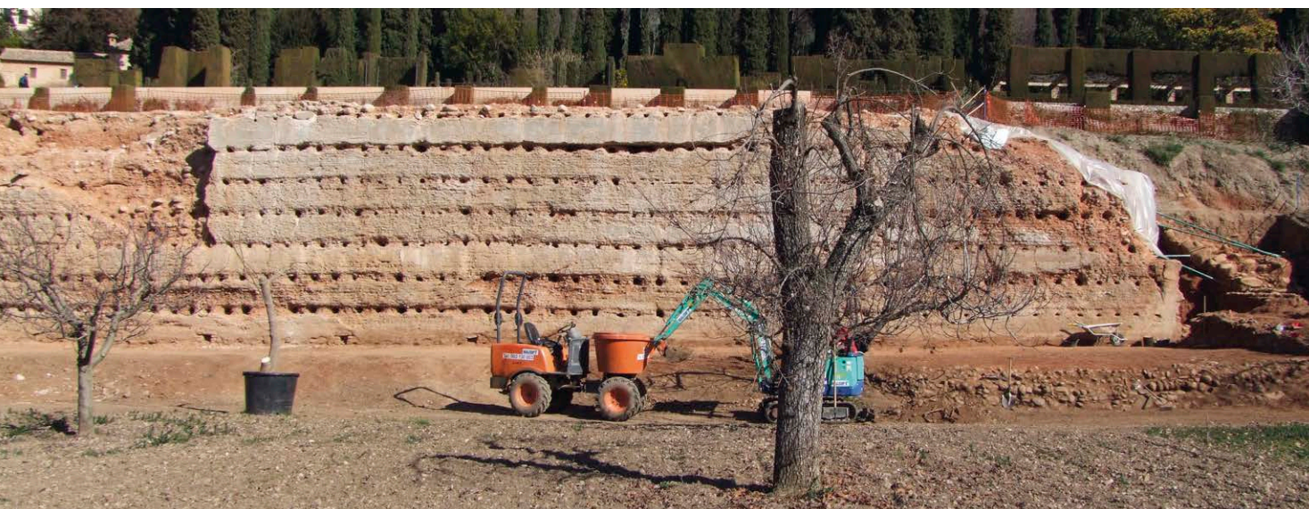
Fig. 13: Vista desde el Oeste del extremo sur, antes de las obras
