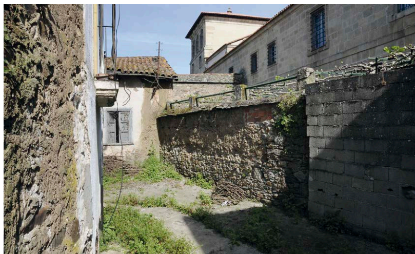
Fig. 4: Tapia del Mosteiro das Clarisas revocado con mortero de cemento
