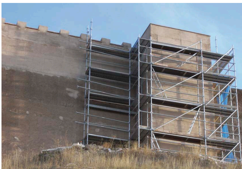
Fig. 6: Tapia de tierra calicostrada con malla en regularización de antepecho del paso de ronda
