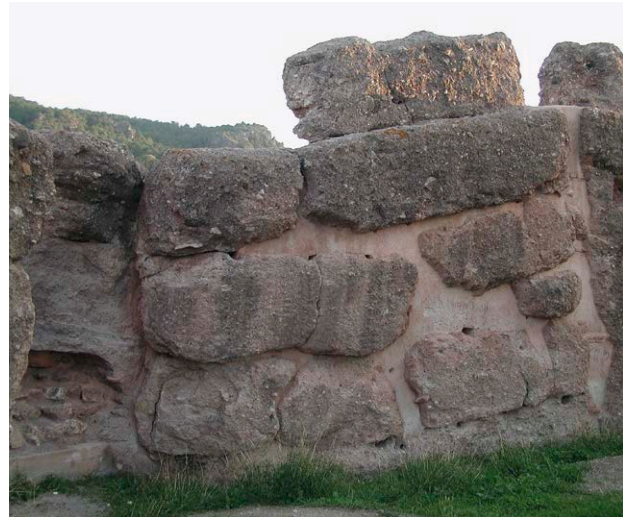
Fig. 10: Murcia. La Luz. Tapias cabalgando unas sobre otras
