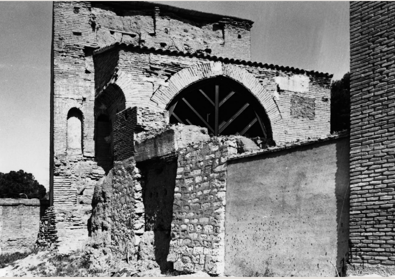
Fig. 2: Imagen interior de la Puerta de Burgos tras unas primeras intervenciones de apeo del arco central (Basilio Pavón Maldonado, Archivo Obispado de Alcalá)
