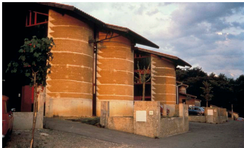
Fig. 7: Cuatro viviendas de tapia en el «Domaine de la Terre», Villefontaine, Isère, Francia. Proyecto del arquitecto Jean-Vincent Berlottier. Fotografía de Thierry Joffroy, CRAterre
