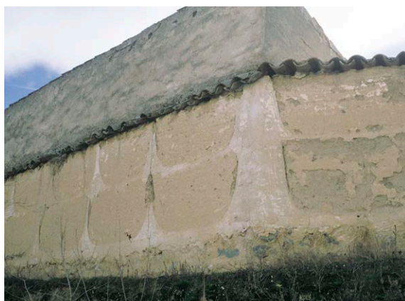
Fig. 14: Solución de esquina en ladrillo en una tapia de Valdeavero (Fondo ETSAM)
