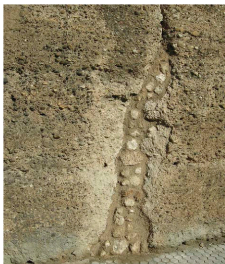
Fig. 4: Restauración del tramo de la Macarena (2008), reparación de grieta
