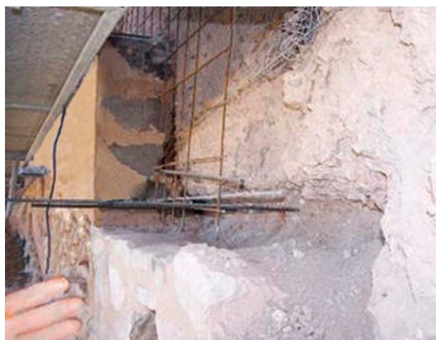
Fig. 7: Base de mampuesto regularizada, tongadas de hormigón gris en el alma y blanco en la superficie
