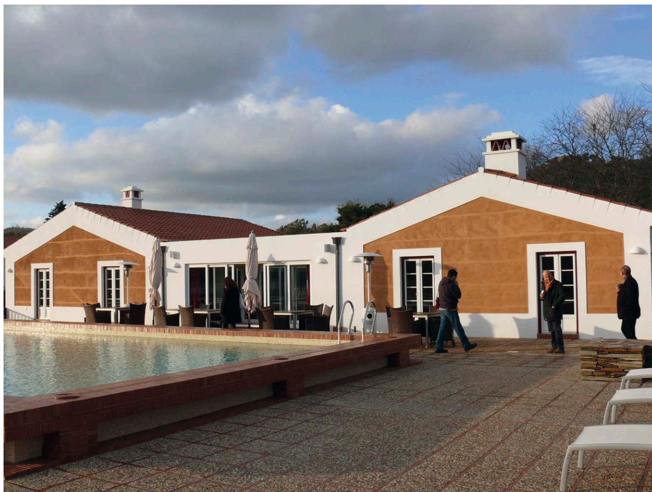
Fig. 8: Casa rural de tapia en Portugal, autoconstructor Rui Graça. Fotografía de Hubert Guillaud, CRAterre
