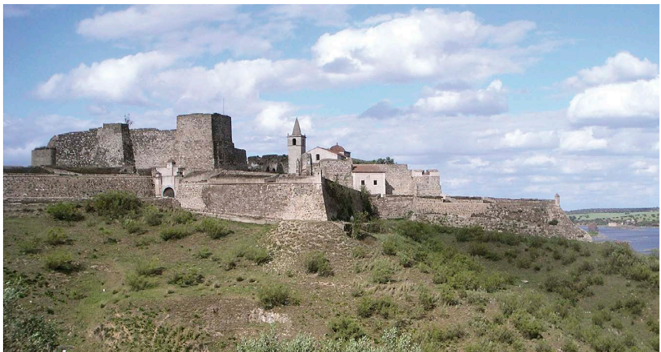
Fig. 1: Fortaleza de Juromenha, vista de Poniente
