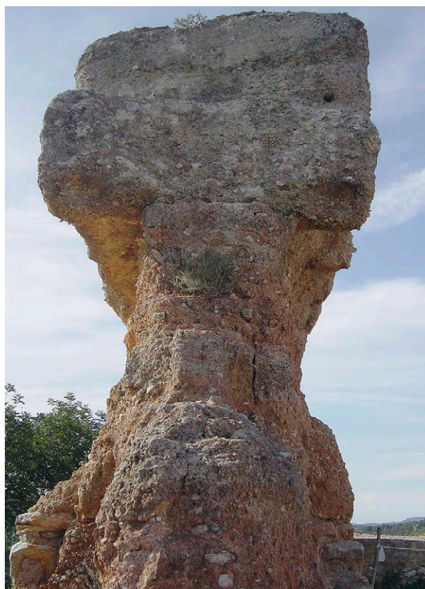
Fig. 3: Pérdida significativa de sección resistente
