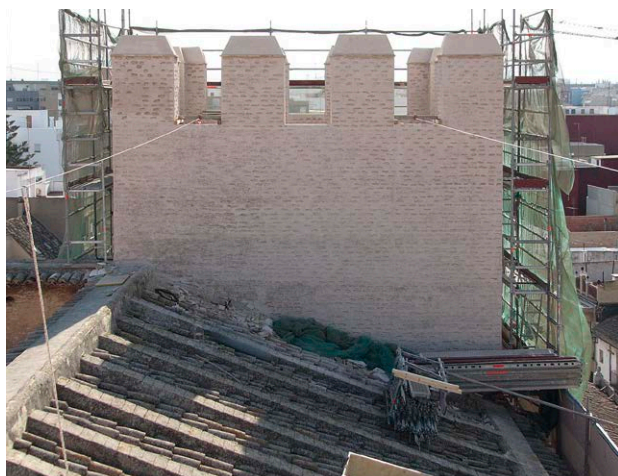
Fig. 9: Reconstrucción de la torre con tapia valenciana
