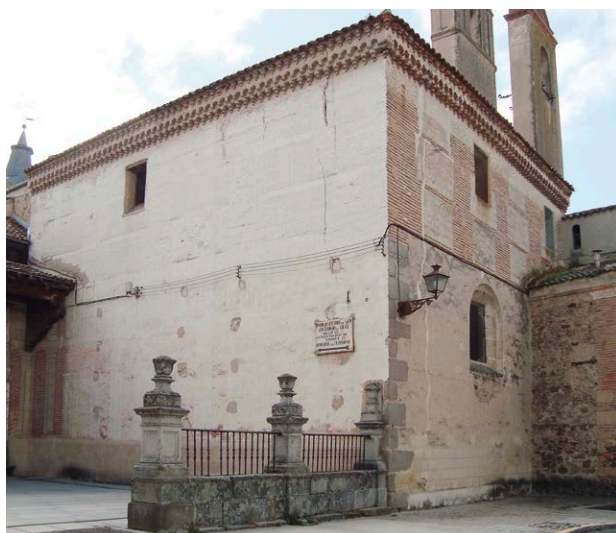
Fig. 22: Ejemplo de degradación a partir de los mechinales de las agujas (Alcázar de Jerez de la Frontera. Foto: L. García)
