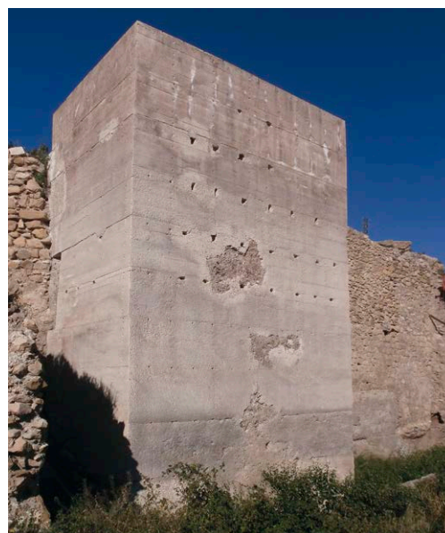
Fig. 6: Torre 6 tras su restauración
