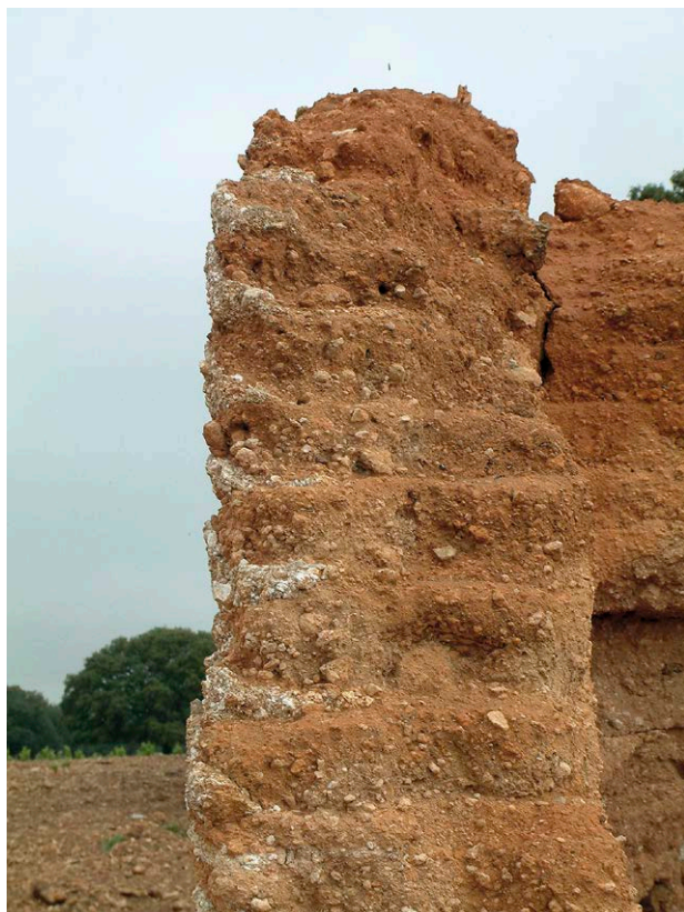
Fig. 8: Muro de tapia calicostrada (García Soriano)
