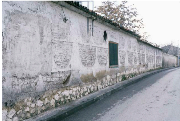
Fig. 05: Tapia simple de tierra en Valdeavero (Fondo ETSAM)
