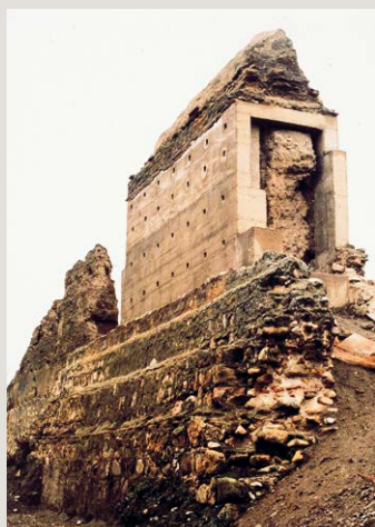
Fig. 2: Estado final tras la conclusión de los refuerzos estructurales. Otoño de 1987 (J.J. Ballesta)
