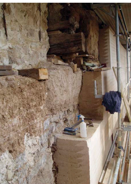
Fig. 7: Escalonado aparejado de tres hiladas sucesivas de tapia. La tapia de reintegración restituye el espesor original del muro, que trabaja como un cuerpo único, con un comportamiento funcional y estructural homogéneo
