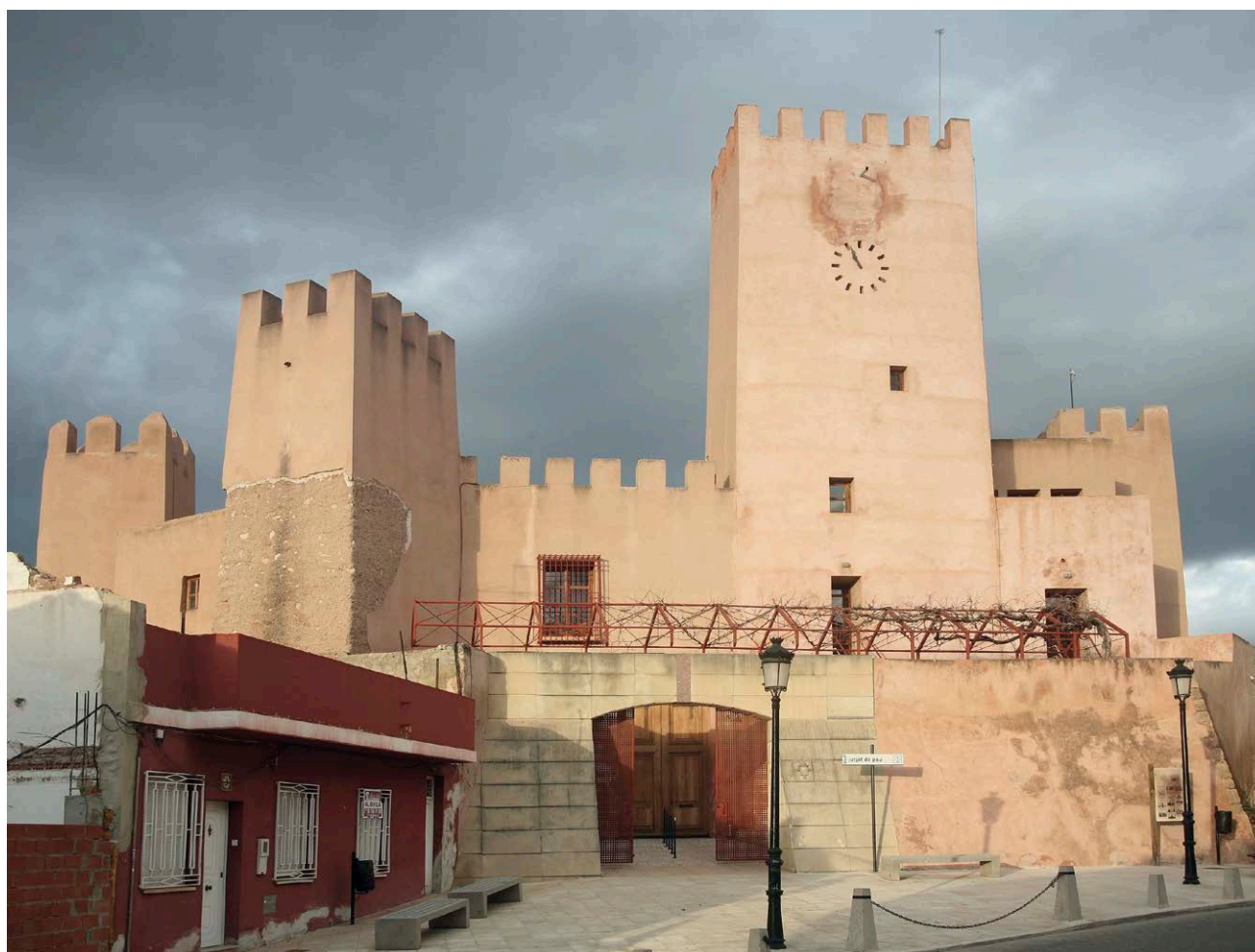
Fig. 11: Torre de Bétera. 1985-1989
