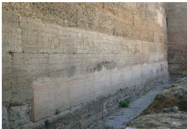
Fig. 6: Restauración del tramo de la Macarena (2008). Estado actual de las restituciones a una cara de tapia
