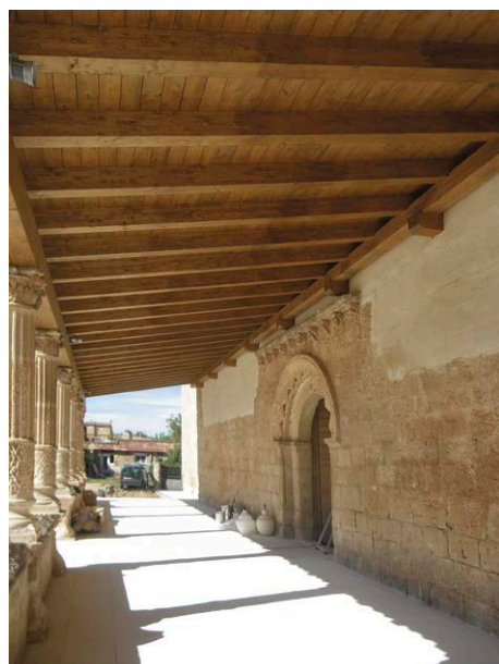
Fig. 7: Escalonado aparejado de tres hiladas sucesivas de tapia. La tapia de reintegración restituye el espesor original del muro, que trabaja como un cuerpo único, con un comportamiento funcional y estructural homogéneo
