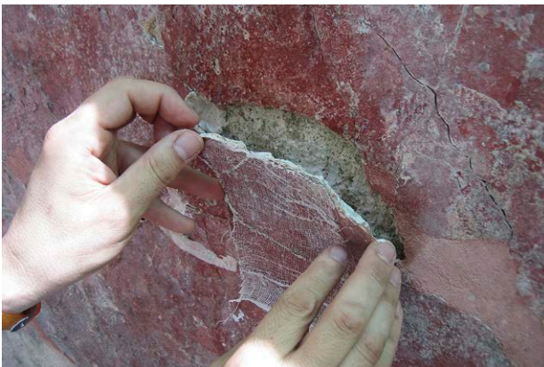
Fig. 19: Fragmento de revestimiento continuo sobre tapia. Castillo de Castril (Granada)
