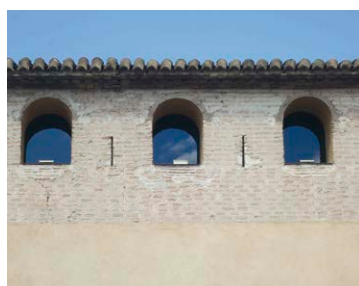
Fig. 5: Seminario del Patriarca, Valencia. Detalle de la loggia con ladrillos aplantillados (Cristini-Martella)
