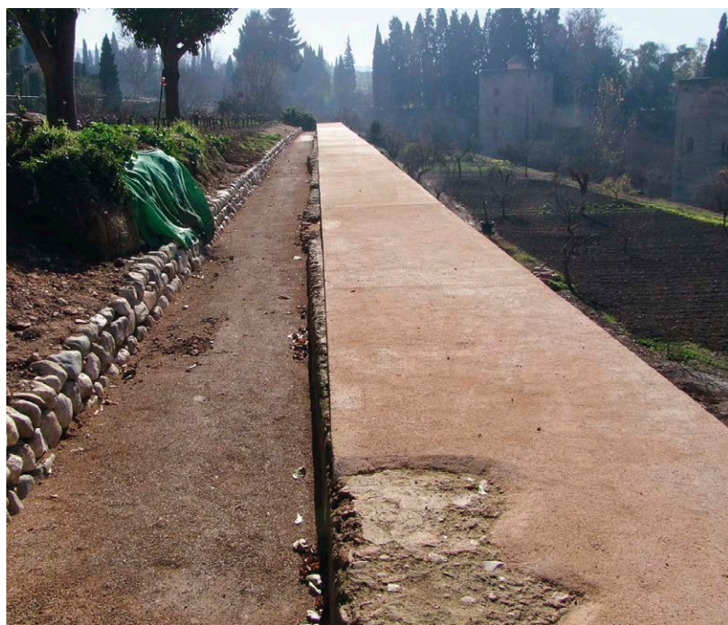
Fig. 15 y 16: Aspecto del muro al final de las obras
