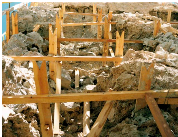
Fig. 1: La recreación de la agujas que sirvió de armadura (1995)
