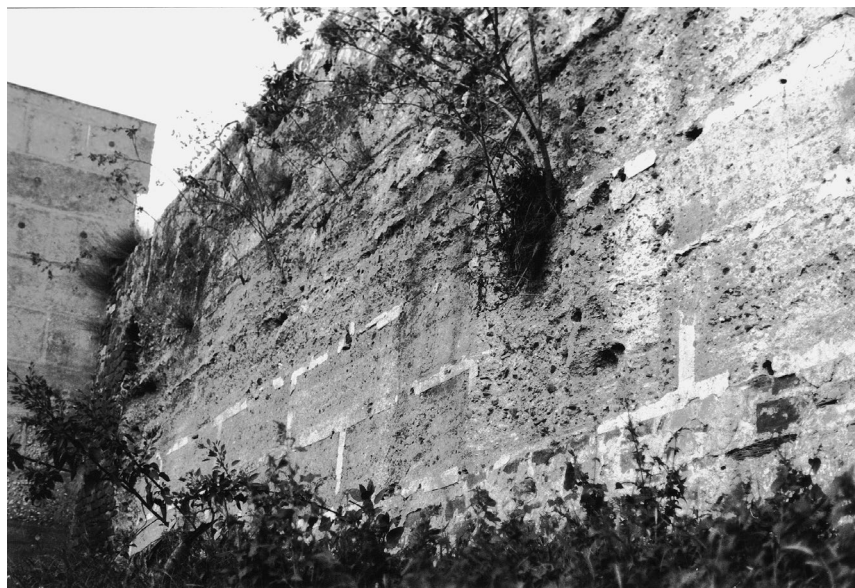
Fig. 5: Aspecto del paramento exterior de la muralla de la medina, orientada a noroeste, con sillería fingida (M. V. Gomes 1999)
