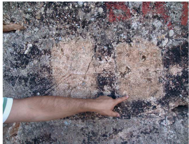
Fig. 6: Primeras pruebas de limpieza
