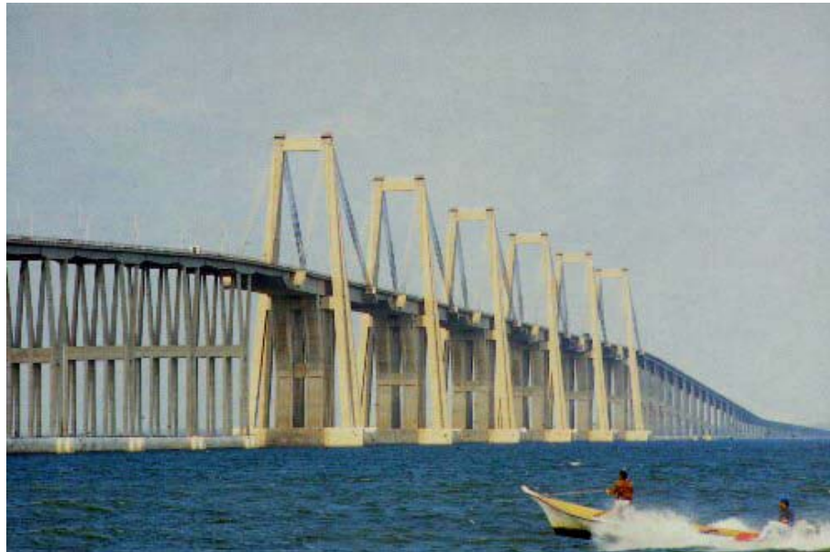
Figura 3: Vista Aérea del Puente General Rafael Urdaneta en Venezuela
