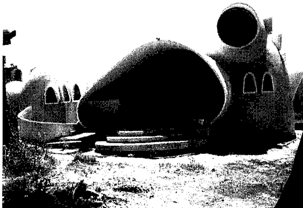
Foto 7. Vivienda poco convencional construida en ferrocemento.
