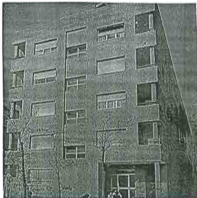
Figure 4.15 Fachada del edificio Marina Besós.
