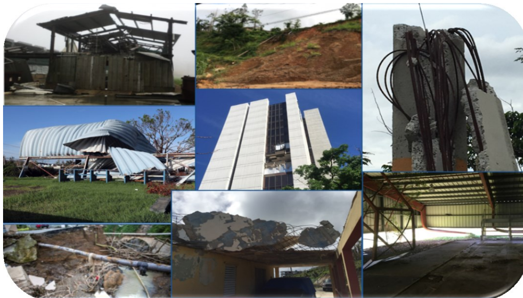
Figura 4: Ejemplos de daños producidos por el huracán María en Puerto Rico (Cruzado & Pacheco-Crosetti, 2018).
