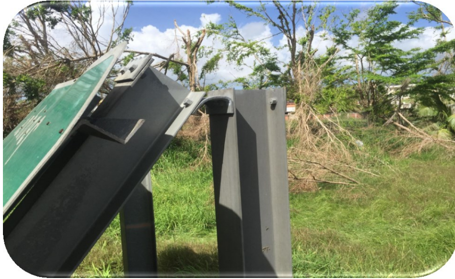
Figura 13: Ejemplo 2 – Cartel sobre carretera Puerto Rico 30, Km 7.8.
