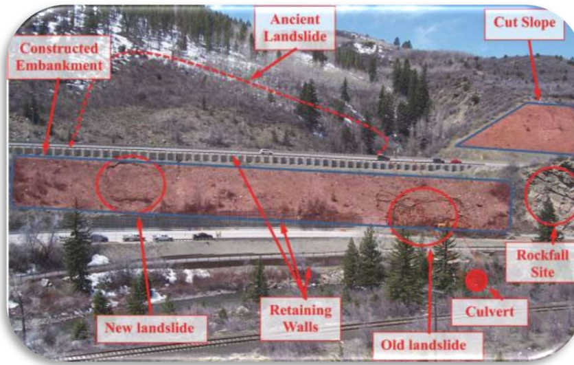
Figura 1: Activos geotécnicos (modificado de FHWA, 2013).
