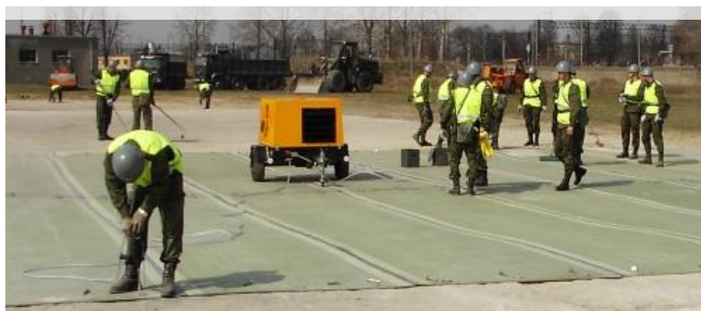
Rys.1 Kotwienie pokrycia ELP-1 KRATER do nawierzchni betonowej
