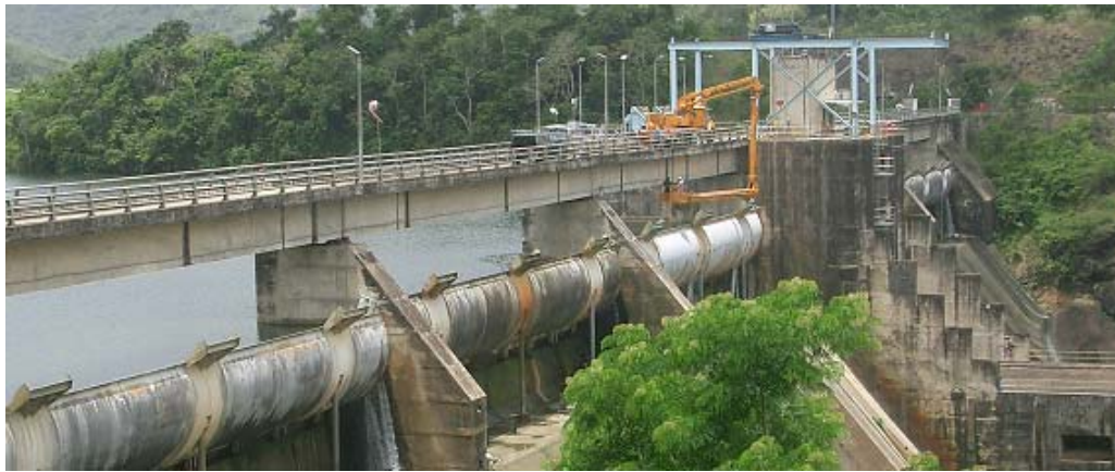
Figura 17: Instalación de los acelerómetros usando el carro con brazo mecánico.
