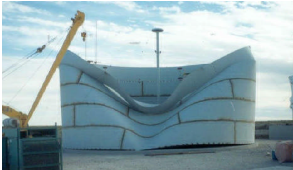
Figura 1: Estructura colapsada, en la que se aprecian las virolas y el levantamiento de parte de la soldadura entre el primer nivel y el fondo del tanque.
