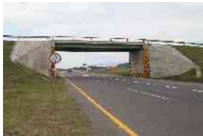
Foto 5: Losa/Viga, 3 Vigas. Paso Elevado Sur Tulua (Regional Valle).
