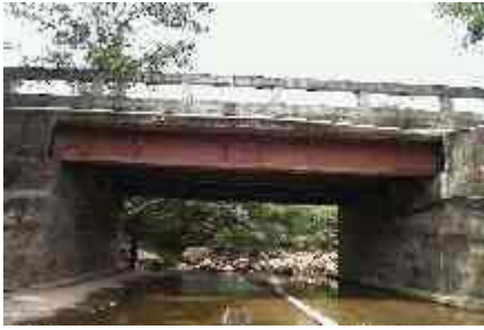
Foto 1: Losa/Viga, 4 o más Vigas. Puente Agua Blanca (Regional Norte de Santander).
