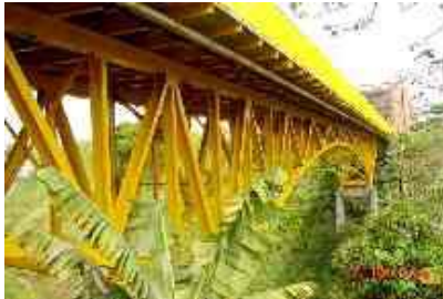
Foto 11: Arco inferior tipo abierto. Puente la Florida (Regional Quindío).
