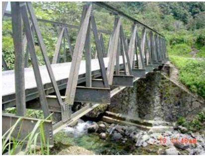
Foto 9: Provisional Tipo Callender. Puente El Barbudo (Regional Choco).
