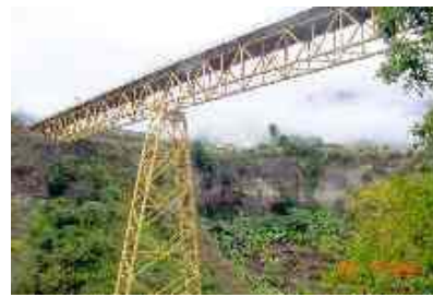
Foto 6: Armadura de paso superior. Puente Cajamarca (Regional Tolima).
