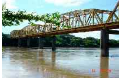
Foto 3: Armadura de paso inferior. Puente Salgar (Regional Tolima).
