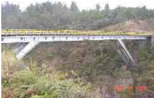
Foto 13: Pórtico Sección variable. Puente Sigsa (Regional Cundinamarca).
