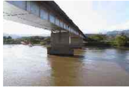
Foto 10: Trabe Cajón, 2 o más cajones. Puente Guillermo León Valencia (Regional Río Cauca - Valle).
