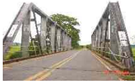
Foto 2: Armadura de paso a través. Puente Bodoquero (Regional Caquetá).
