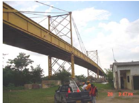
Foto 14: Puente Atirantado. Gambote (Regional Bolívar).
