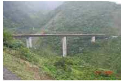
Foto 4: Losa/Viga 2 Vigas. Puente Chirajara (Regional Meta).
