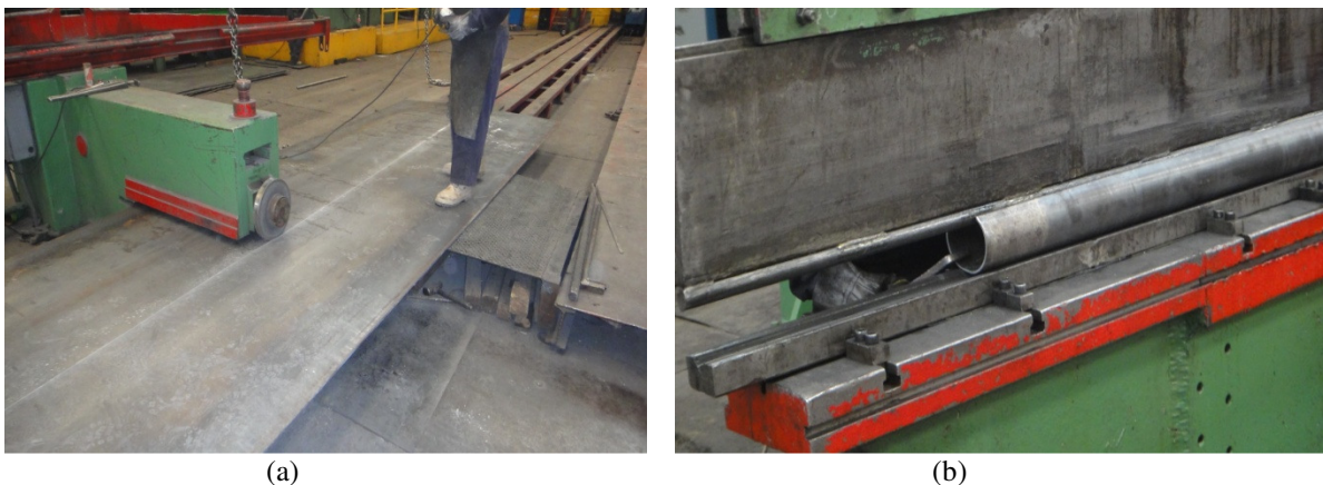
Figura 3: Detalles de la práctica en México para la fabricación de postes de acero: a) Detalle del corte de la placa; b) Moldeado del poste con prensa hidráulica.
