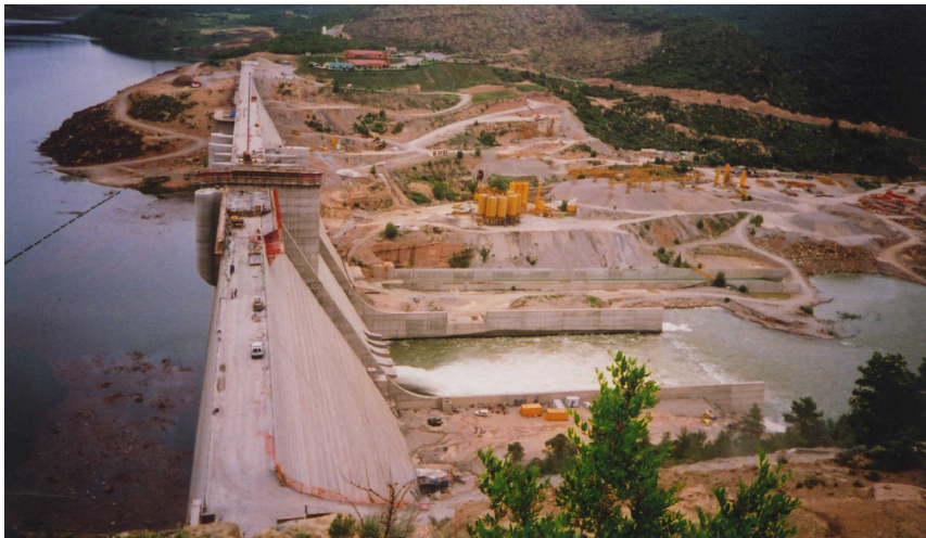
Figura 5.1: Presa de Rialb (LLeida)
